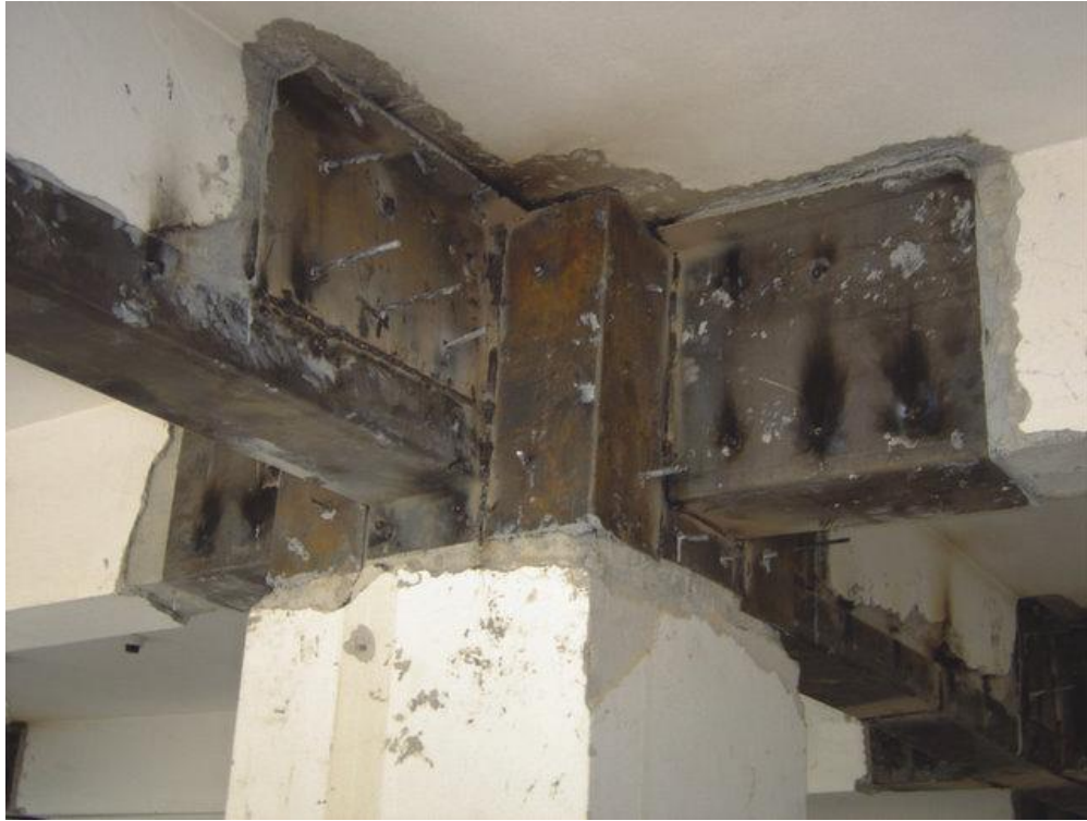
Şekil 3.30. Düğüm noktasına çelik levha ile sarılması
