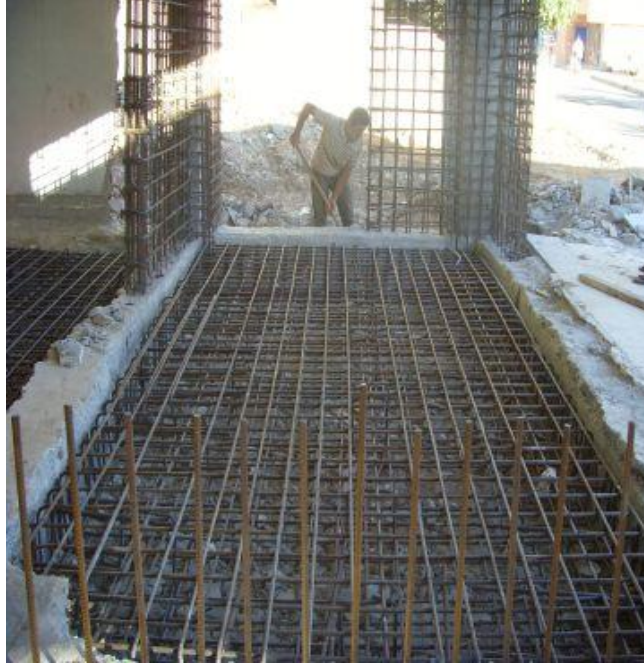
Şekil 3.42. Perde güçlendirilmesi için yapılan temel güçlendirme işlemi
