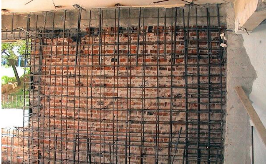
Şekil 3.44. Bölme duvar güçlendirmesi
