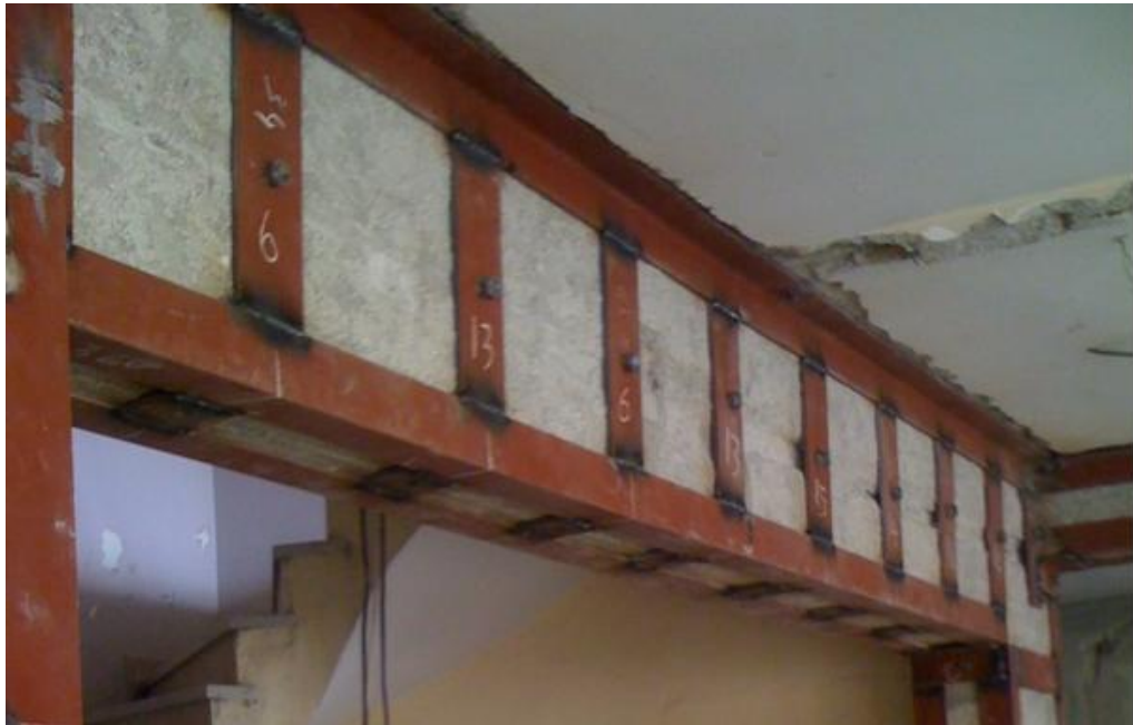
Şekil 3.24. Çelik profillerle güçlendirilmiş kiriş
