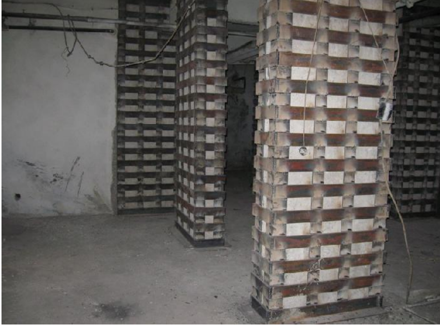
Şekil 3.18. Kolonların çelik ile sarılması
