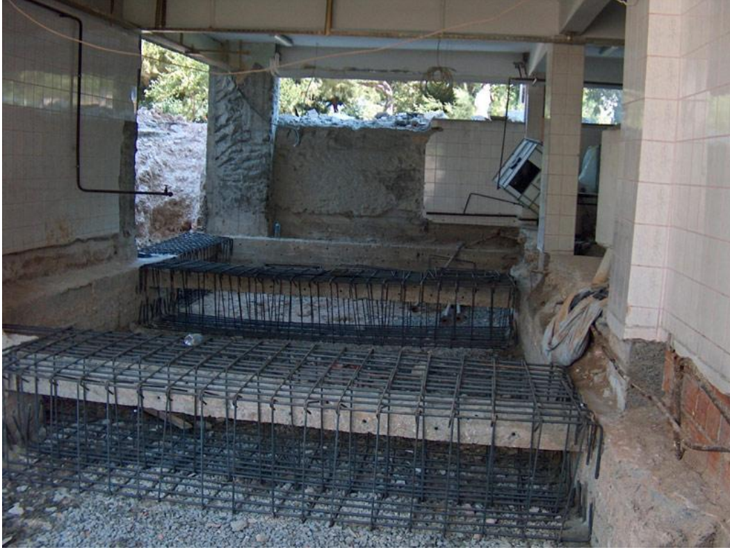
Şekil 3.38. Temellerin güçlendirilmesi
