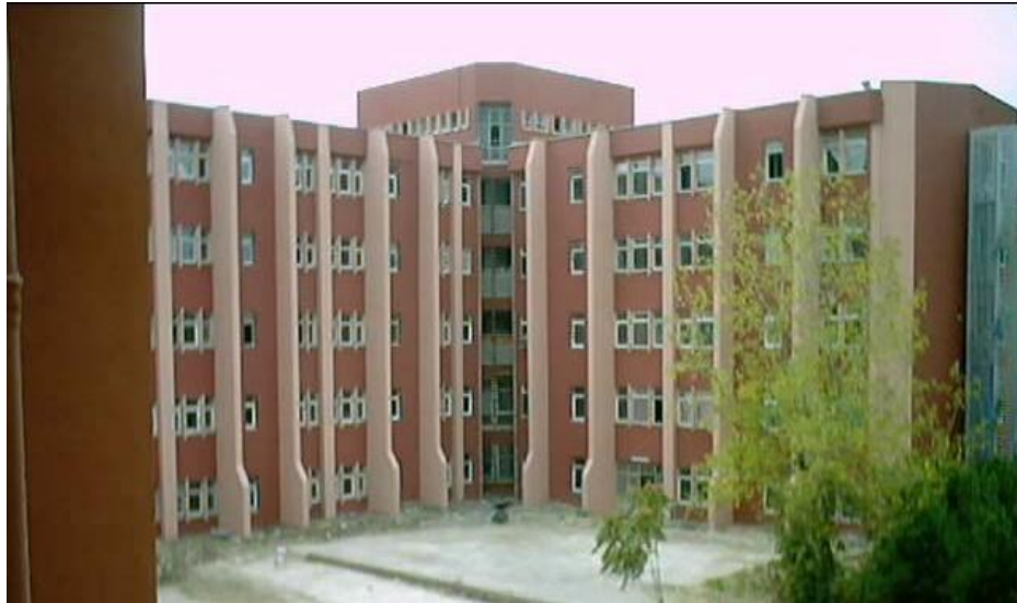
Şekil 3.52. Yapıya payandalar eklenmesi (Yıldırım 2008)
