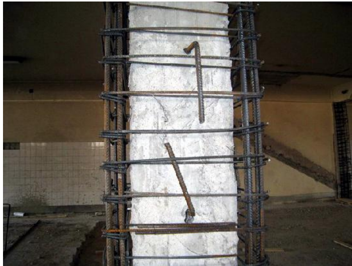
Şekil 3.20. Mantolamada donatı uygulaması
