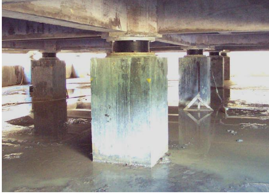
Şekil 3.53. Sismik izolatör
