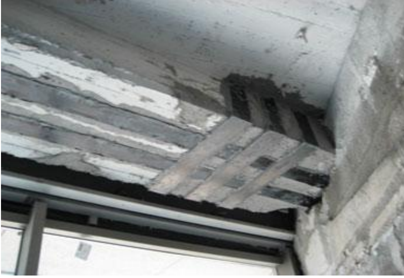
Şekil 3.28. Kirişte lifli şerit kullanımı
