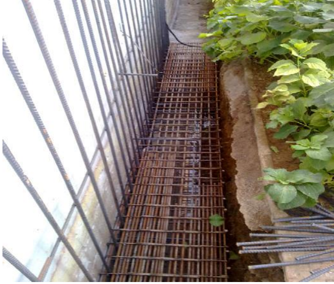
Şekil 3.50. Yapıya dıştan perde eklemek için münferit temel imalatı
