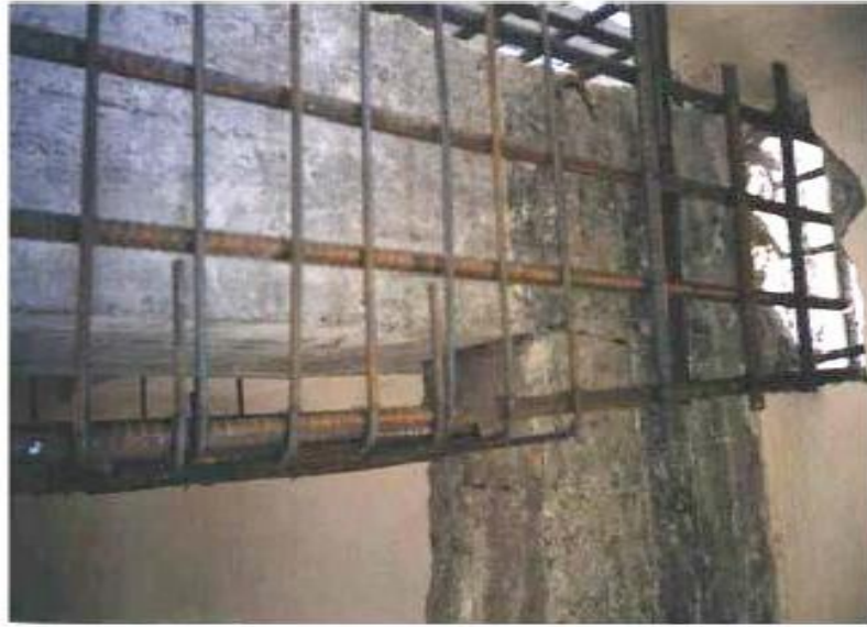
Şekil 3.26. Kiriş mantolanmasında donatılarda sürekliliğin sağlanması (Yıldırım 2008)
