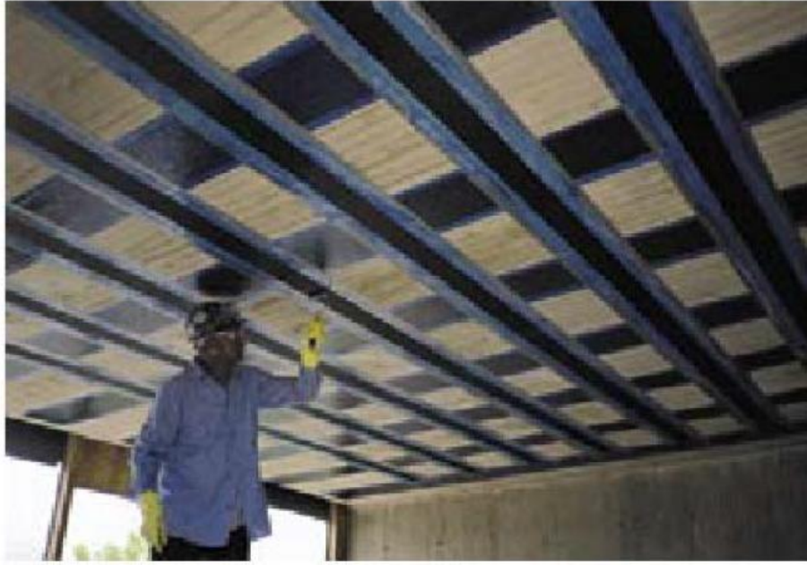
Şekil 3.37. Lifli Polimerin döşemelerde uygulanması (Siphaioğlu 2006)
