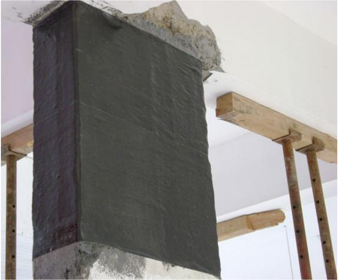
Şekil 3.22. Lifli polimer uygulanan kolon
