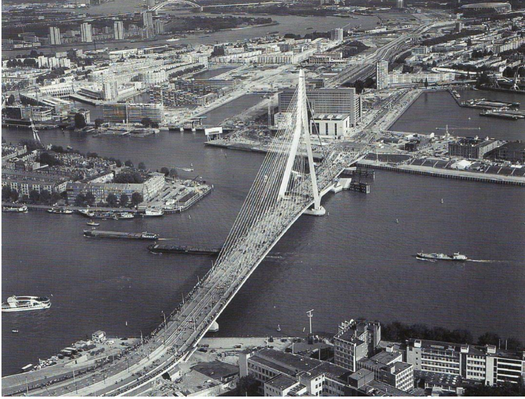
Şekil 2. 11 İki Yakayı Birleştiren Erasmus Köprüsü
