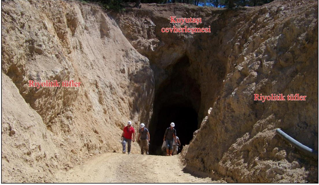
Şekil 3.3 Kuru Pb-Zn yatağında gözlenen Kuyutaşı cevherleşmesine ait galeri girişi.
