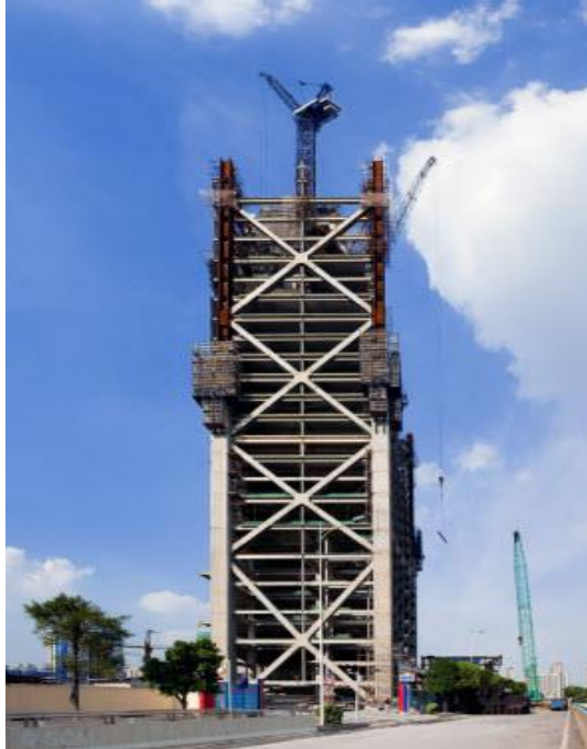
Resim 5.32. Pearl River Tower, taşıyıcı sistem yüzey ilişkisi [İnternet: “Pearl River”].
