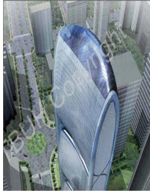
Şekil 5.28. Pearl River Tower, bina bitimi üzerinde pv paneller [Frechette ve Gilchrist, 2009], [Gilchrist, 2009].
