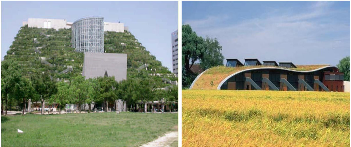
Resim 4.8. Çeşitli yeşil çatı uygulamaları a. Fukuoka Prefectural International Hall, Emilio Ambasz, Fukuoka, 1990[Anonim, 2005] b. Montessori Perspektif [Gonzalo, 2006]
