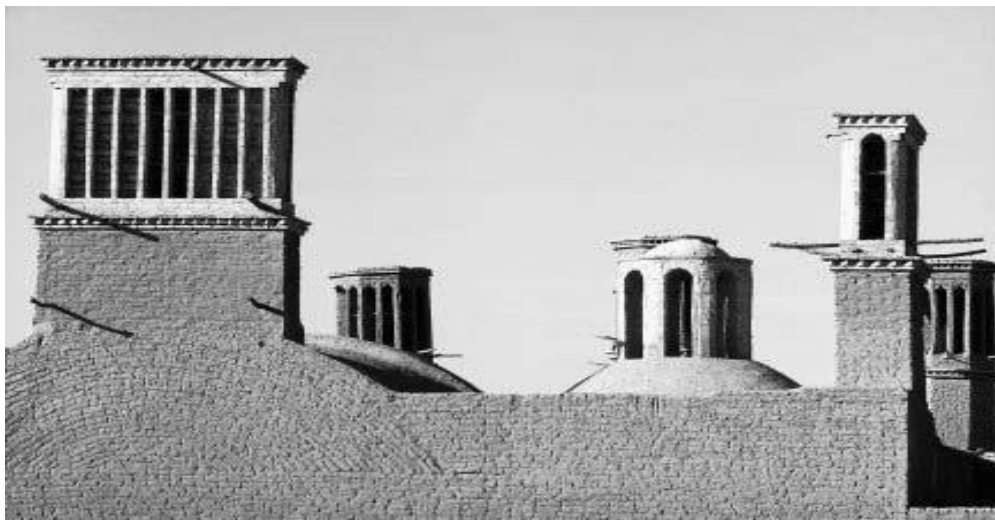
Resim 4.13. Rüzar bacaları, Yazd [Roaf vd., 2001 ].
