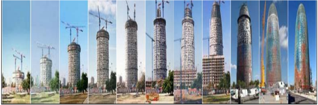
Resim 5.28. Torre Agbar, inşaat evreleri [Uçan, 2008].
