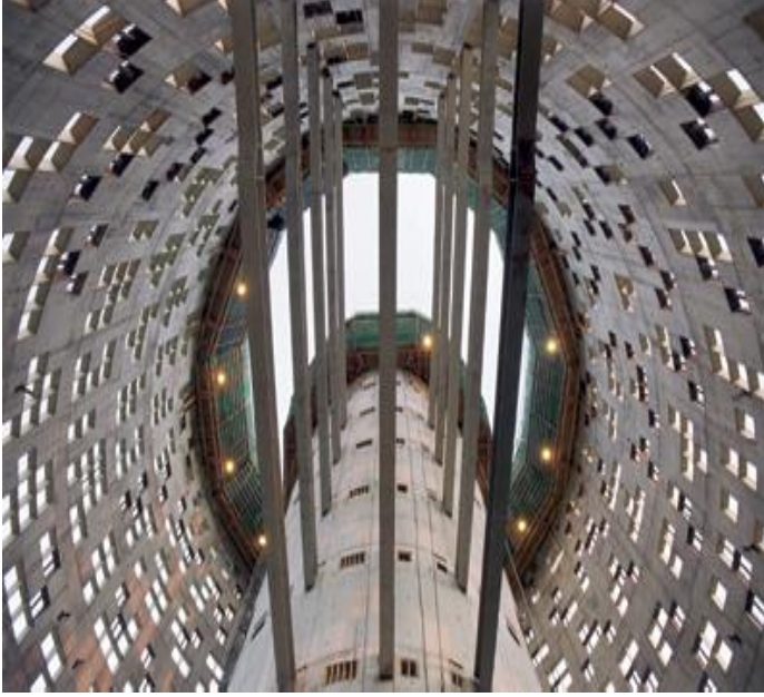
Resim 5.26. Torre Agbar, iç yapısı çekirdek ilişkisi [İnternet: “Torre Agbar”].
