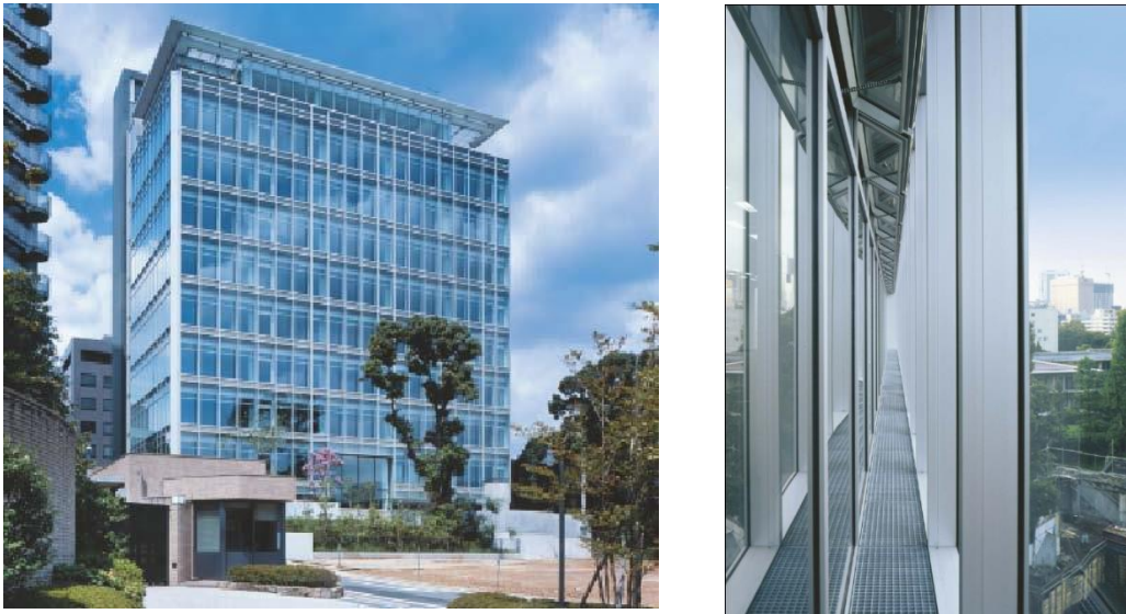
Resim 4.39. Sekisui Ofis Kulesi, Tokyo, çift kabuklu yüzey [Bauer vd., 2007].
