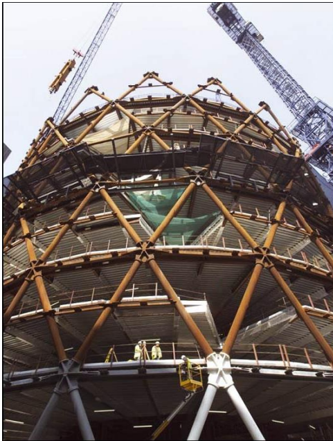
Resim 5.14. Swiss Re Tower, dış çatkısı [Gregor, 2003].
