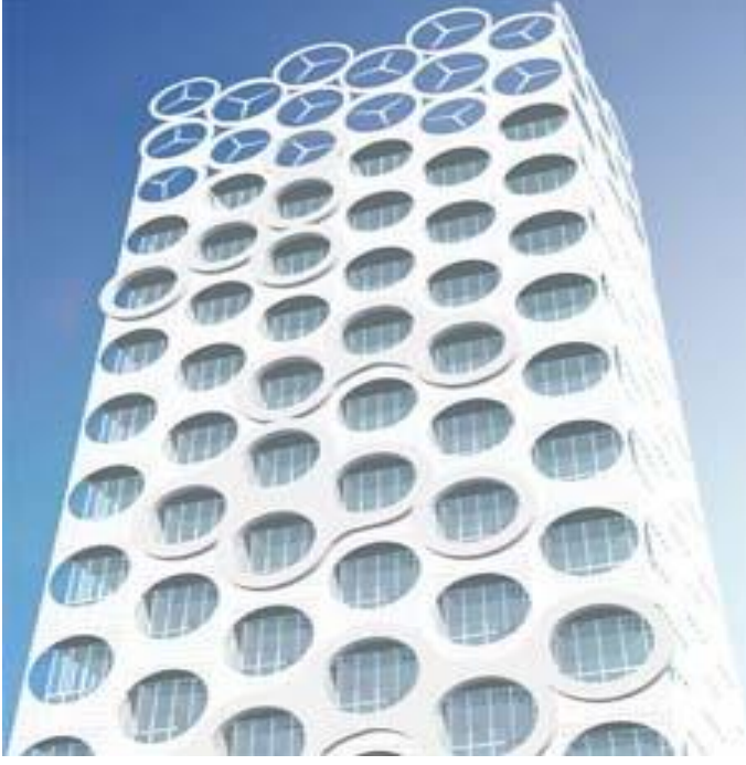
Şekil 5.31. COR kulesi rüzgar türbinleri [Gangal, 2012].
