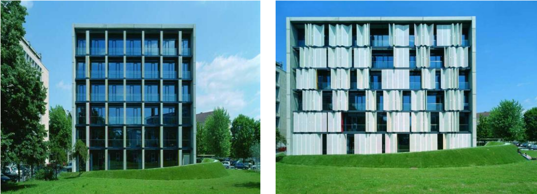
Resim 4.21. Hareketli yüzey örneği, Biocatalysis Lab Binası [İnternet “Dynamic Facade”].
