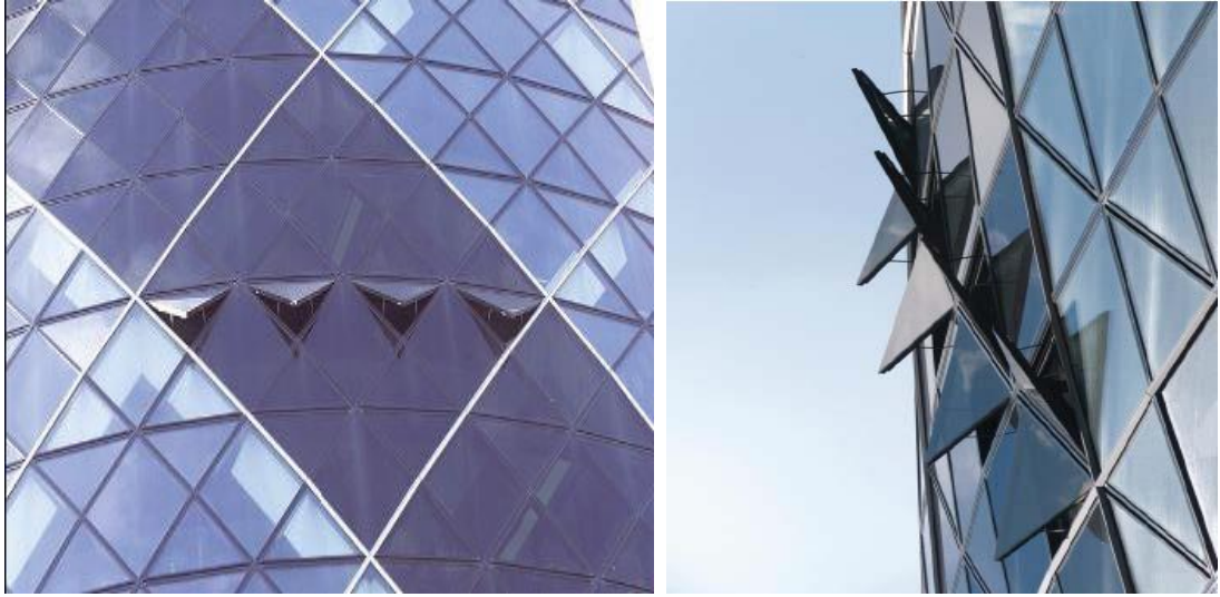
Resim 5.8. Swiss Re binası, doğal havalandırma sistemi [Compagno-2, 2002].
