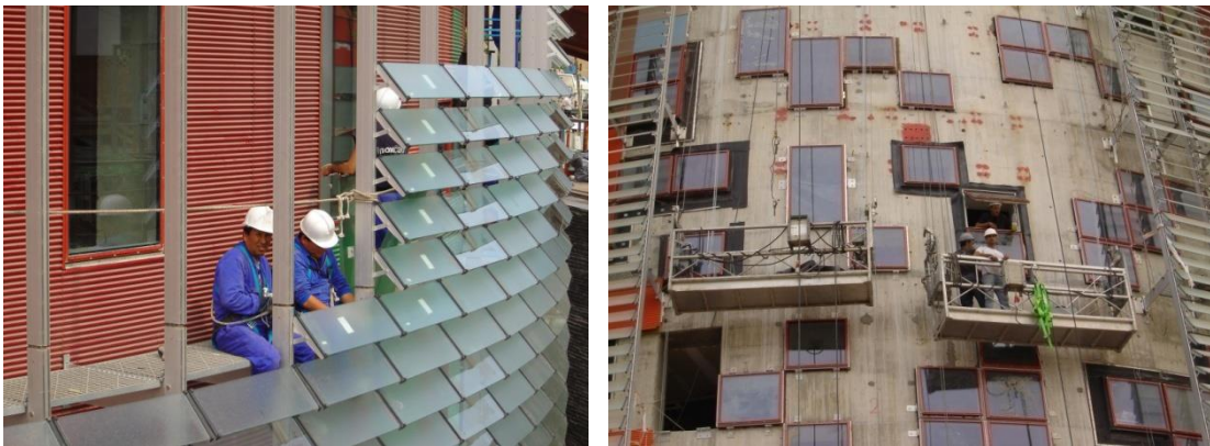
Resim 5.24. Torre Agbar, dıştan güneş kırıcı elemanların görünümü [Cilento, 2010].
