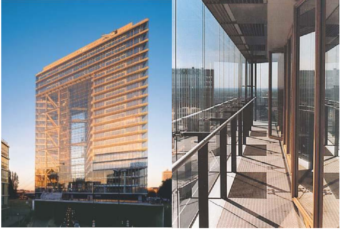
Resim 4.38. Duesseldorf City Gate , çift kabuklu yüzey [Bauer vd., 2007].
