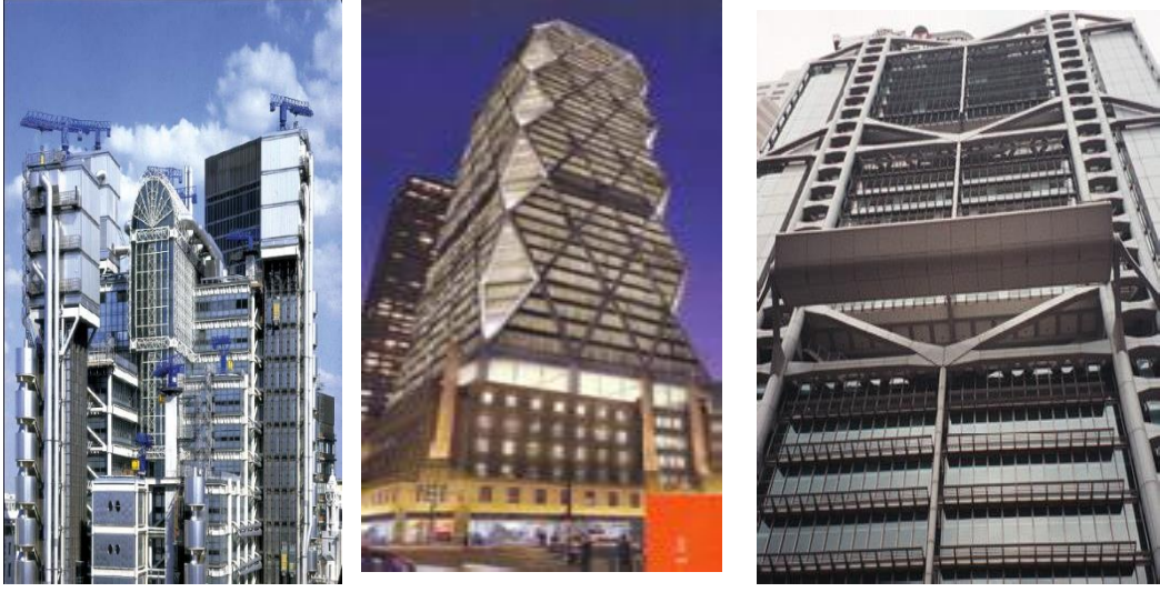
Resim 4.43. Taşıyıcı sistemin açık görüldüğü yapılar, a. Lloyd's of London [Uçan 2008], b. Hearst Tower [Höweler, 2003] c. Hong Kong Bank [Erkekel, 2006]
