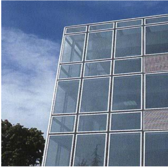
Resim 4.34. Cam ünitenin ara boşluğunda yer alan delikli, sabit alüminyum lamelli entegre güneş kontrol elemanları [Gür, 2007].
