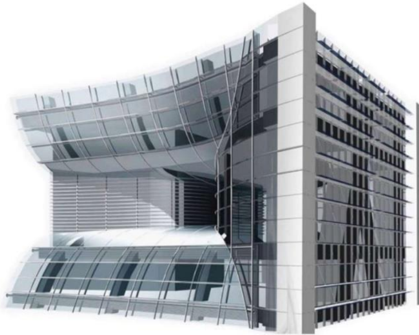
Şekil 5.15. Pearl River Kulesi'nde kullanılan rüzgar türbin için yapının aldığı form [Frechette ve Gilchrist, 2009].
