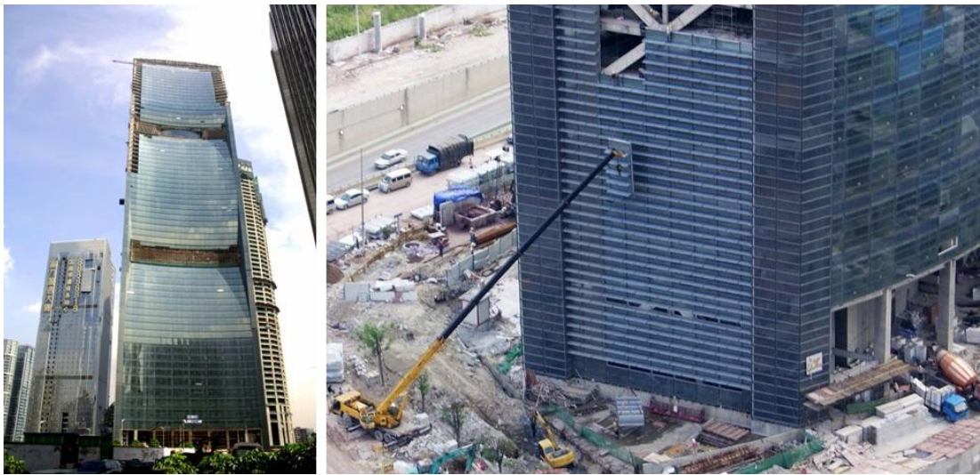
Resim 5.31. Bina batı yüzeyine yerleştirilen fotovoltaik paneller ile oluşturulan güneş ekranı [İnternet : “Pearl River”].
