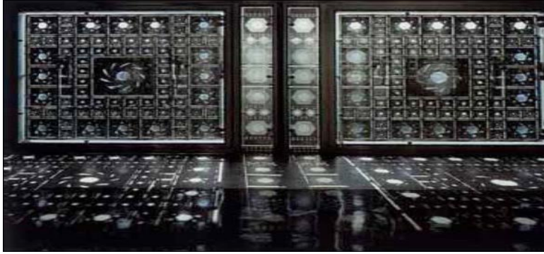
Resim 4.35. Paris Arap Enstitüsü yüzey diyafram mekanizmaları [Compagno, 2002].
