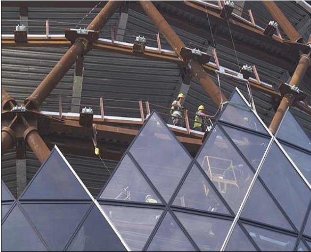
Resim 5.2. Swiss Re Tower, yüzey panelleri [Erkekel, 2006].
