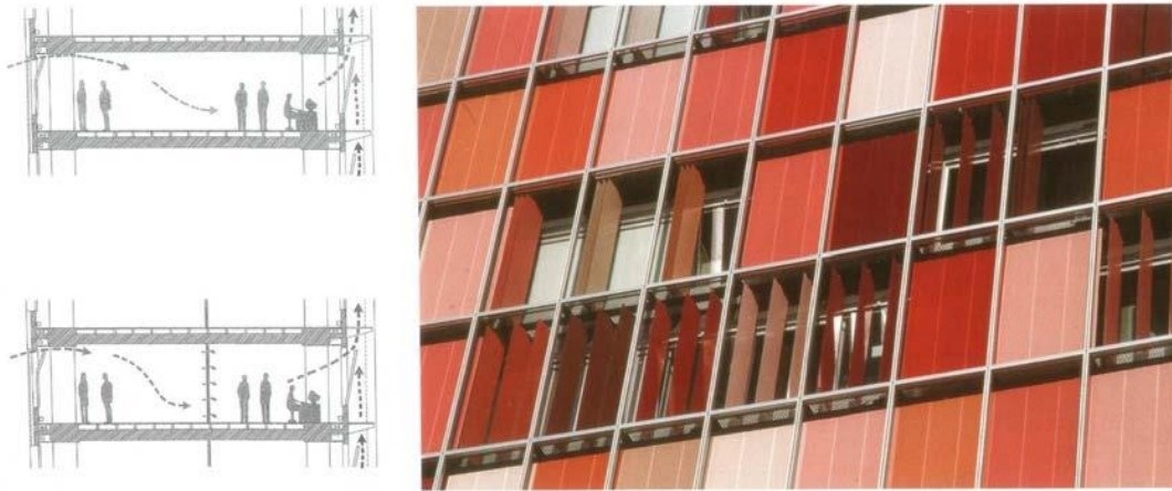
Resim 4.41. GSW Binası, Berlin, Doğal baca etkisi ile batı yüzeyindeki boşlukta yükselen sıcak hava alçak basınç yaratarak doğu yüzeyinden temiz havanın içeri çekilmesini sağlıyor [Gür, 2007].
