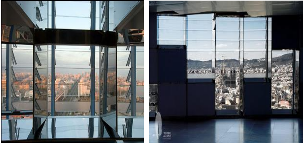
Resim 5.23. Torre Agbar, içten güneş kırıcı elemanların görünümü [Uçan, 2008].
