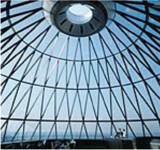
Resim 5.9. Swiss Re Londra Merkez Binası, iç avlu üstü merkezi kontrollü üçgen pencereler [Foster, 2004].
