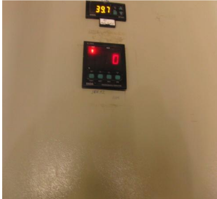
Şekil 3.8 Kırıcıların anlık olarak sürekli değişen amper göstergesi.
