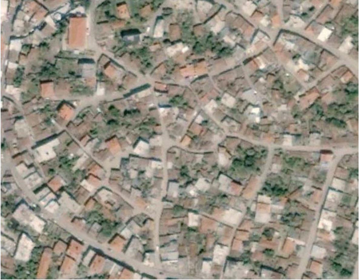
Şekil 4.27 Lapseki geleneksel kent dokusu örneği, 2013
