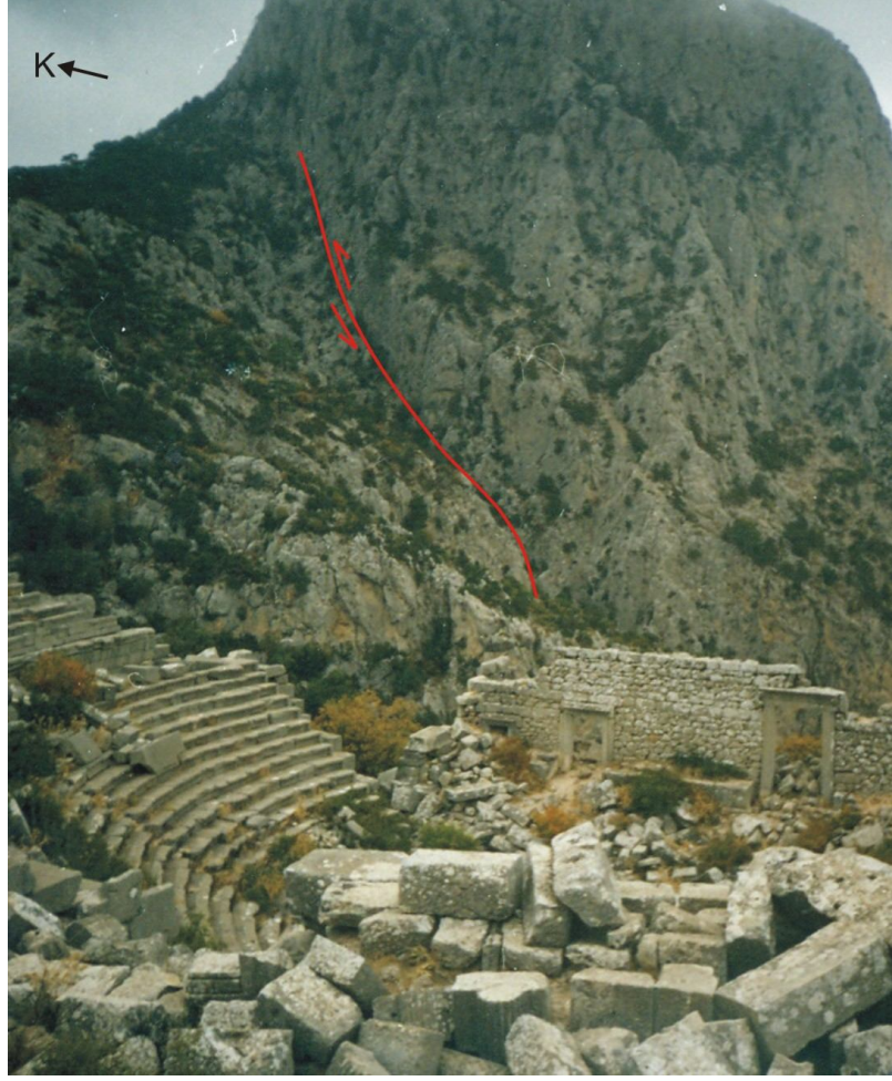
Şekil 4.61. Tiyatro duvarında sismik etki ile oluşmuş yıkılmalar
