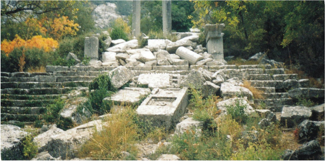
Şekil 4.62. Mezar anıtında sismik etki ile oluşmuş yıkılmalar
