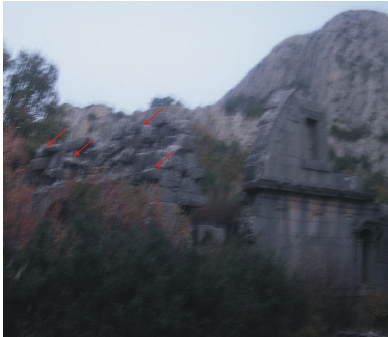
Şekil 4.57. Hamamda sismik etki ile oluşmuş duvar parçalarının dönüş hareketi
