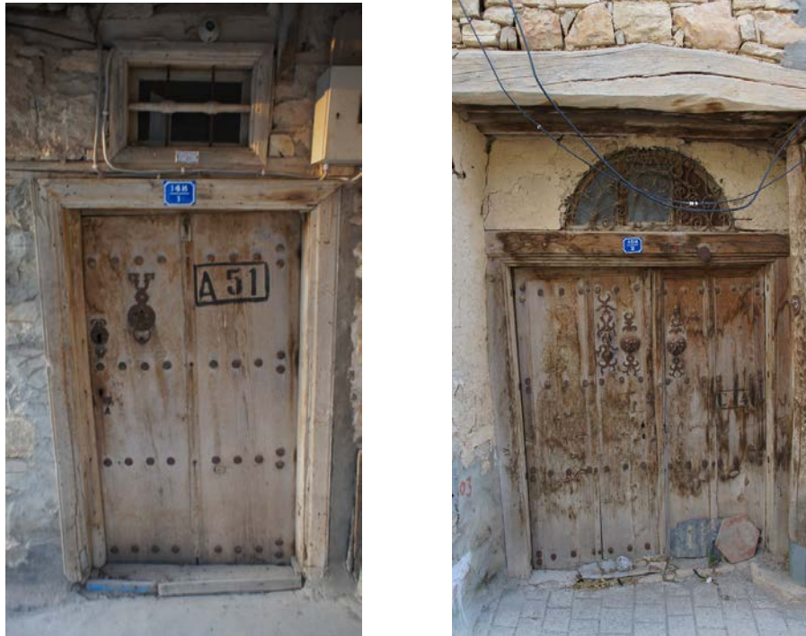
Şekil 5. 38 Ana giriş kapısı ve ahır kapısı örnekleri, 252-3 ve 258-10 yapıları
