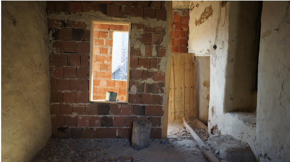
Şekil 6. 7 İç mekanda tuğla malzemeyle yapılan bölme duvar, 257-31 yapısı
