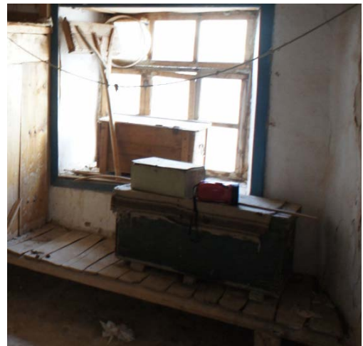
Şekil 5. 29 Ahşap sedir örnekleri, 257-19 ve 264-13 yapıları
