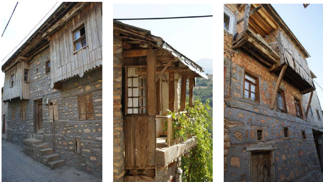
Şekil 5. 41 Çıkma örnekleri, 259-5, 262-52 ve 264-1 yapıları
