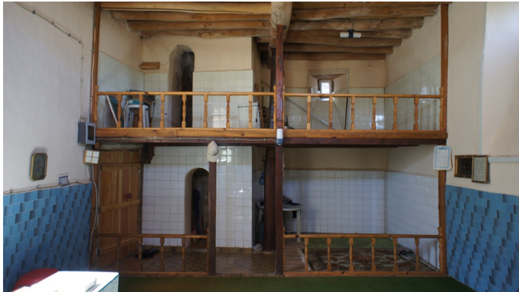
Şekil 3.27 Orta Cami fayans kaplı kuzey duvarının görünümü
