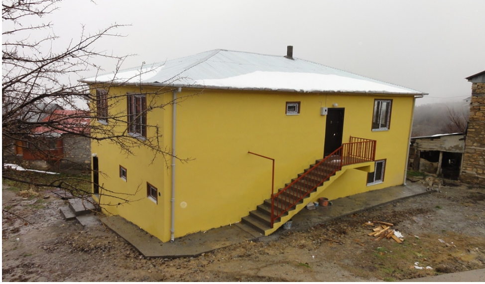
Şekil 3.10 Yeni köy evi binası
