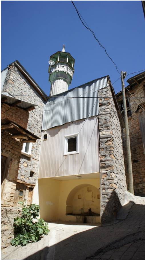
Şekil 3. 30 Müftüoğlu Cami'sinin Güneydoğu Cephesi (2012)
