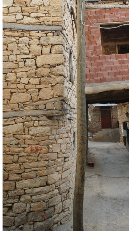
Şekil 5. 36 Pahlı yapı köşeleri örnekleri, 263-2 ve 257-31 yapıları
