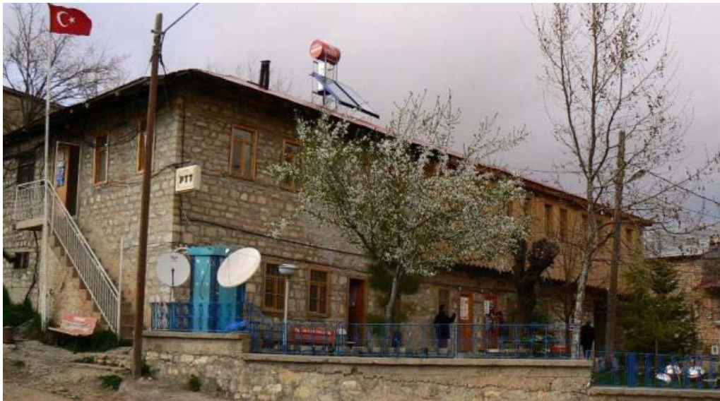
Şekil 3. 5 Köy konağının onarım sonrası görünümü [1]
