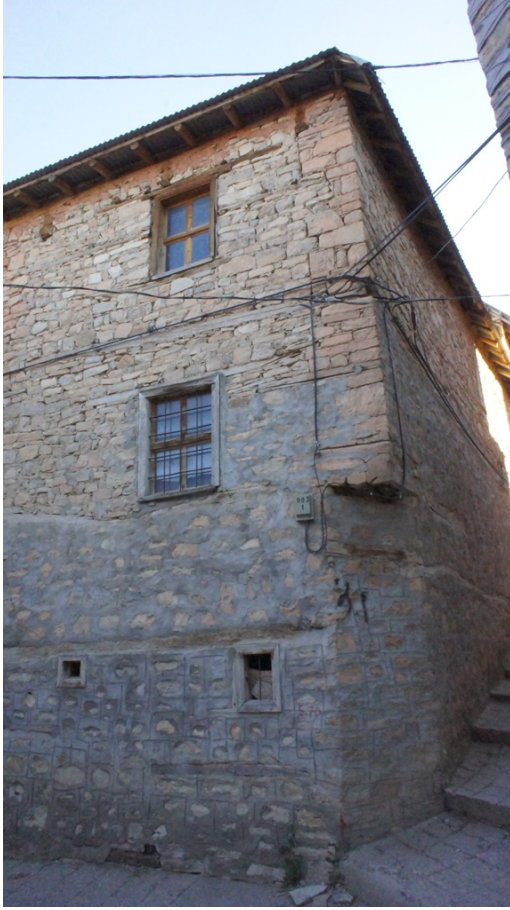
Şekil 5. 36 Pahlı yapı köşeleri örnekleri, 263-2 ve 257-31 yapıları
