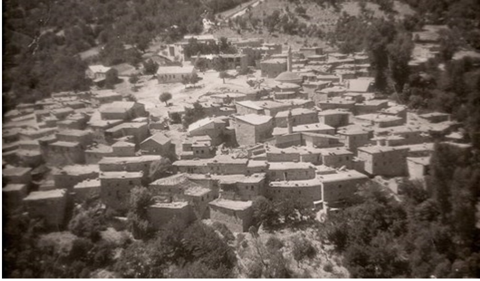
Şekil 6. 2 Yapıların özgün düz toprak dam üst örtülerin 1979 yılındaki görünümü [7]
