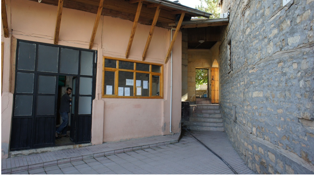
Şekil 3.15 Son cemaat yeri giriş kapısının avludan görünümü
