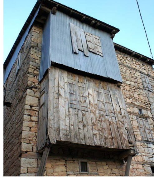
Şekil 6. 9 Kaplama malzemeleri değiştirilmiş çıkmalar, 261-40 ve 259-11 yapıları
