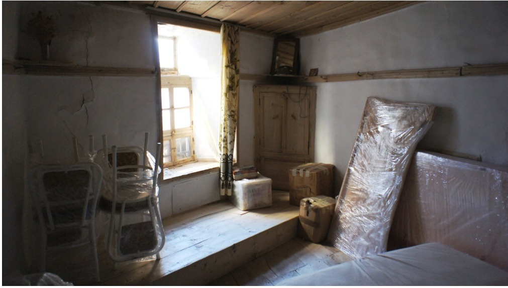
Şekil 5. 30 Raf silmesine örnek, 257-19 yapısı
