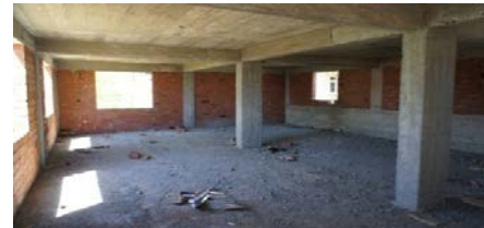
İÇ MEKAN GÖRÜNÜMÜ
