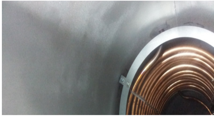
Şekil 5.5: Sıcak su depolama tankın iç kısmı
