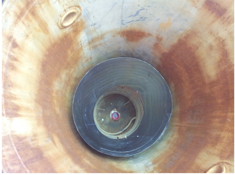
Şekil 6.164: Yönlendirici koni tip depo içinde
