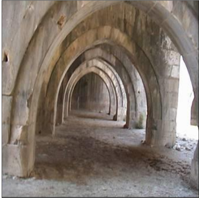
Şekil 3.19. İncirlihan kervan sarayı'nın iç görünüşü
