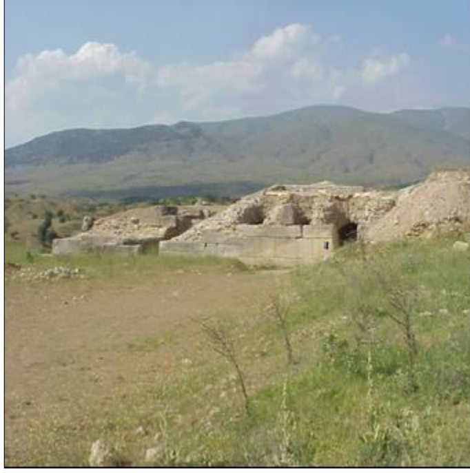
Şekil 3.11. Antiokya - hamamın dıştan görünüşü
