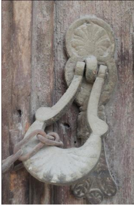
Şekil 149. Gazi Kemal Mahallesi Hacı Ethem Sokak No:3
