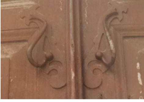
Şekil 164. Gazi Kemal Mahallesi İmam Hasan Sokak No: 18
