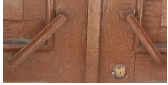
Şekil 159. Gazi Kemal Mahallesi İmam Hasan Sokak No: 12
