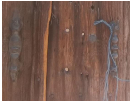
Şekil 156. Turan Mahallesi 1308 Sokak No: 03
