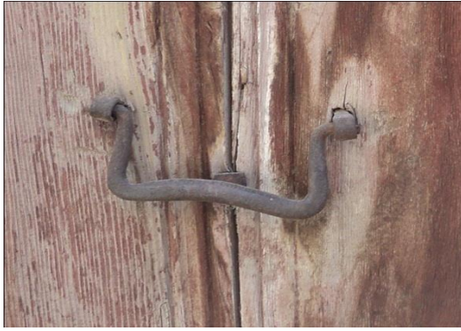
Şekil 77. Gazi Kemal Mahallesi Hacı Ethem Sokağı - no:4 (Alav, 2012)
