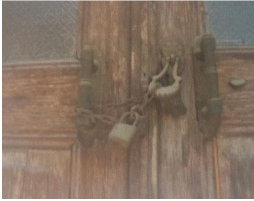
Şekil 91. Gazi Kemal Mahallesi Akar Çeşme Sokak No: 03 (Demirci, a.g.e., s. 187.)
