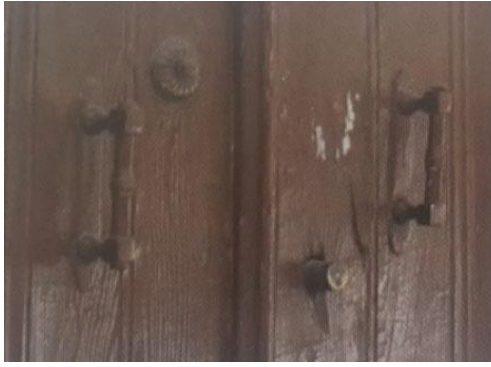
Şekil 154. Gazi Kemal Mahallesi İmam Hasan Sokak No: 06
