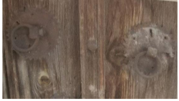
Şekil 165. Çelebiler Mahallesi Damgacı Sokak No: 22
