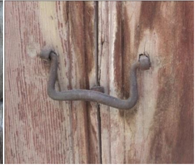
Şekil 148. Gazi Kemal Mahallesi Hacı Ethem Sokak no:4
