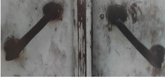
Şekil 160. Karaağaç Mahallesi 1210/1 Sokak No: 04
