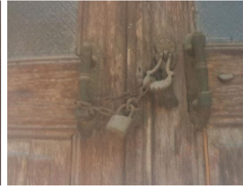
Şekil 155. Gazi Kemal Mahallesi Akar Çeşme Sokak No: 03
