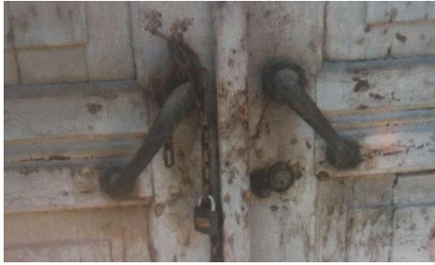
Şekil 97. Gazi Kemal Mahallesi 1308 Sokak No: 70 (Demirci, a.g.e., s. 188.)
