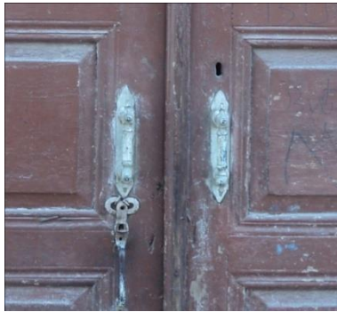
Şekil 150. Gazi Kemal Mahallesi Hacı Ethem Sokak no:2
