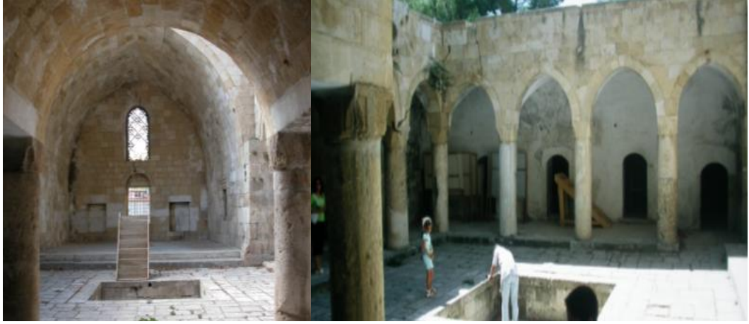
Şekil 107. Ermenek Tol Medrese, Avlu, Eyvan, Revakların Görünüşü, 1339-1340 (Şaman Doğan, Bilget Fataha 2011: 102)
