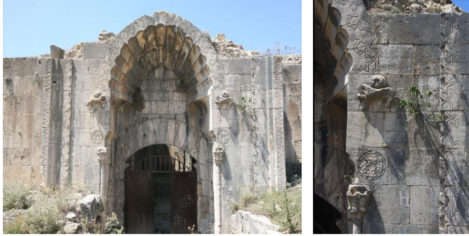
Şekil 116. Burdur İncir Hanı Taç Kapı Mekik Bordür Süslemesi (1239-40) (Burdur Kültür Müdürlüğü, 2013).
