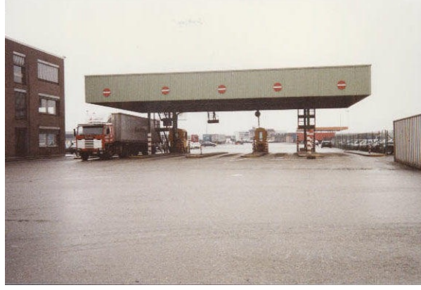
Şekil 3.11: Konteyner Terminali Giriş/Çıkış Kapısı
