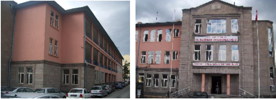
Şekil 2. 7627. Yapının günümüzdeki durumu
