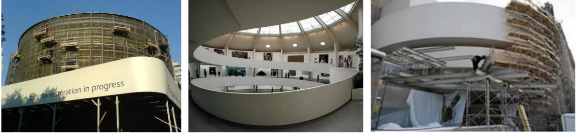
Şekil 3. 35. Restorasyon aşamasında görseller [158]
