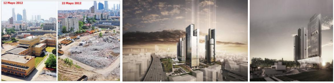
Şekil 5. 49. Mecidiyeköy Likör Fabrikası yıkım ve yeni projenin fotoğrafları 1,2: [247] 3.4: [248]
