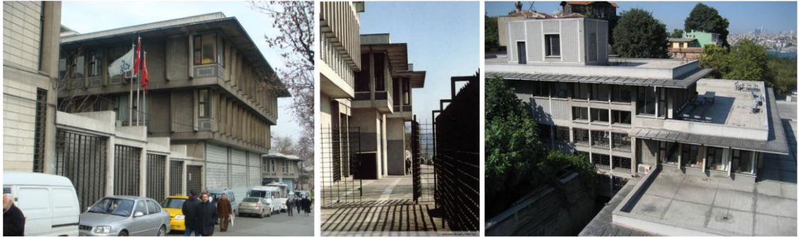
Şekil 3. 53. Yapıların günümüzdeki durumu [191]
