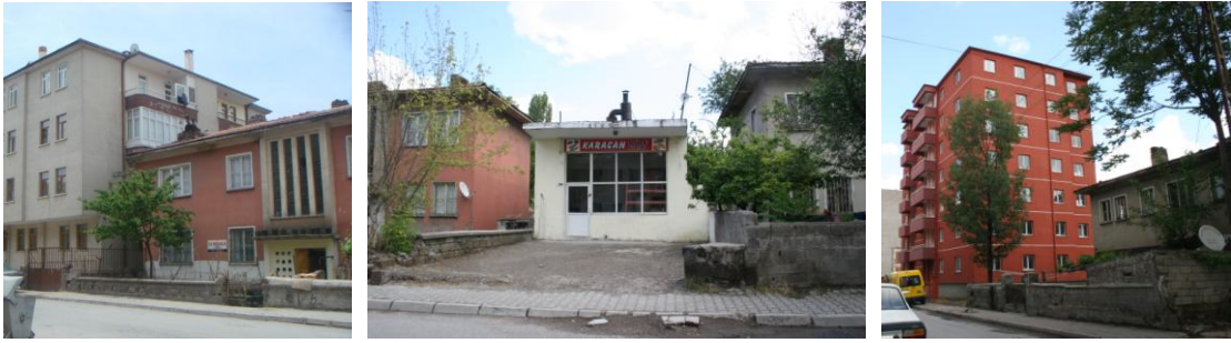
Şekil 5. 140. Belediye Blokları Dönüşümü
