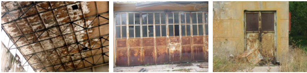
Şekil 5. 9940. Metal bozulması örnekleri
