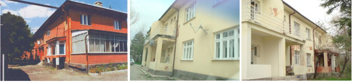
Şekil 4. 7829. Yapıların günümüzdeki durumu [209]
