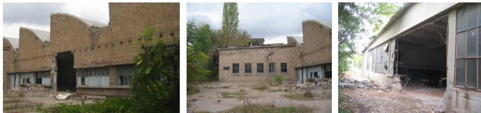
Şekil 5. 9537. Alanda yapılan yıkım örnekleri
