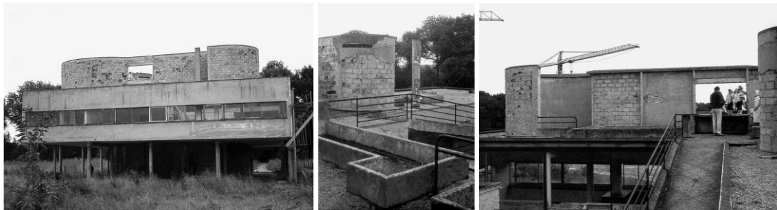
Şekil 3. 23. Yapının restorasyon öncesi fotoğrafları [130]
