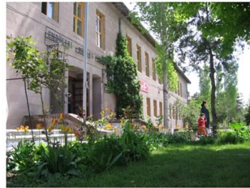
Şekil 5. 13364. Niğde Sanat Enstitüsü Günümüzdeki Durumu [252]
