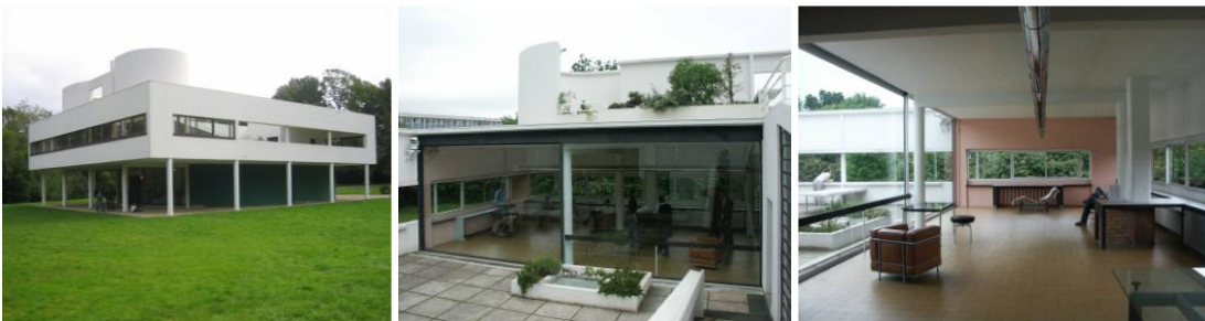
Şekil 3. 24. Yapının restorasyon sonrası fotoğrafları [131]
