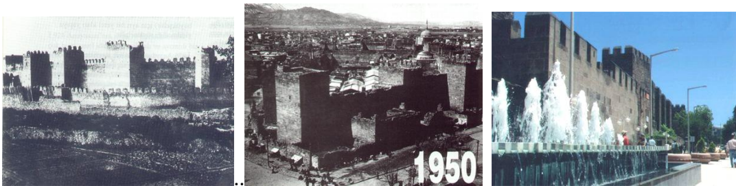
Şekil 4. 54. Kayseri İç Kale ve Çevresinin 1897 ve 1950, 2003 Yıllarındaki Görünümleri [198]
