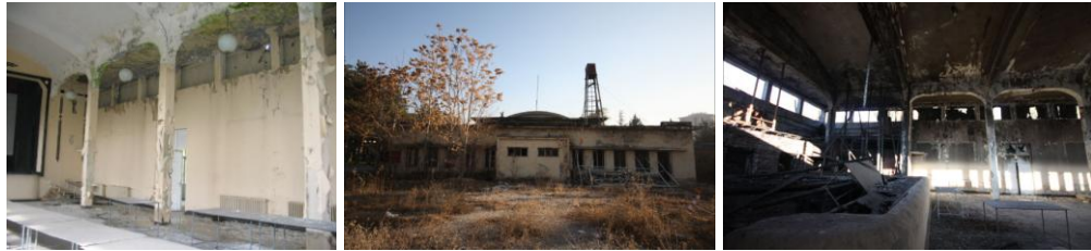
Şekil 5. 92. Lokal Yapısının İç ve Dış Görünüşleri
