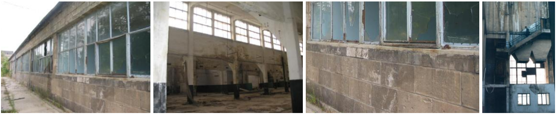
Şekil 5. 9739. Kararma ve Beyazlama Örnekleri
