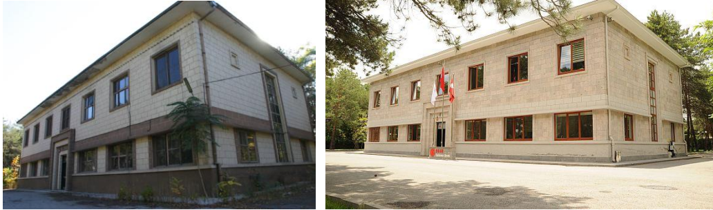
Şekil 5. 93.Müdüriyet Yapısının Restorasyon Öncesi ve Sonrası Görünüşleri
