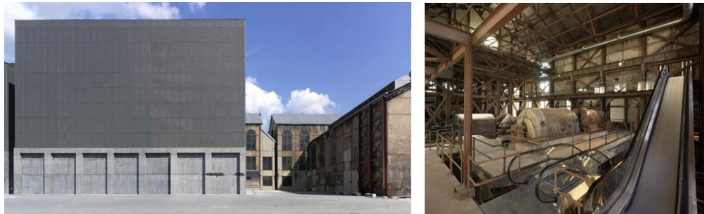
Şekil 3. 40. Santralin restorasyon sonrası görselleri [171], [172]
