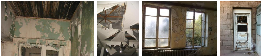
Şekil 5. 100. Ahşap bozulması örnekleri
