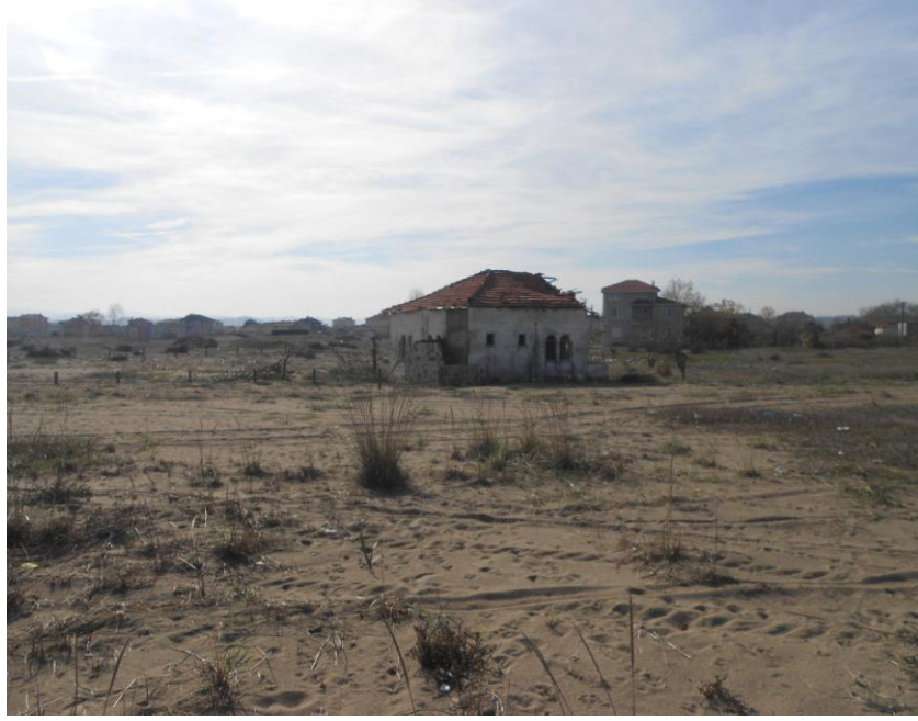
Fotoğraf 50: Hareketli kumul sahasında yapılan bazı konutlar terk edilmiştir.
