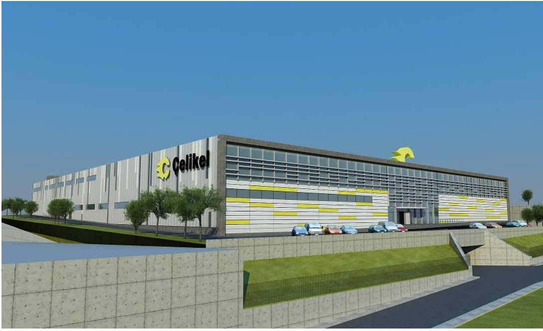
Çizelge 4.35. Çelikel Alüminyum Döküm Fabrikası ve Yönetici Binası Bilgi – Gözlem Formu.
