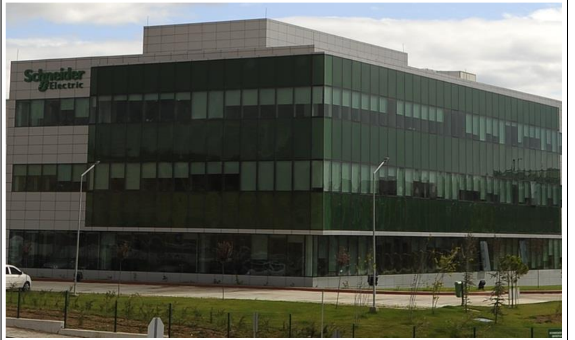
Çizelge 4.24. Schneider Elektrik Trafo Fabrikası Bilgi – Gözlem Formu.
