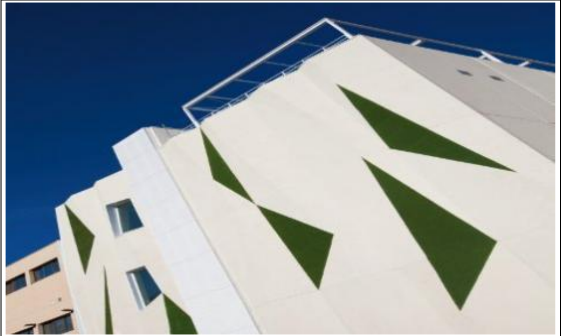
Çizelge 4.67. Interxion Data Center MAD2 Bilgi – Gözlem Formu.
