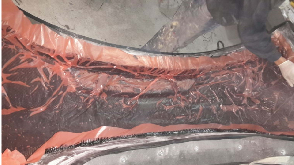
Şekil 5.12 Fazla reçinenin tahliyesinde kullanılan gözenekli naylon
