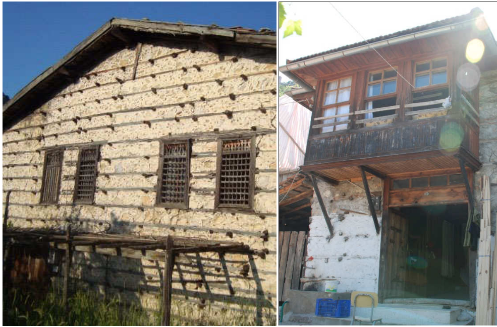
Şekil 3.19 : Malzeme, tip ve oranları bakımından açıklıklar.
