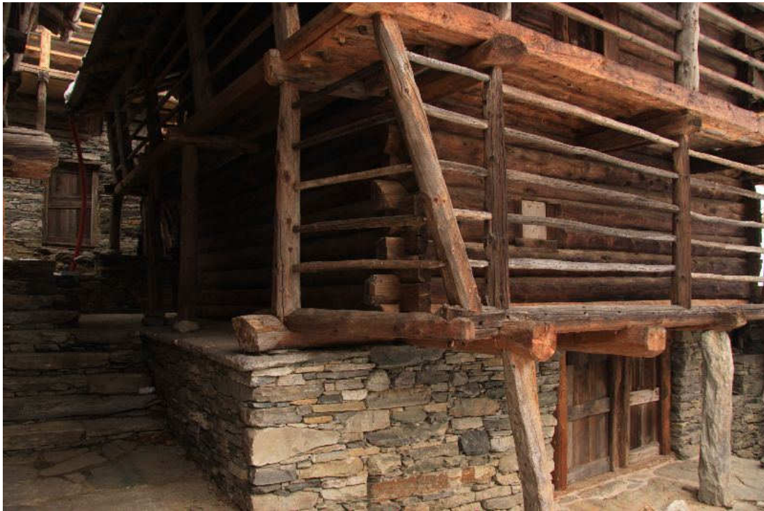
Şekil 3.44 : Alagna Valsesia'daki bir 'Walser' evinde farklı malzeme ve yapım sistemlerinin kullanımı (Anonim-7).
