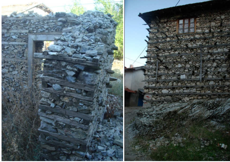
Şekil 3.13 : Düğmeli ev sıvasız kuru taş duvarları ve zeminle ilişkisi.
