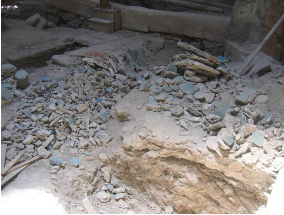
Fotoğraf 94: Hanikah onarım öncesi. (Konya Vakıflar Bölge Müdürlüğü’nden alınmıştır)
