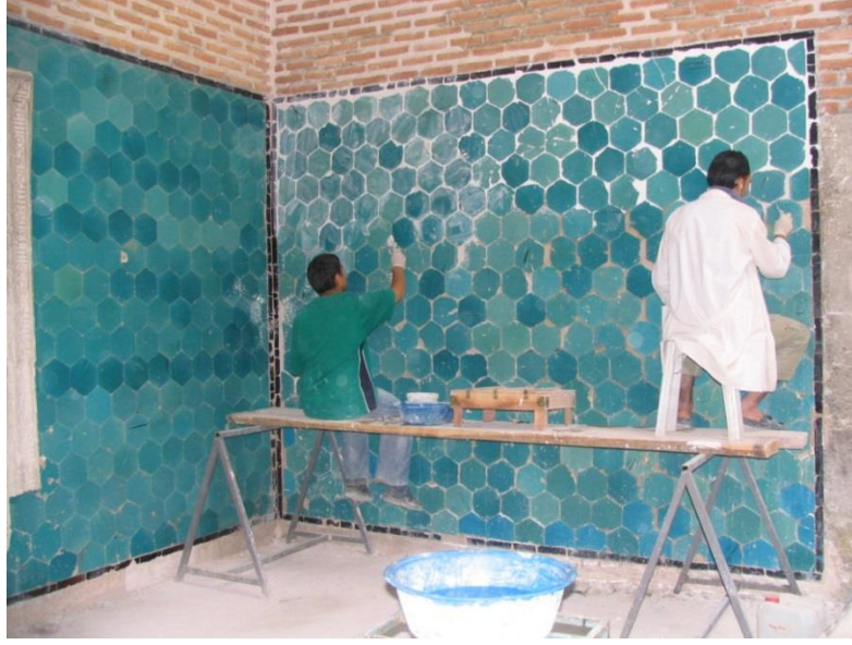
Fotoğraf 112: Hanikah güney eyvanı onarım sırasında.
