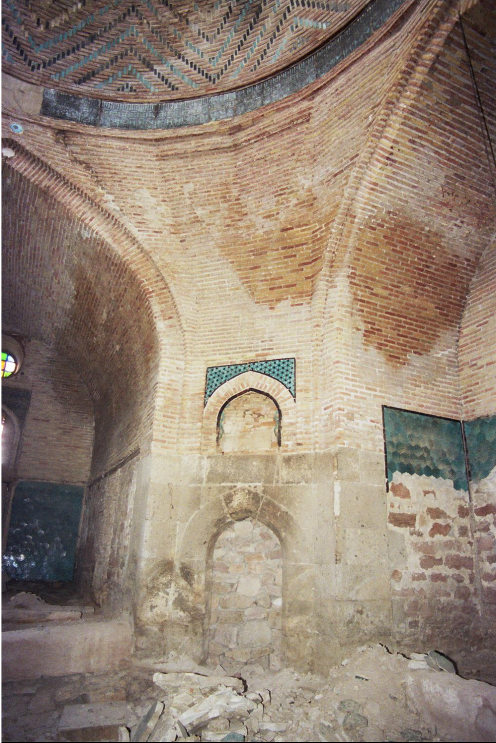
Fotoğraf 98: Kuzey batı köşe onarım öncesi. (Konya Vakıflar Bölge Müdürlüğü'nden alınmıştır)
