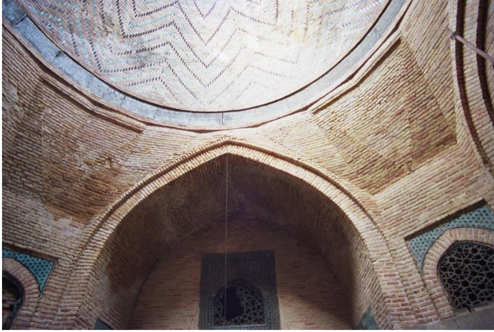
Fotoğraf 100: Kuzey eyvanı penceresi onarım öncesi.
