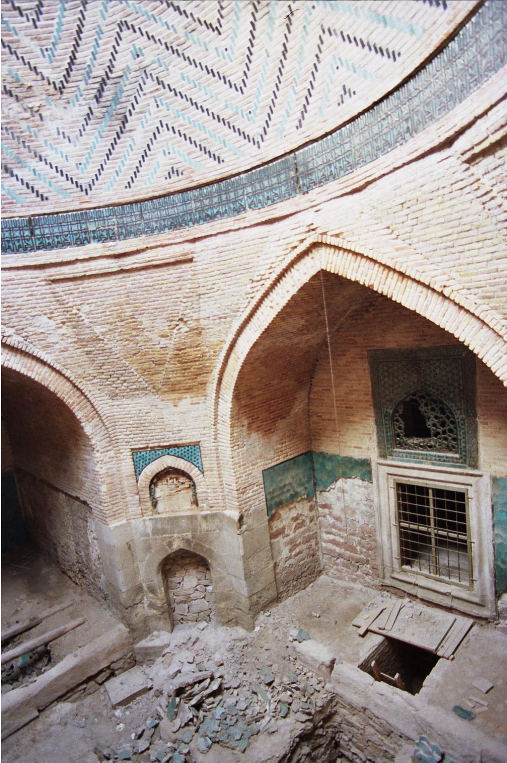
Fotoğraf 99: Kuzey eyvanı, kuzey batı köşe onarım öncesi.
