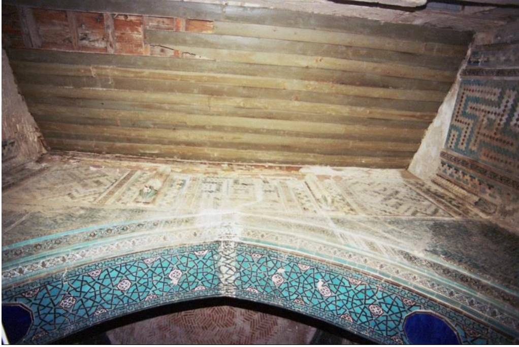
Fotoğraf 109: Türbeye giriş koridorunun üstü onarım öncesi.
