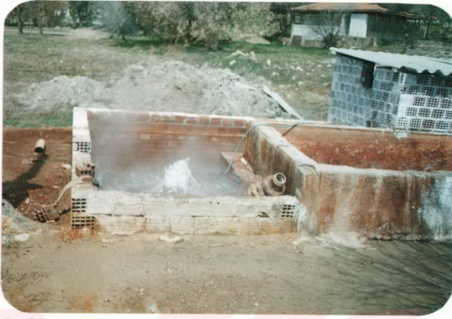
Resim 6. Karahayit Kurtur Oteli sondajından kompresörle sıcak su alınması.
