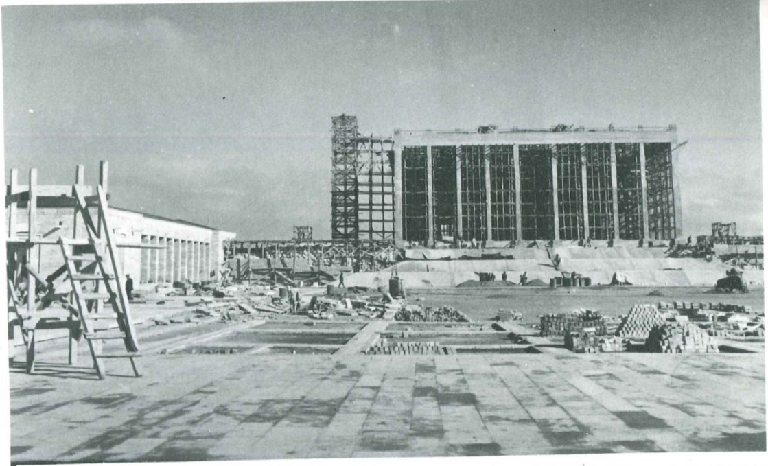
Anıtkabir İnşaatı. (1950-51) The Construction of Anıtkabir, the Moseleum of Atatürk.
