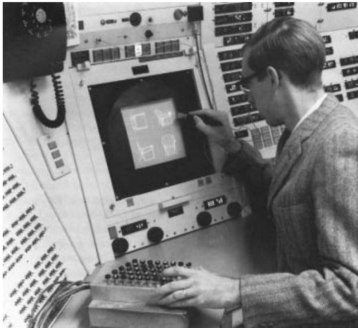
Şekil 4.12 Sutherland'in Sketchpad ve BTS ile fotoğrafları (Cohen, 2000) (Töre, 2010)
