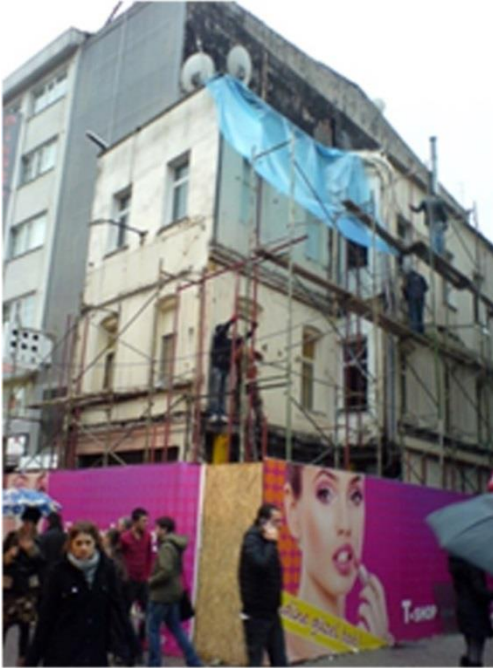
Şekil 3.14: Beşiktaş Çarşısında Bina Onarım İnşaatı (Aralık, 2012)
