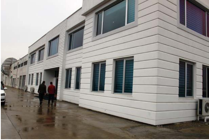
Resim:35. Kahramanmaraş Karacasu tekstil fabrika binası.
