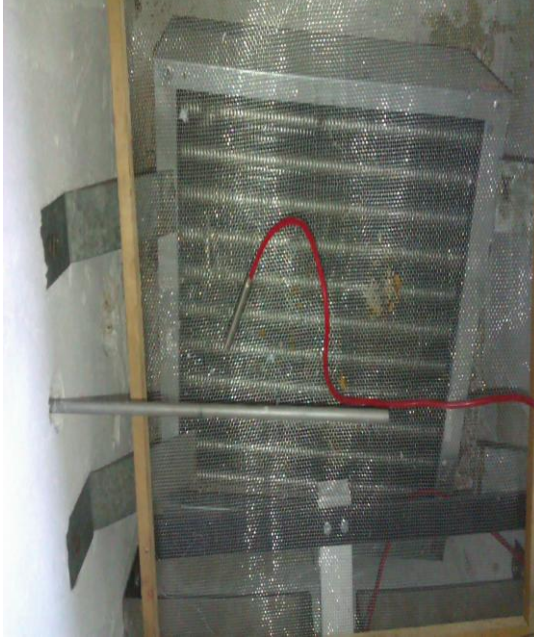
Şekil 1.5. Kurutulma ünitesi ısıtma serpantini
