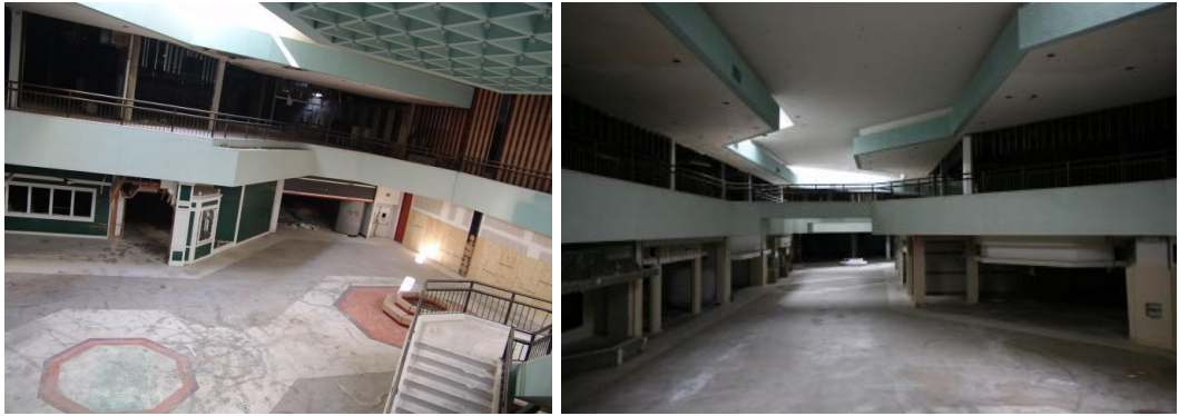
Şekil 4.66: Hawthorne Plaza Shopping Center günümüzdeki atıl durumu (Url-21)
