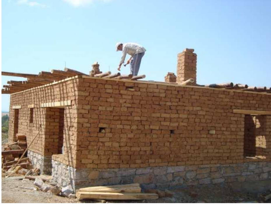
Şekil 15 – Taş subasman duvarı üzerinde kerpiç tuğlalarla inşa edilmekte olan günümüzden bir yapı örneği (Koçu 2012: Şekil 1).
