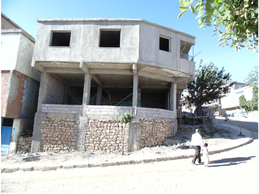
Fotoğraf 18. Yenişehir Mahallesinde Eski ve Yeni İnşa Malzemesinin Bir Arada Kullanıldığı Konut
