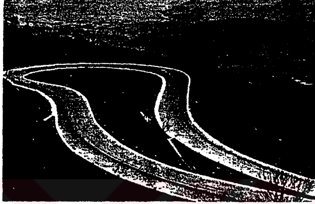
Şekil 3. Arazinin morfolojik yapısına uyma zorunluluğu, güzergahta kavislere ve dolayısıyla yolun proje hızına etki eder (Lorenz, 1971).
