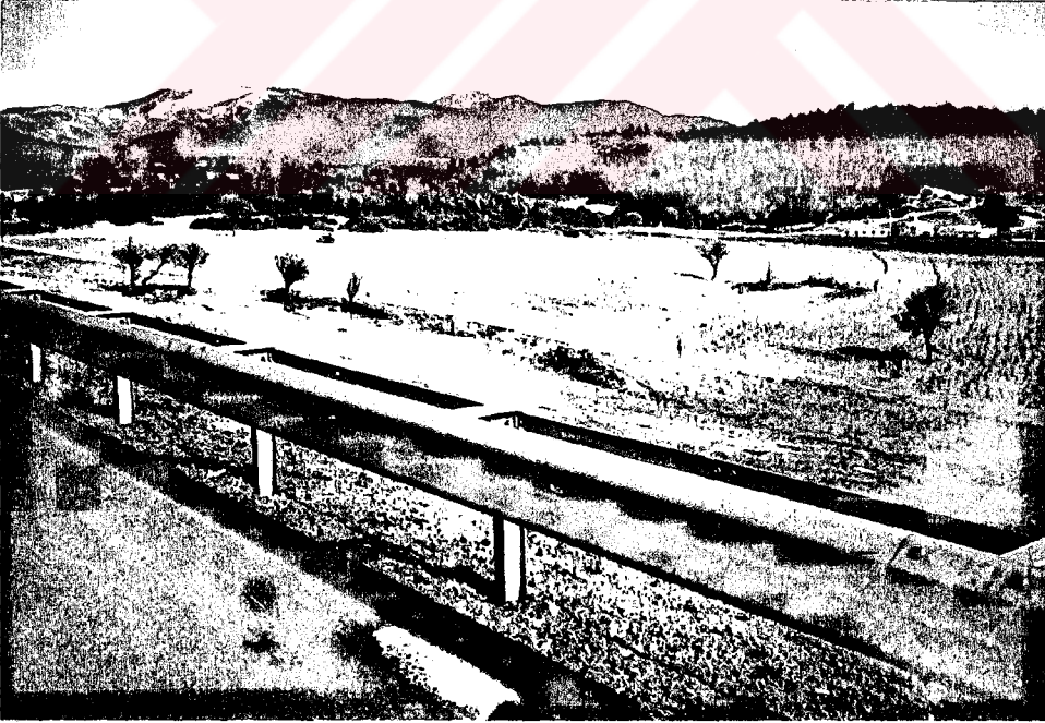
Şekil 84. Karayolları ile tarım alanları arasında mutlaka bitkisel bir şerit oluşturulmalıdır. İzmir-Aydın Otoyolu.
