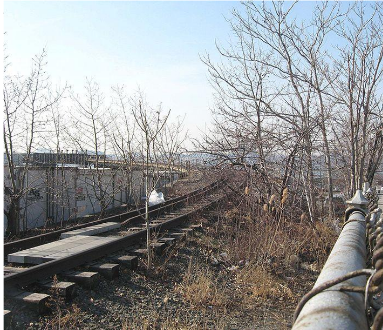
Şekil 5.27 : THL'in projelendirme öncesi durumu.
