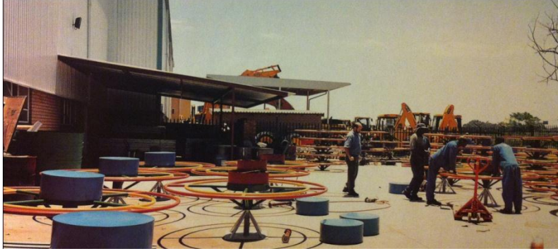
Şekil 5.5 : Yerel işgücü ile pompaların yapımı (Cumberlidge ve Musgrave, 2007, s.35).
