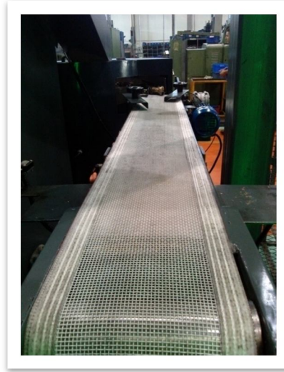
Şekil III.11 Konveyör Bant Sistemi
