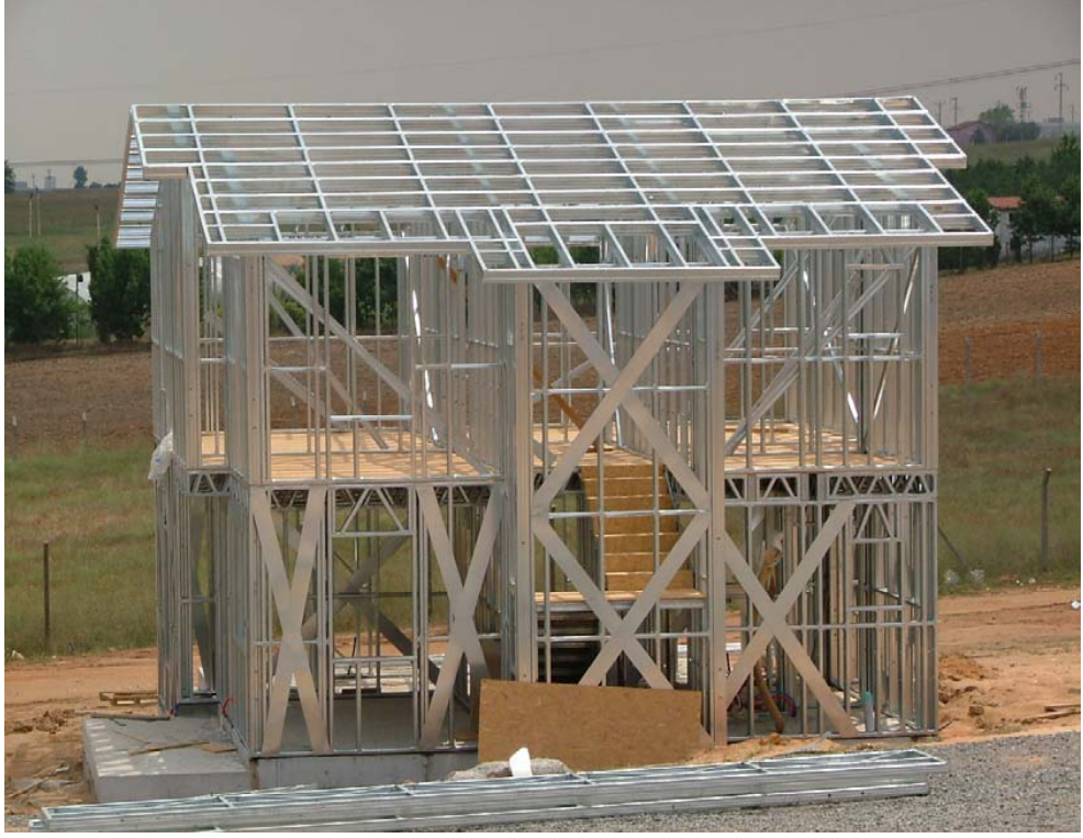
Şekil 1.8 : Birincil taşıyıcı sistem olarak soğukta şekil verilmiş elemanlar [4]
