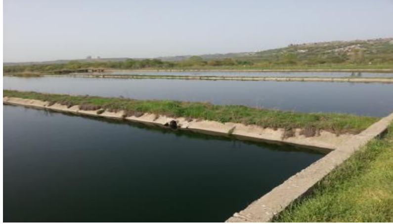
Şekil 3.7. Fiziksel olarak arıtılmış atık suların alındığı atık su kaynağının çöktürme havuzlarının genel görüntüsü
