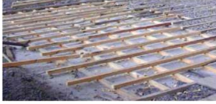
Şekil 3.7 Kafes döşemede ızgaraların yerleştirilmesi (Anonim, 2007)
