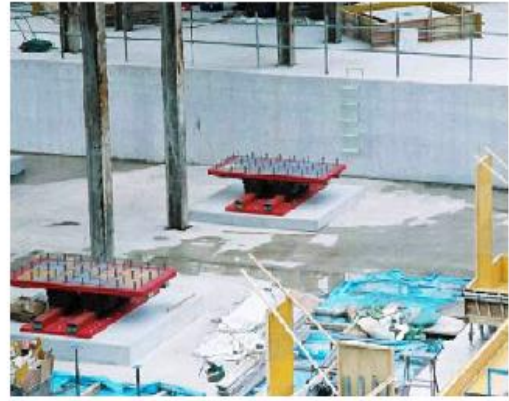
Şekil 3.5: Çapraz raylı mesnet örnekleri [16].
