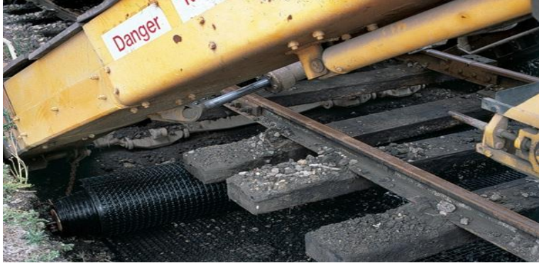
Şekil 4.16 Hat yenileme çalışmalarında balast tabakası arasına geogrid malzeme serimi.
