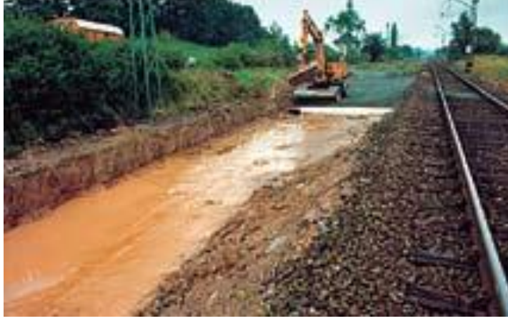
Şekil 4.20: Hochstadt – Probstzella arası demiryolu hattında geogrid malzeme ile yapılan iyileştirme çalışmaları.
