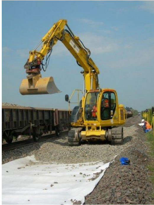
řekil 4.3: Demiryollarında geotekstil malzeme serilimi.
