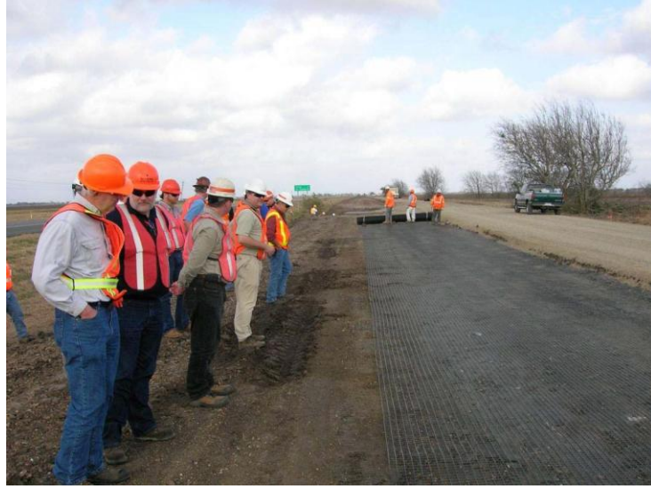
Şekil 5.2: Viktoria - Rosenberg arası demiryolu hattında yapılan geogrid serimi.
