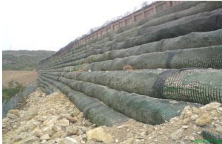
Şekil 2.19: Geogrid malzeme ile şev yapılarının oluşturulması.
