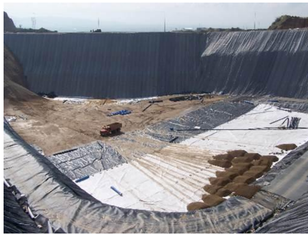
Şekil 2.12: Geomembran malzeme ile dış kaplaması oluşturulmuş bir depolama alanı.
