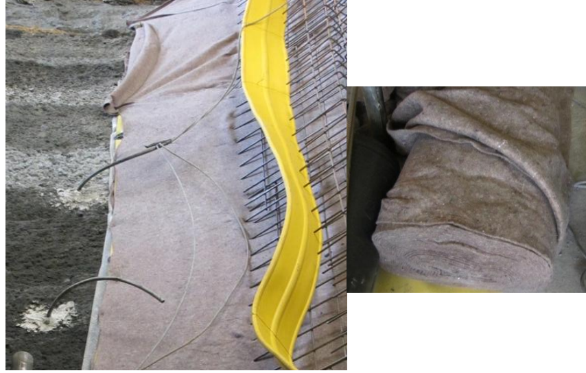
Şekil 4.6: İstanbul metrosu 2. kısım inşaatında koruyucu geotekstil malzeme uygulaması.
