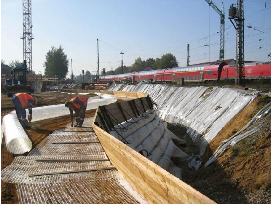
Şekil 4.13: Geogrid şev güçlendirmesi uygulaması, Alman demiryolları[7].
