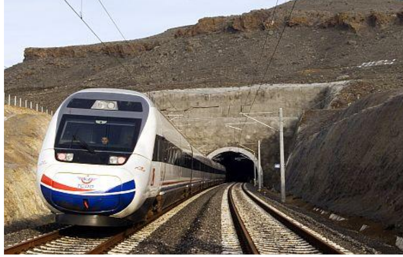
Şekil 3.1: Demiryolu tünel yarma ve istinat yapıları.
