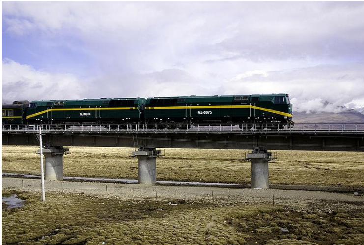
Şekil 3.9: Tibet Şangay arası demiryolu hattında don etkilerine karşı alınan önlem yapısı.
