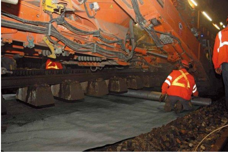
řekil 2.9: Geotekstillerin balast tabakası altında kullanımı.
