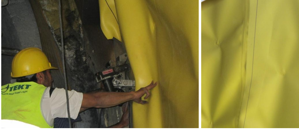
Şekil 4.11: Geomembran malzeme ile su yalıtımında kaynak uygulaması.
