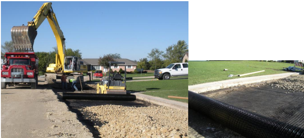
Şekil 2.18: Geogrid malzemenin asfalt yol zemininde kullanımı.
