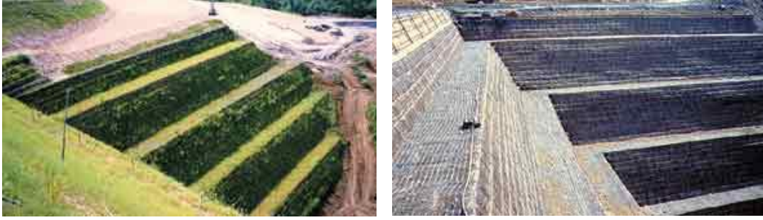
Şekil 2.20: Geogrid malzeme ile şev yapısının oluşturulması (Chung-hsin, Taiwan).
