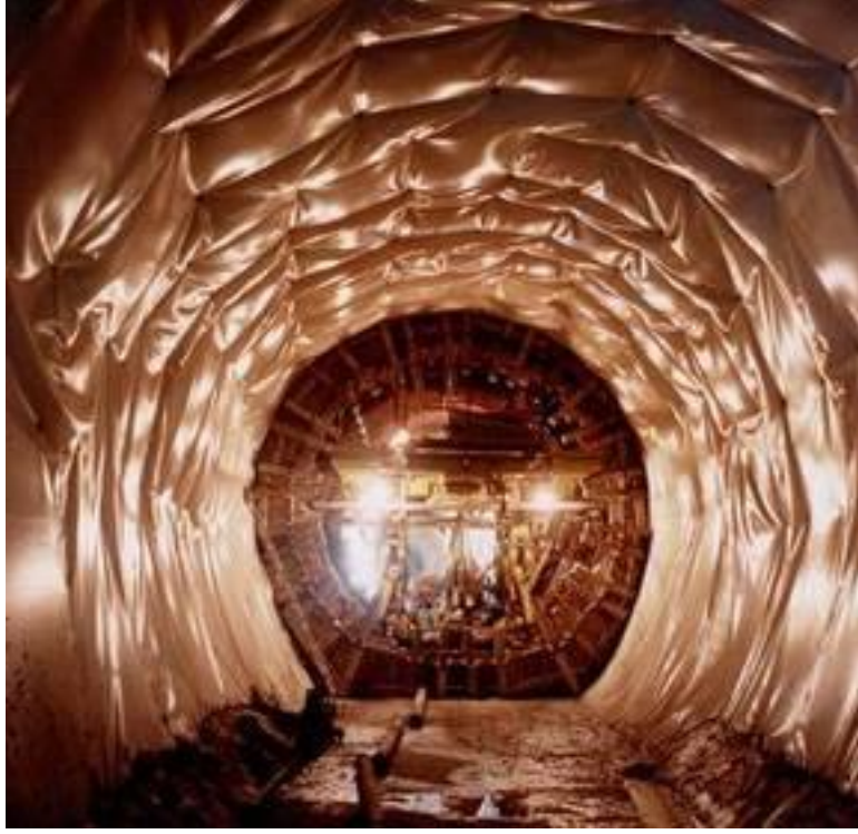
Şekil 4.7: Demiryolu tünellerinde geomembran uygulaması.
