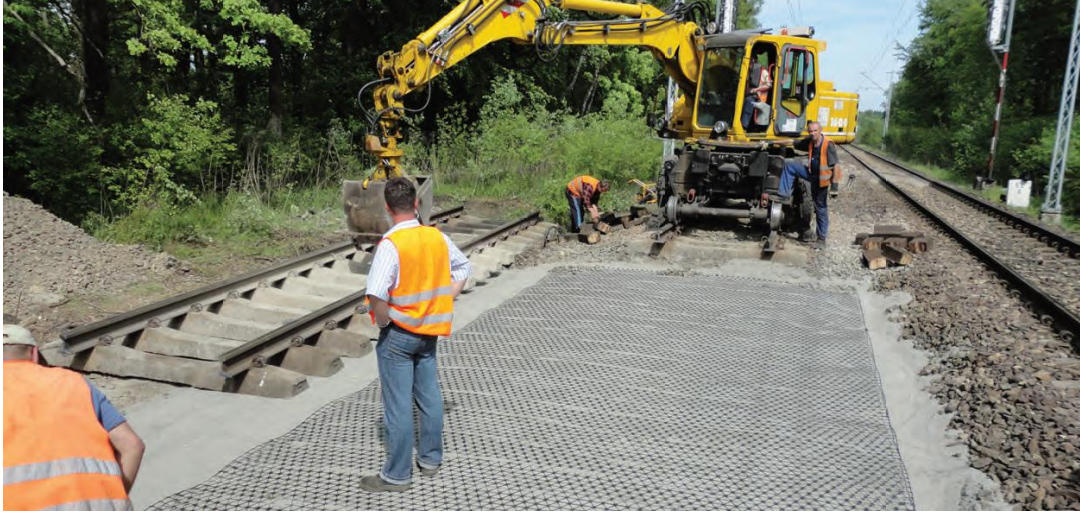
Şekil 4.22: Geogrid malzeme yerleştirilerek yapılan balast stabilizasyonu çalışması - Shirland, İngiltere.
