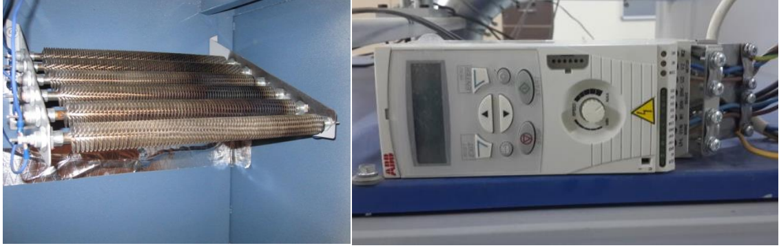
Şekil 3.2. Kurutucuya ait ısıtıcı ve fana ait değişken devirli hız sürücüsü
