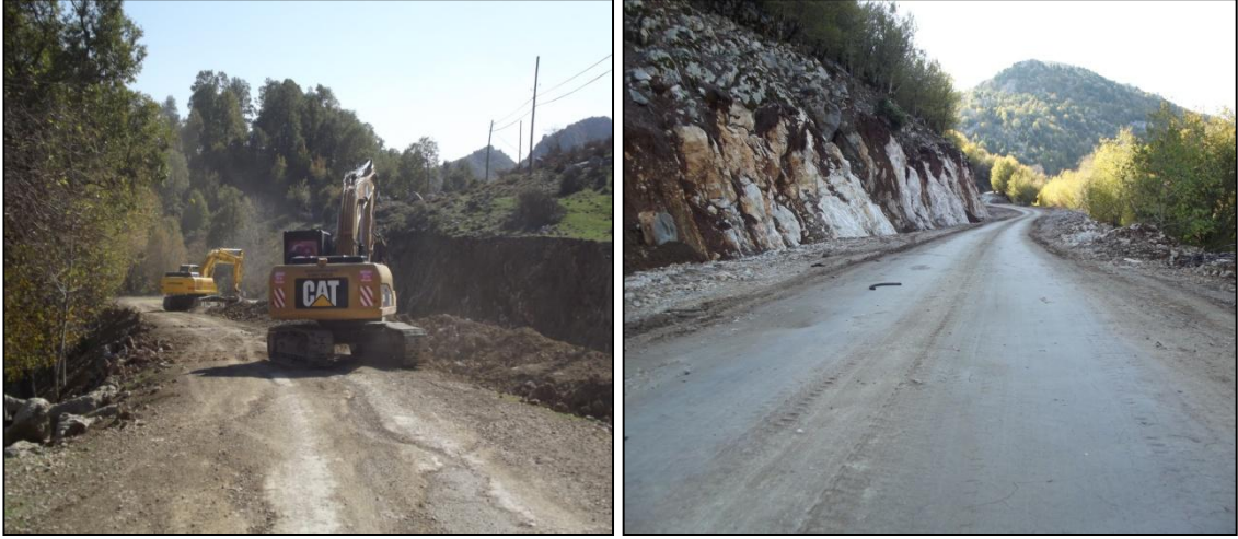
Foto 4.72. Kadirli'yi Maksutoluğu yaylasına da bağlayan Yanalak yolu yapım çalışması
