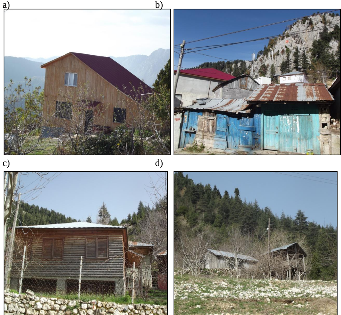
Foto 4.23. Köşürge (a), Bağdaş (b), Sıyrıncaç (c) ve Gökbüğet (d) yaylalarında yer alan ahşap mesken ve işyerleri
