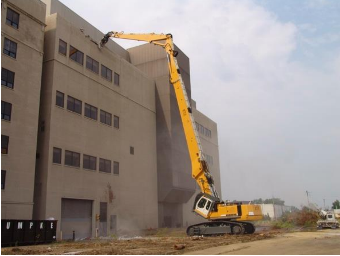
Şekil 2.1: Yüksek erişimli makine ile yıkım metodu.
