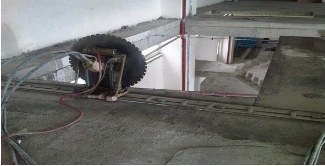
Şekil 2.2: Kesme ile yıkım metodu.
