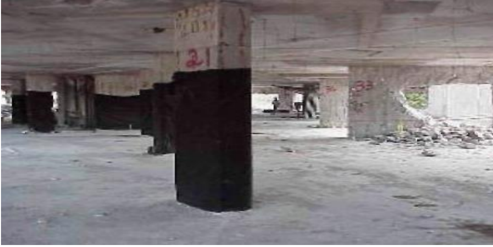
Şekil 2.9: Parça savrulması ve hava şokuna karşı kolon sarılması.
