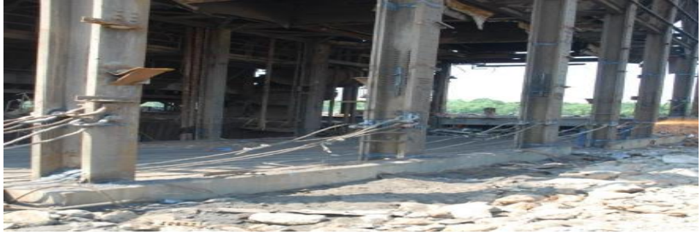
Şekil 2.4: Halat yardımı ile yıkım metodu.
