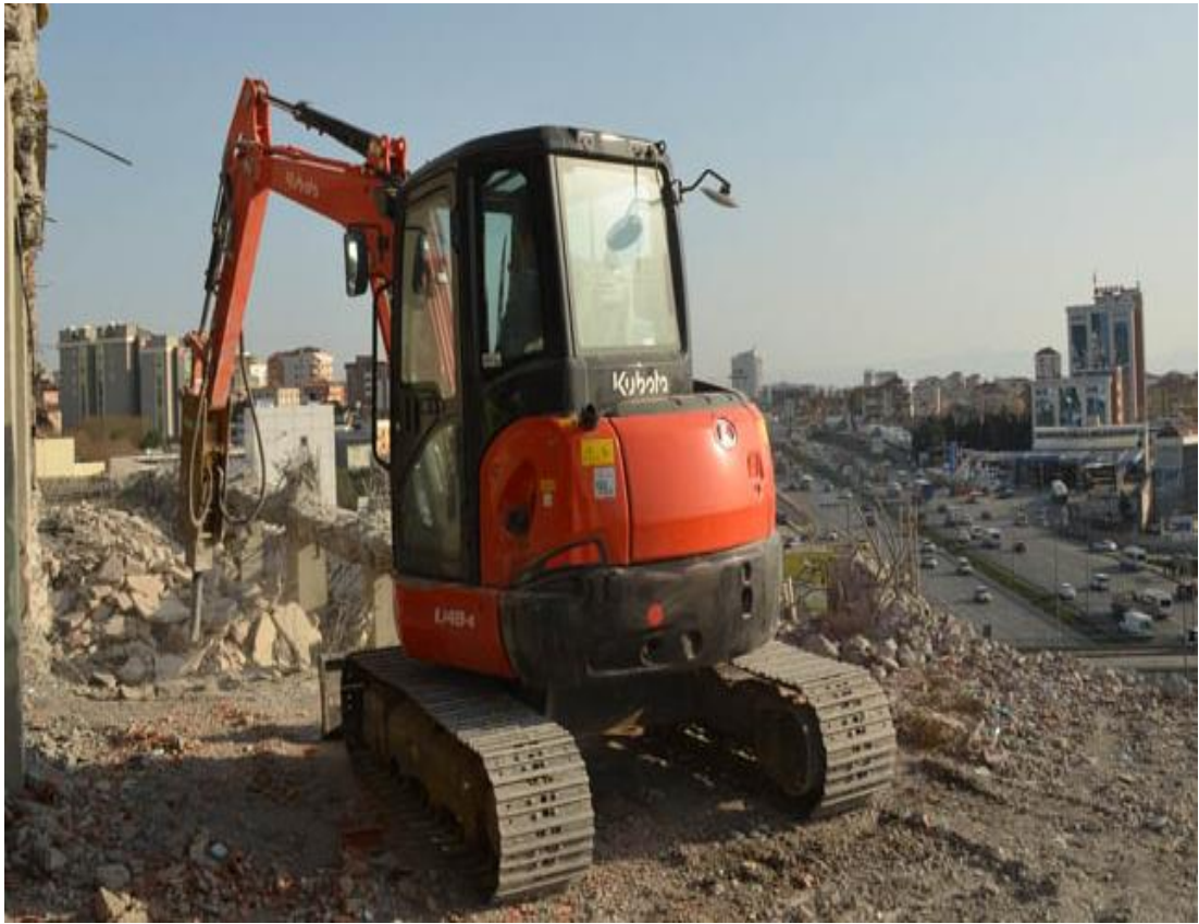
Şekil 2.3: Mini makine ile yıkım metodu.
