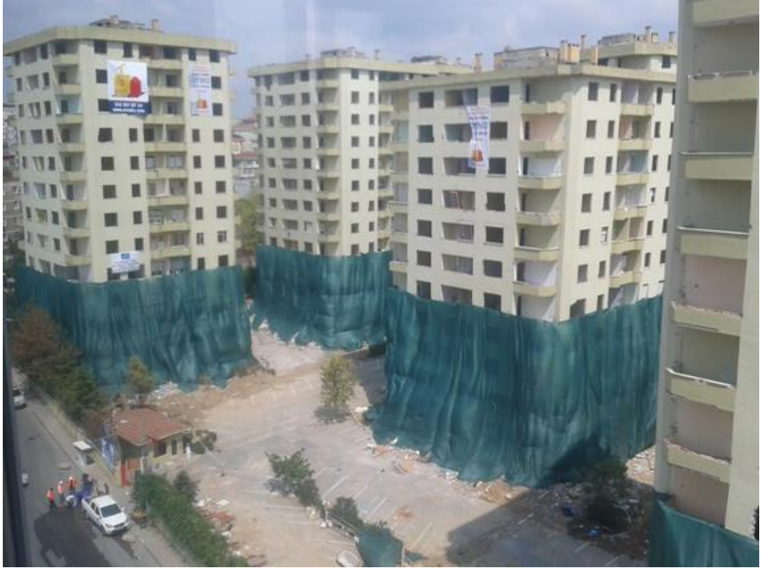
Şekil 2.8: Patlayıcı ile yıkımda parça savrulmasına karşı önlem.
