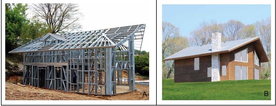
Şekil 3.23 : Hafif çelik iskeleti (A) ve tamamlanmış hali (B) [8]
