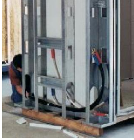
Şekil 2.52 : Tesisatın hafif çelik sistemle birlikte hazırlanması [5]
