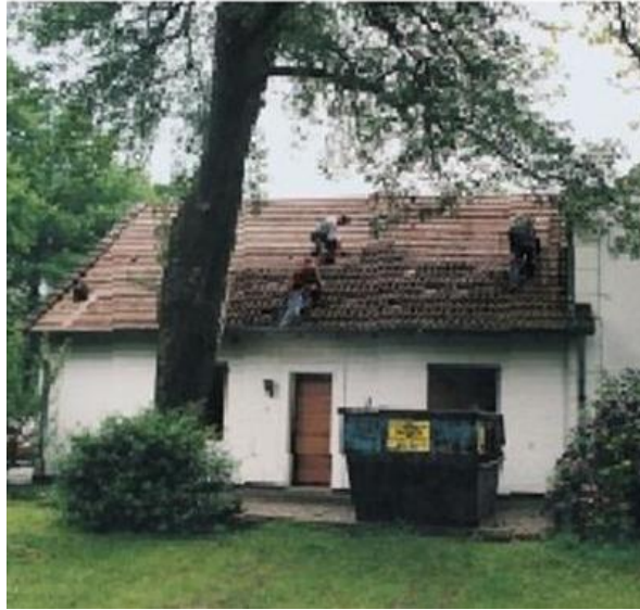
Şekil 4.38 : Çatısının sökülmesi/onarılması [39].
