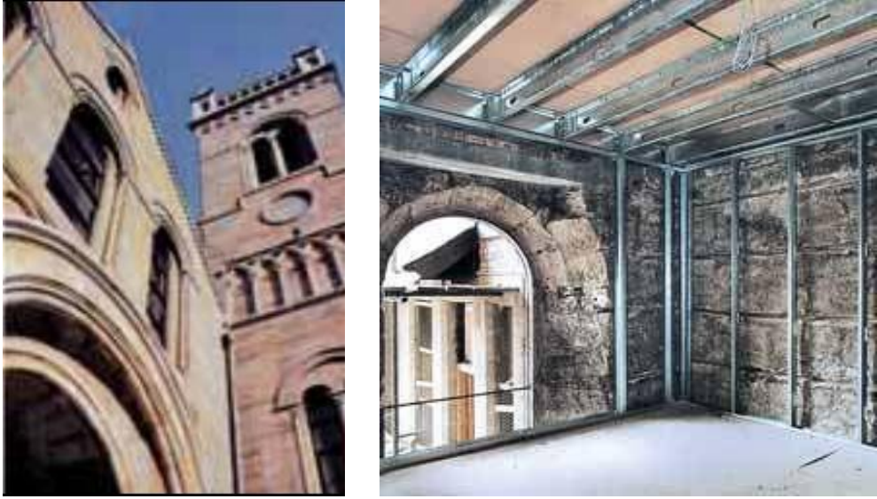
Şekil 2.12 : Yük getirmeyen hafif çelik taşıyıcılar ile asma tavan yapılması, Paisley Kilisesi, Paisley, İskoçya [9]
