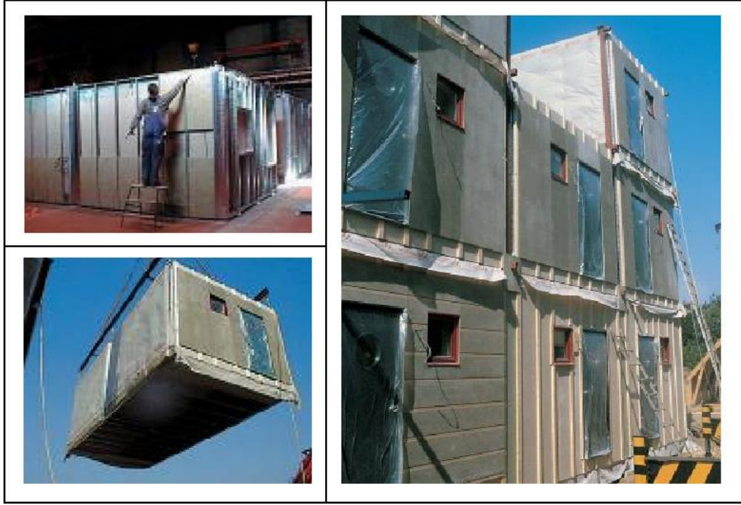
Şekil 2.60 : Hücre sistemin fabrika üretimi, şantiye alanına vinçle indirilmesi ve montajı [15]
