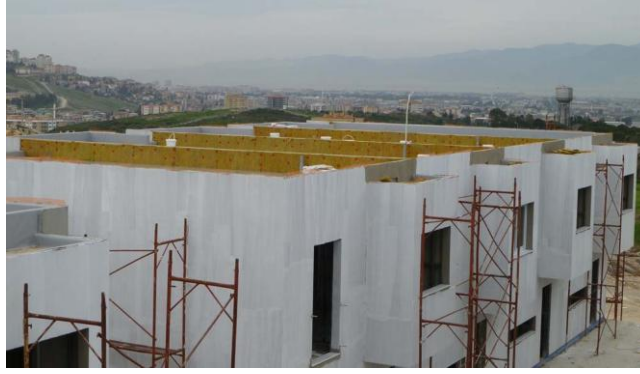
Şekil 4.24 : Çatı ve cephelerin yalıtılması [36]
