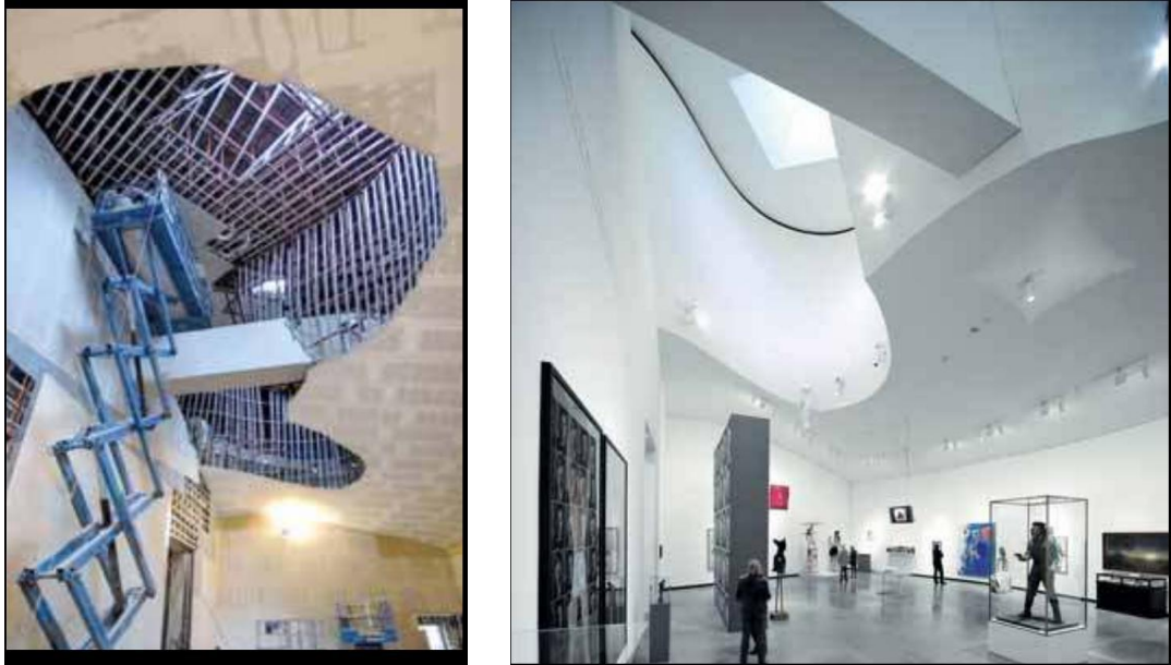
Şekil 2.9 : Herford Sanat Müzesi, inşaat sırasında hafif çelik profiller ve tamamlanmış hali [9]
