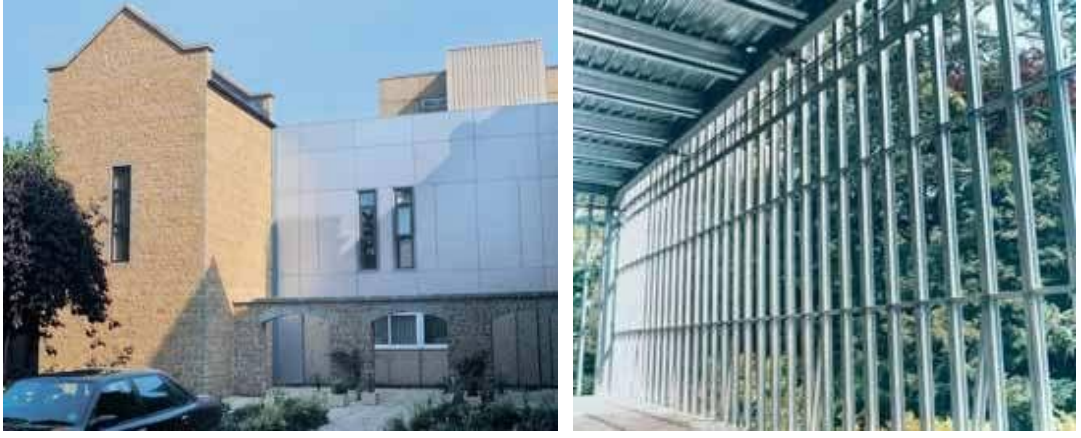
ekil 2.10 : Ashorne Tepesi Koluji, İngiltere'de 115 yıllık eski binanın düşük ekonomi ve kısa inaat süresi saėlayan hafif elik sistem ile iki katlı bir uzantı ile genişletilmesi [9]
