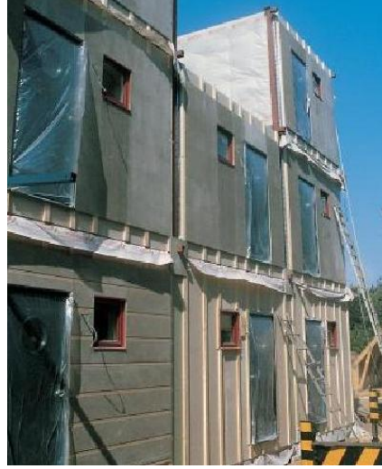
Şekil 4.55 : Fabrikada prefabrike olarak hazırlanmış, modüllerin sahada tek tek kurulması [15]
