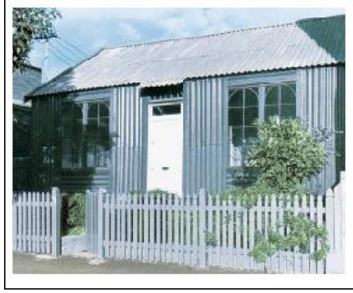
Şekil 2.22 : Trapez levha yapı dış yüzeyinde cephe ve çatı kaplaması olarak [14]
