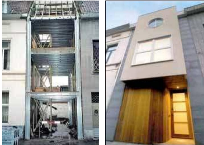
Şekil 2.7 : Belçika’da boş bir ara alanın hafif çelik yapım sistemi ile tamamlanması, inşaat aşamasında ve tamamlandıktan sonra [9]
