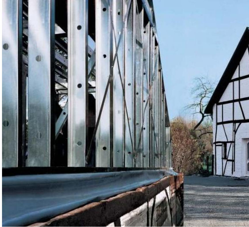
Şekil 4.44 : Yapıda kagir duvardan hafif çelik sisteme geçiş ve son hali [31]
