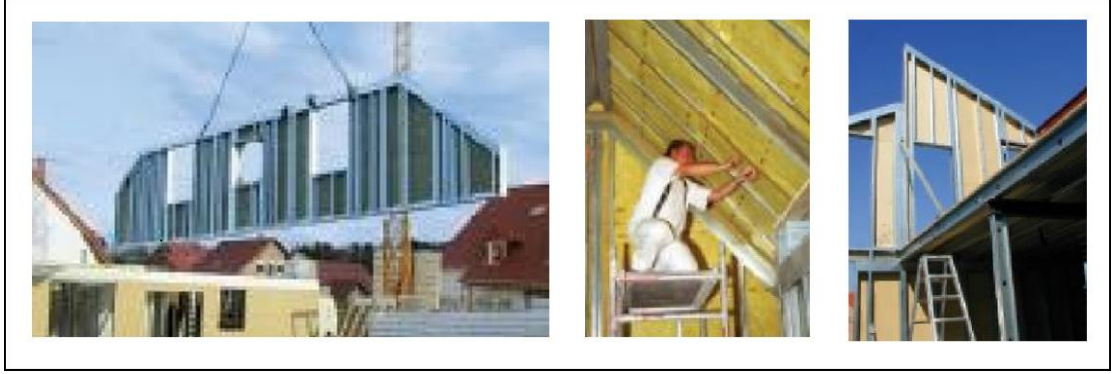
Şekil 2.59 : Panel sistemin şantiye görüntüleri [5]
