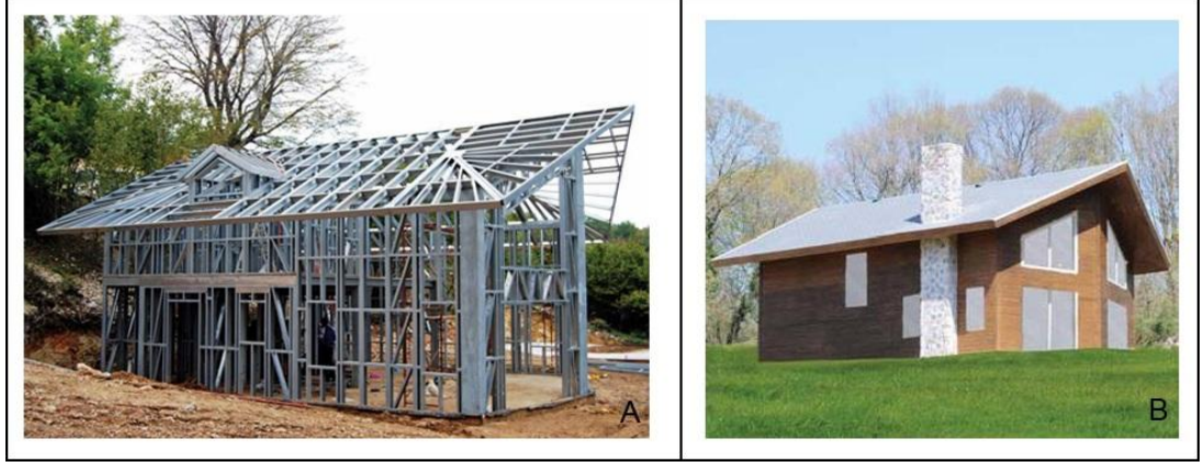
řekil 2.5 : Hafif elik iskeleti (A) ve tamamlanmıř hali (B) [8]
