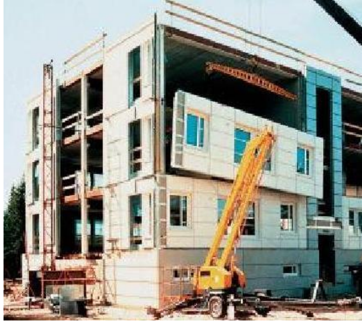
Şekil 4.52 : Hazır duvar panel montajı [5]
