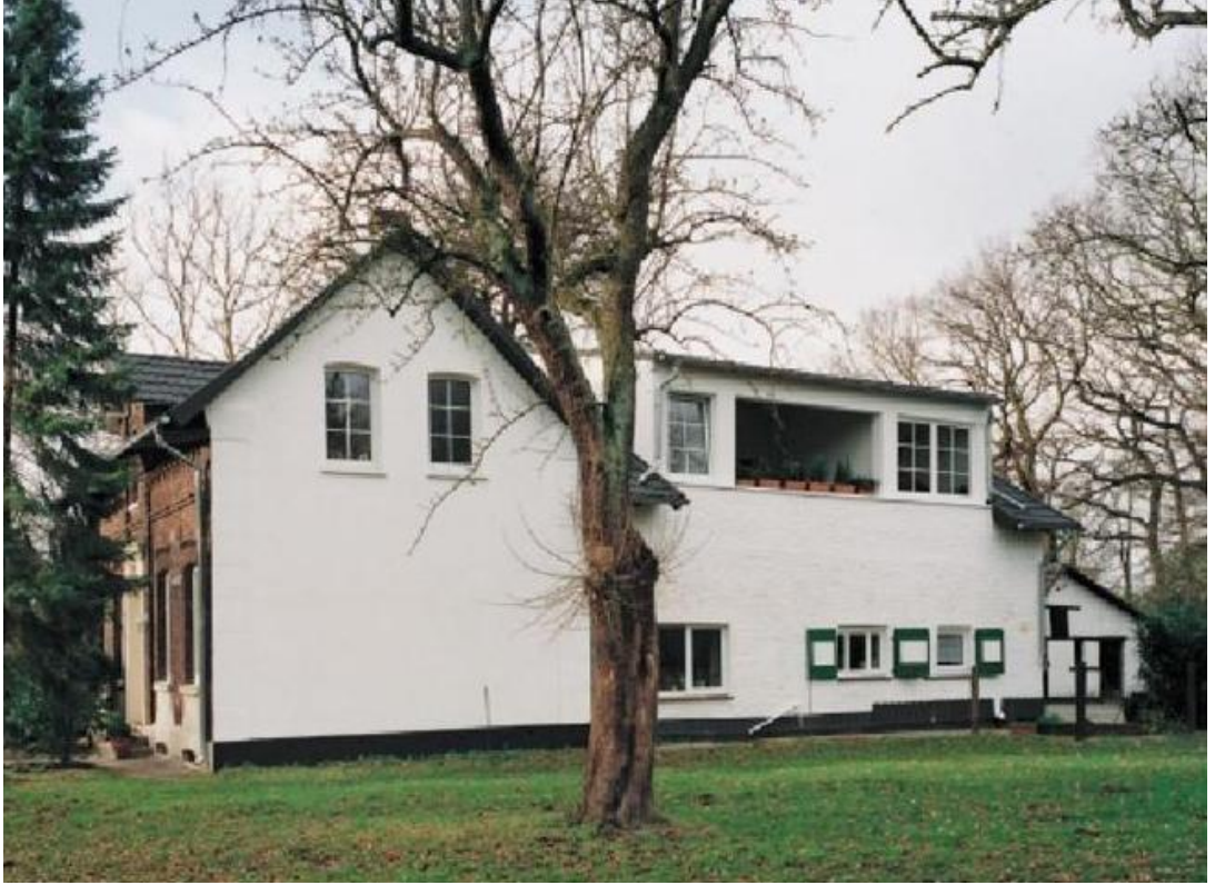
Şekil 4.42 : Solda kagir duvarları görünen yapının yenilenmiş üst sağ bölümü ve güçlendirilmiş çatısı [39]
