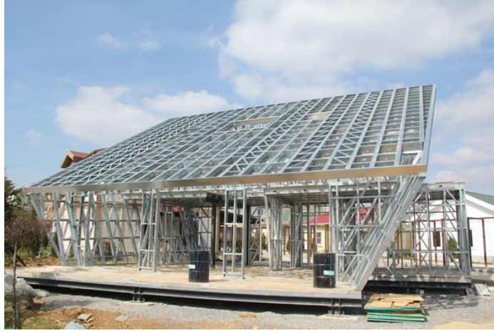
Şekil 4.6 : Çatı ve duvar taşıyıcı sistem görünüşü [29]
