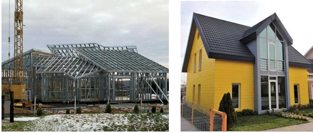
Şekil 2.6 : Hafif çelik çerçeve iskeleti ve konut örneği [8]
