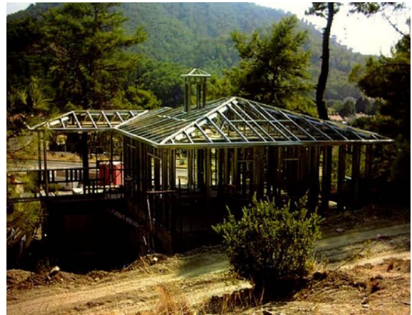
Şekil 4.35 : Eğimli arazide konumlanma ve ‘kuru’ sistem ile çevre koruması [38]
