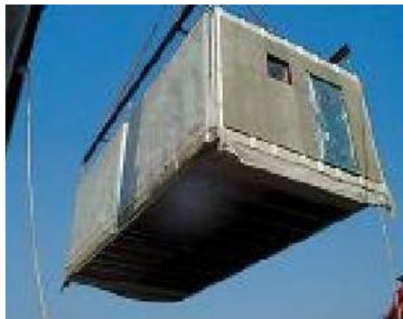
Şekil 4.54 : Hücrelerin inşaat alanına getirilmesi [15]
