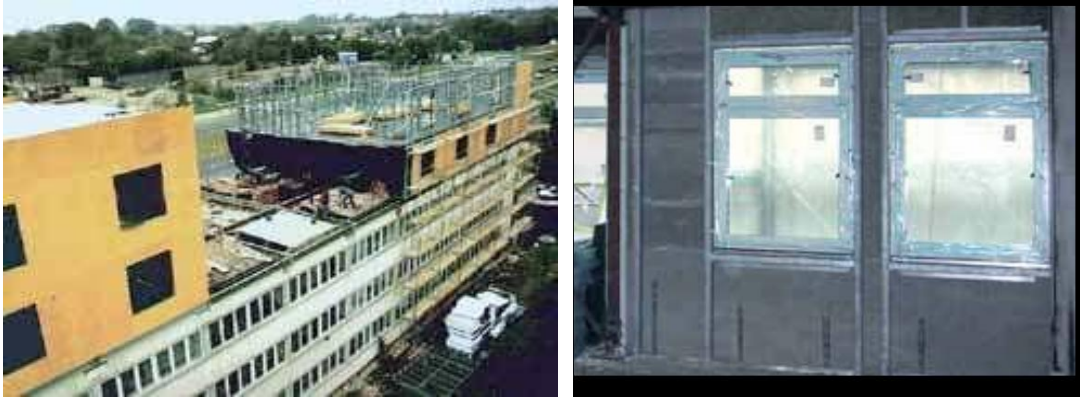
ekil 2.11 : İhtiya nedeniyle 10 yıllık hastane yapısının üzerine hafif elik sistem ile iki kat ilave edilmesi, Rzeszow, Polonya [9]
