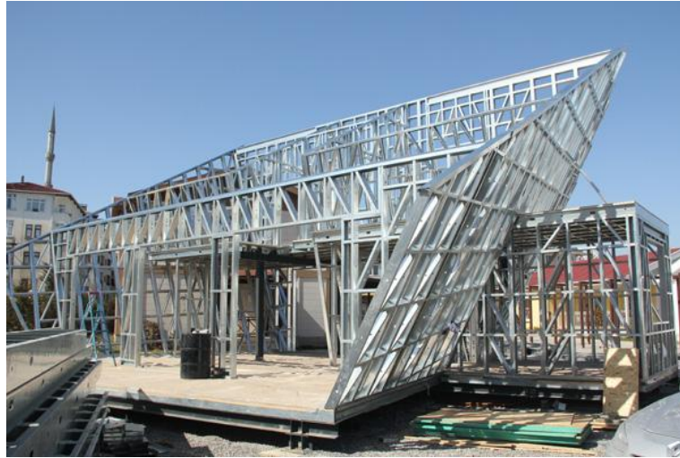
Şekil 4.5 : Devam eden taşıyıcı sistem montajı [29]
