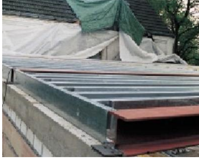
Şekil 4.45 : Tavan konstrüksiyonunda sıcak işlenmiş ve soğuk şekillendirilmiş (hafif) çelik profil kullanımı [39]
