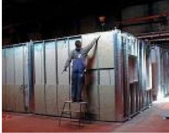
Şekil 4.53 : Hazır duvar panel montajı [15]
