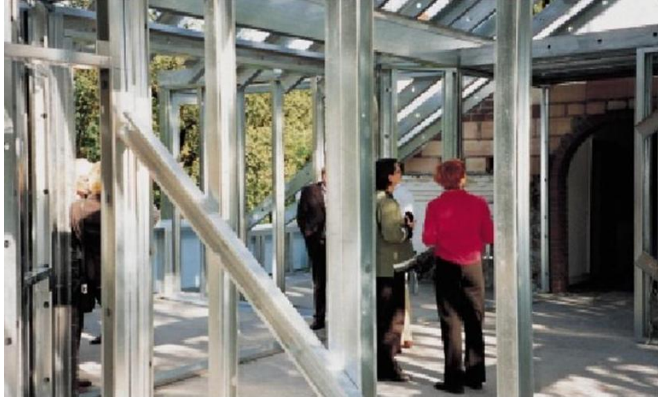
Şekil 4.46 : İki hafta içerisinde tamamlanana kaba inşaatı [39]
