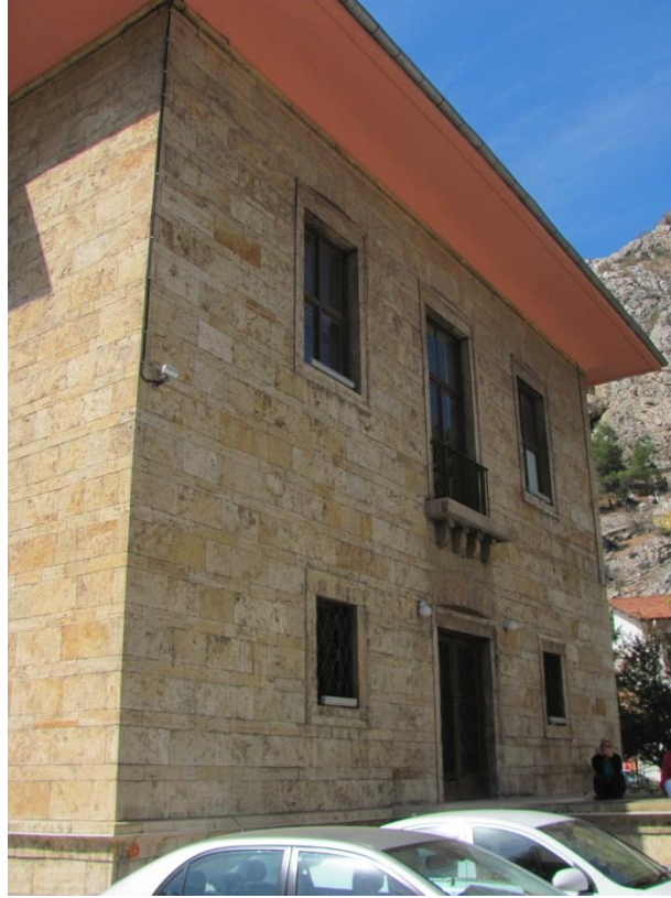
Fotoğraf 2: Valilik Binası Kuzey Cephe Genel Görünüm.
