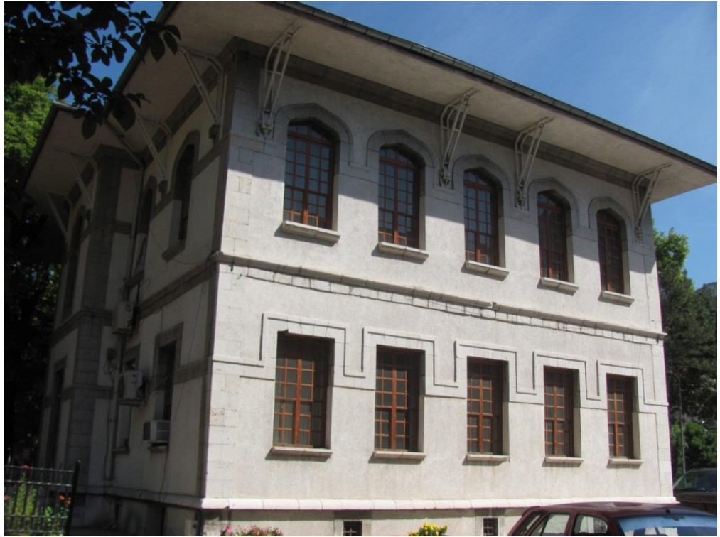
Fotoğraf 16: Belediye Eski Binası Güney Cephe Genel Görünüm.
