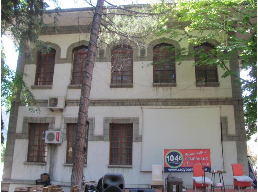
Fotoğraf 15: Belediye Eski Binası Kuzey Cephe Genel Görünüm.
