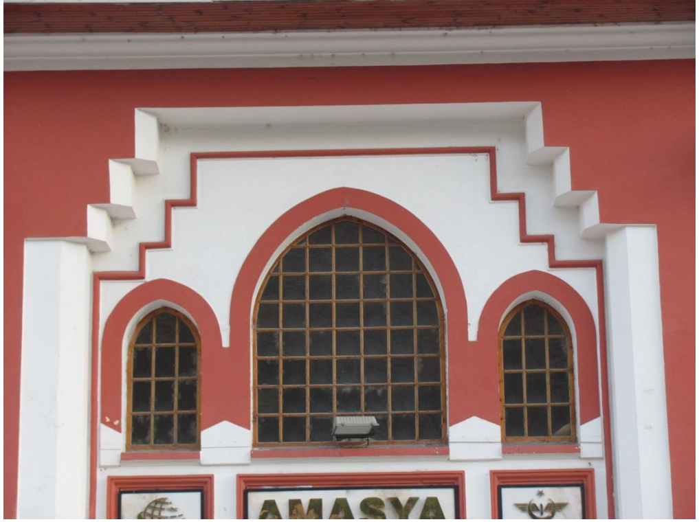
Fotoğraf 44: Amasya İstasyon Binası Kuzey Cephe Merkez Ayrıntı.
