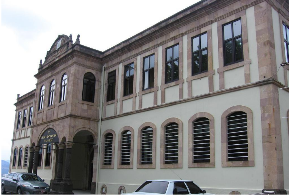
Fotoğraf 50: Giresun Hükümet Konağı Ana Cephe Genel Görünüm ( http://wowturkey.com/t.php?p=tr246/muhammet3_IMG_0292.jpg ).
