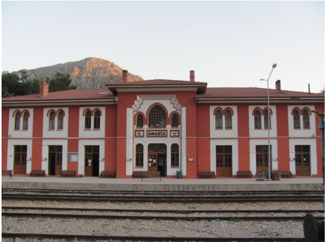
Fotoğraf 41: Amasya İstasyon Binası Kuzey Cephe Genel Görünüm.
