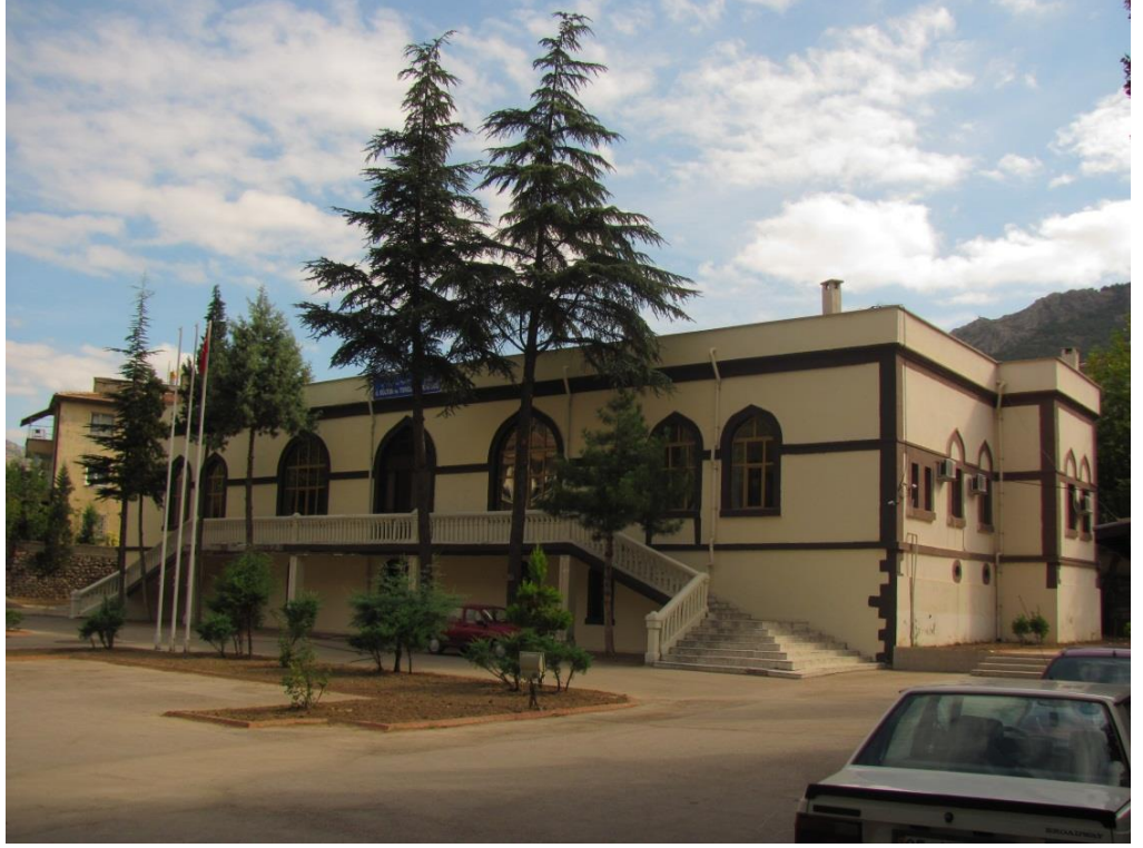
Fotoğraf 24: Kılıçarslan Mektebi Batı Cephe Genel Görünüm.
