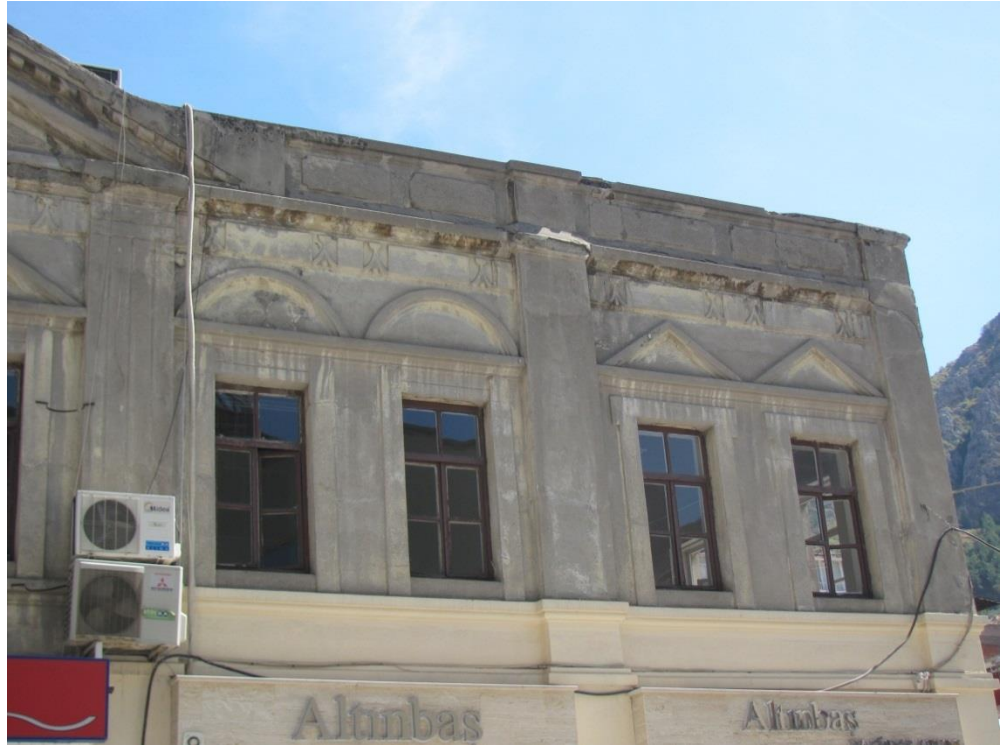
Fotoğraf 36: Adliye Eski Binası Birinci Kat Pencere Düzeni.
