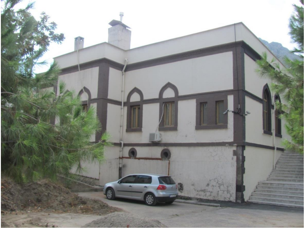
Fotoğraf 26: Kılıçarslan Mektebi Kuzey Cephe Genel Görünüm.
