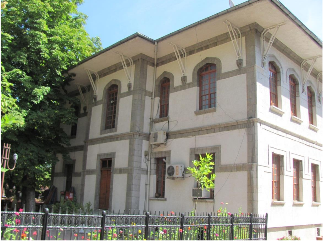
Fotoğraf 17: Belediye Eski Binası Batı Cephe Genel Görünüm.
