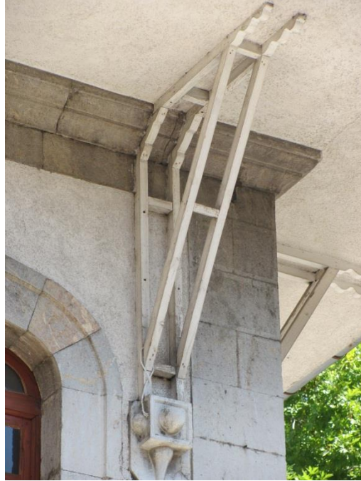
Fotoğraf 61: Belediye Eski Binası Ahşap Konsol.
