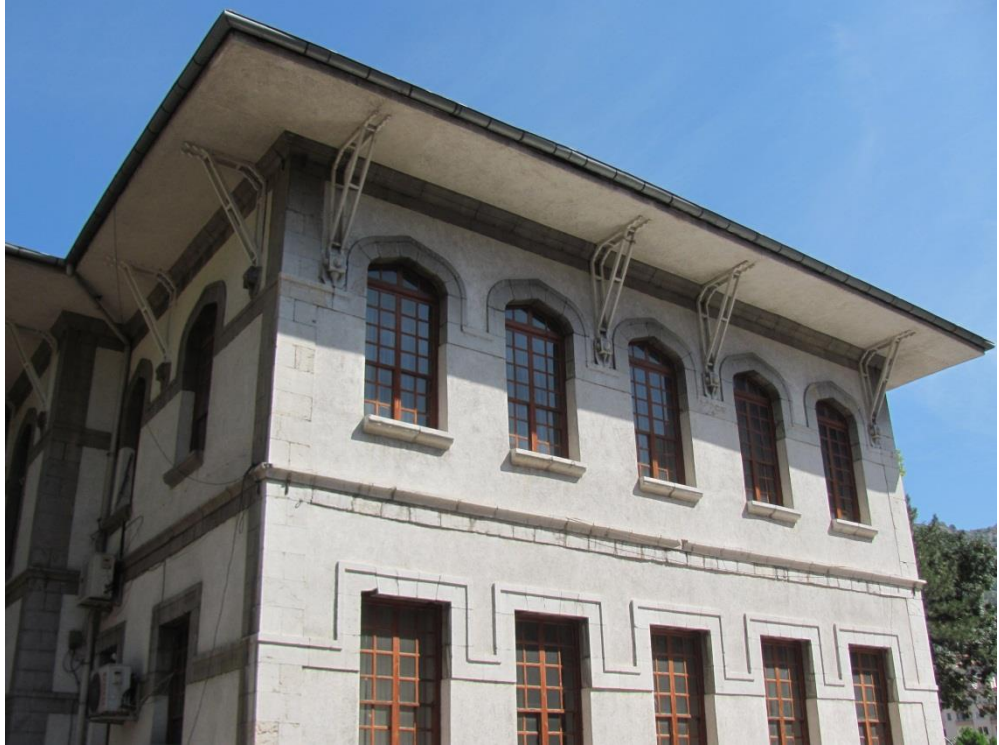
Fotoğraf 14: Belediye Eski Binası Zemin ve Birinci Kat Pencere Düzeni.
