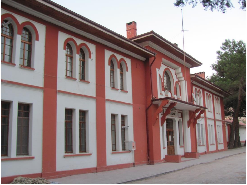
Fotoğraf 40: Amasya İstasyon Binası Güney Cephe Genel Görünüm.
