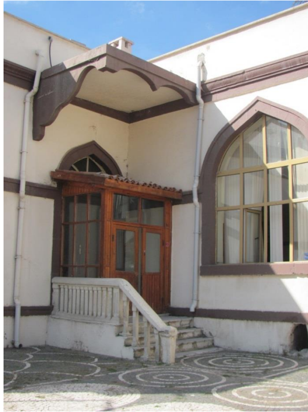
Fotoğraf 29: Kılıçarslan Mektebi Doğu Cephe Güney Kısımdaki Kapı.
