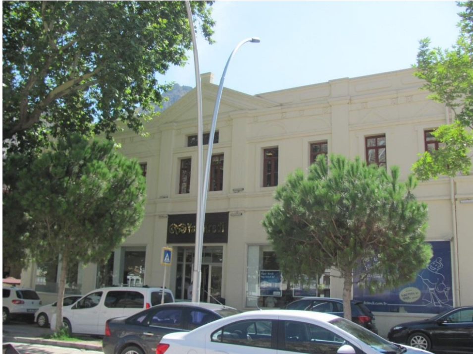
Fotoğraf 34: Adliye Eski Binası Restorasyon İle Yenilenmiş Kuzey Cephe Genel Görünüm.
