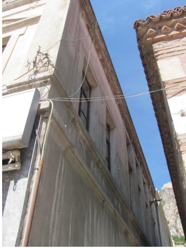
Fotoğraf 33: Adliye Eski Binası Doğu Cephe Genel Görünüm.
