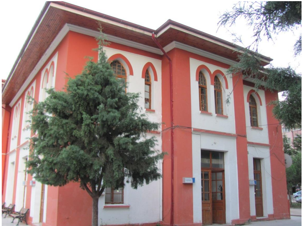
Fotoğraf 43: Amasya İstasyon Binası Batı Cephe Genel Görünüm.
