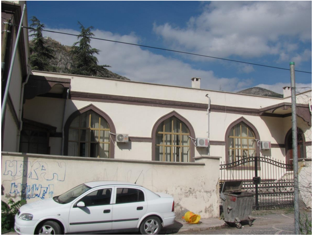
Fotoğraf 27: Kılıçarslan Mektebi Doğu Cephe Merkez Görünüm.
