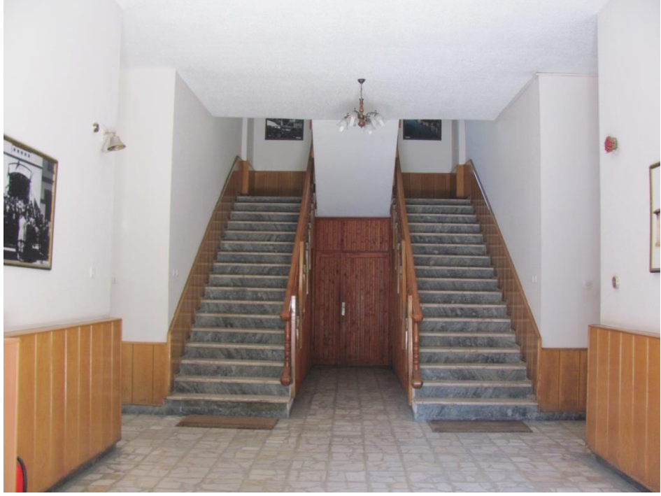
Fotoğraf 11: Belediye Eski Binası Üst Kata Çıkışı Sağlayan Çift Kollu Merdiven.
