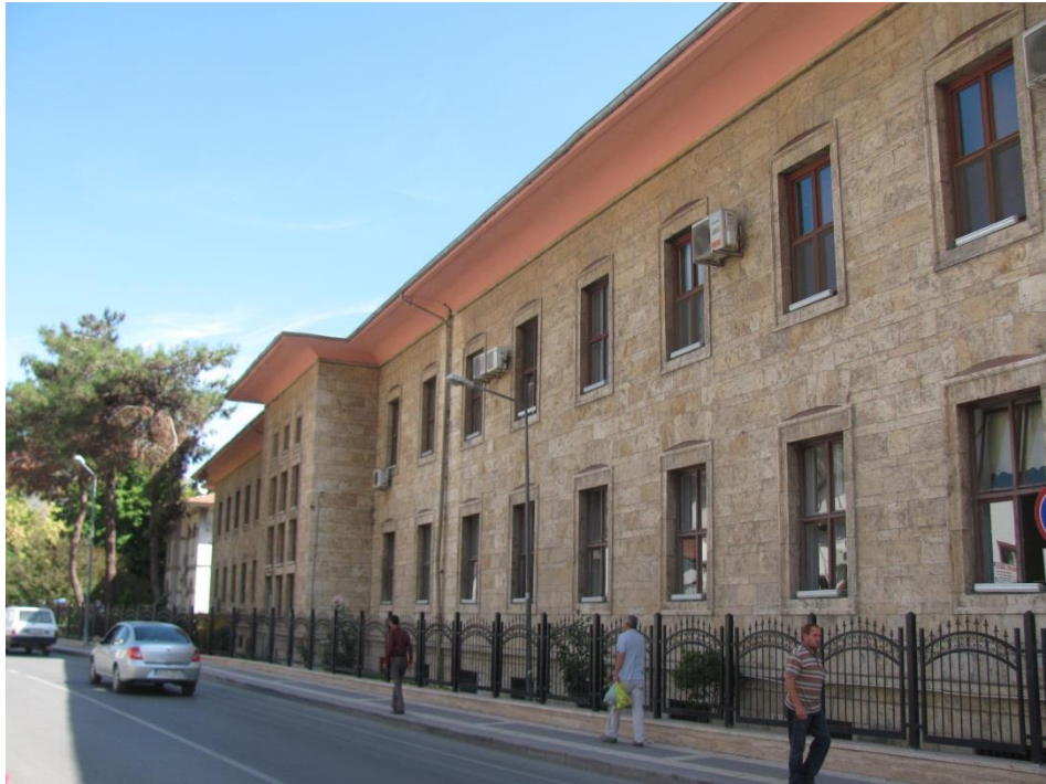
Fotoğraf 4: Valilik Binası Batı Cephe Genel Görünüm.
