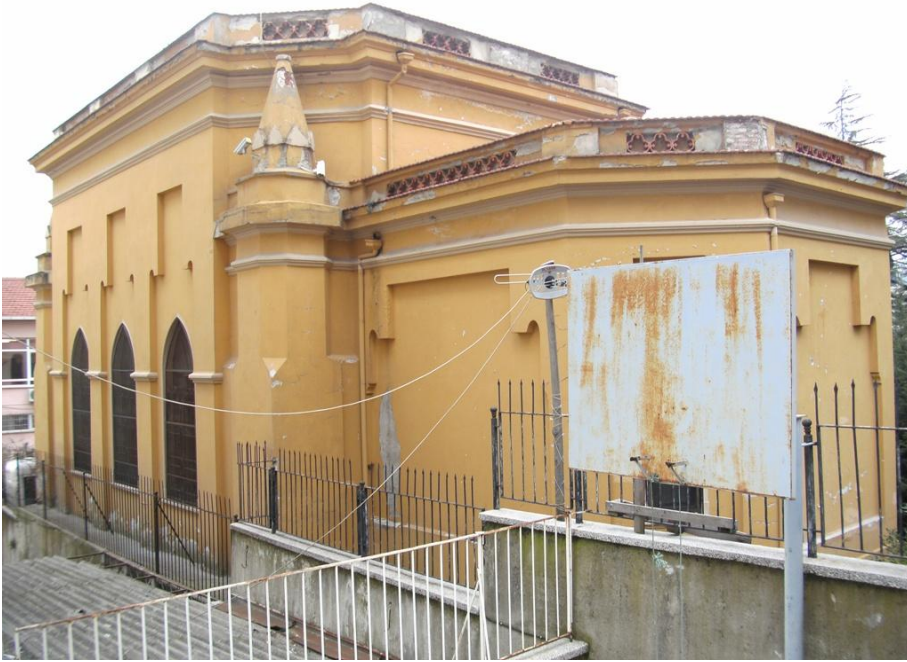
Res. 3: Fransız Katolik Kilisesi (Bursa-Merkez), güneybatı yönünden genel bakış.
