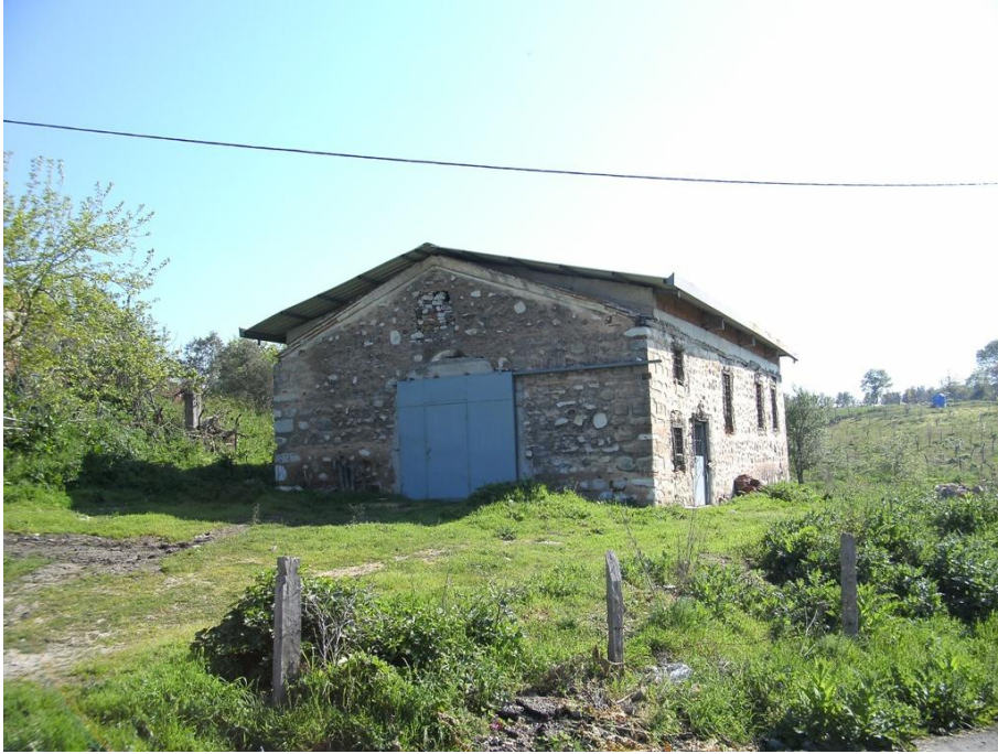
Res. 106: Hagios Ionnas Theologos Kilisesi (Nilüfer-Çatalağıl Köyü), batı cepheden genel görünüm.
