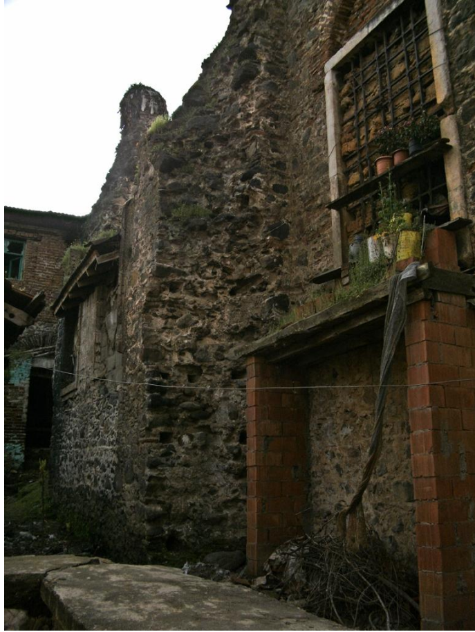
Res. 132: Yenigürle Köyü Ermeni Kilisesi (Orhangazi), kuzey cepheden genel görünüm.
