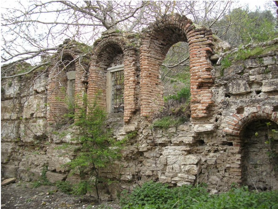
Res. 53: Hagios Georgios Kilisesi (Karacabey-Çamlıca Köyü), naosun kuzey duvarına genel bakış.
