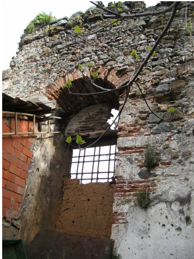
Res. 130: Yenigürle Köyü Ermeni Kilisesi (Orhangazi), kuzey duvarındaki bir pencere açıklığının naostan görünümü.
