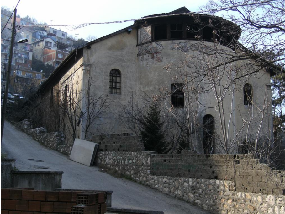
Res. 25: Taksiarhon Kilisesi (Bursa-Merkez), doğu ve güney cephelere güneybatı köşeden genel bakış.
