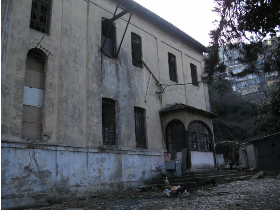
Res. 22: Taksiarhon Kilisesi (Bursa-Merkez), kuzey cephenin batı kısmı, kuzeybatı köşede giriş açıklığının bulunduğu sundurma.
