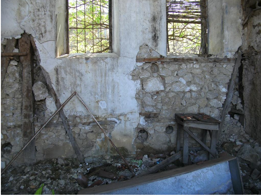
Res. 125: Hagios Paraskeva Kilisesi (Mustafakemalpaşa-Akçapınar Köyü), naosta güney duvarından ayrıntı, inşa malzemesi ve tekniği.
