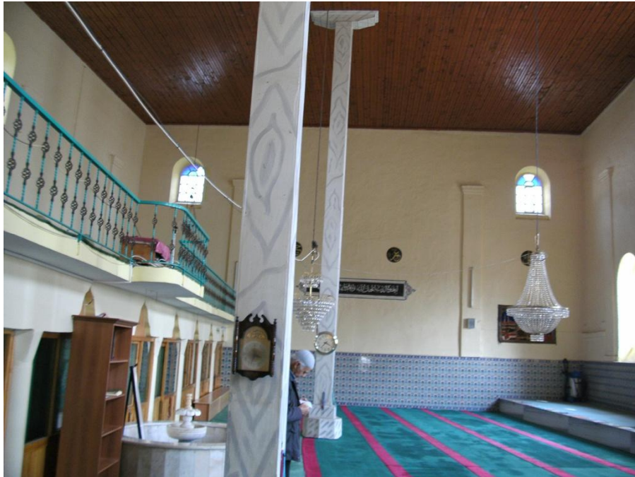
Res. 19: Mikhael Taxiarches Kilisesi (Bursa-Merkez-İsmetiye Köyü), naostan doğu yönünde genel bakış, apsisi kapatan duvar ve iki yanında bulunan duvar payeleri.
