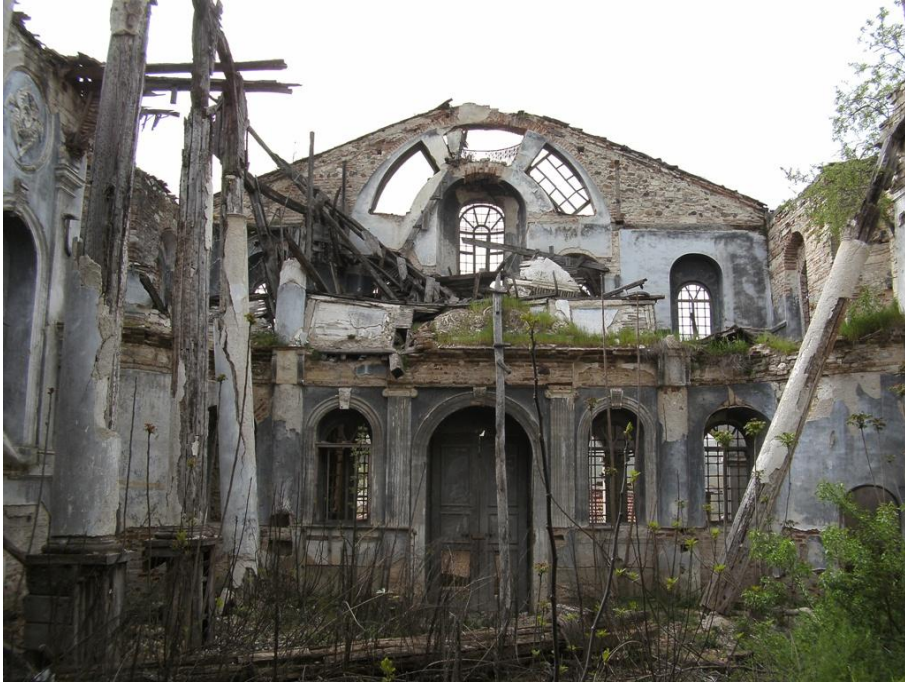
Res. 101: Agia Paraskevi Kilisesi (Mudanya-Dereköy Köyü), naostan batı duvara genel bakış, galeri katı ve merdiven kuleleri.
