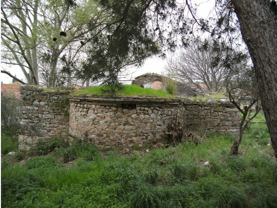
Res. 57: Hagios Theodoros Kilisesi (Karacabey-Harmanlı Köyü), doğu cephesine genel bakış.
