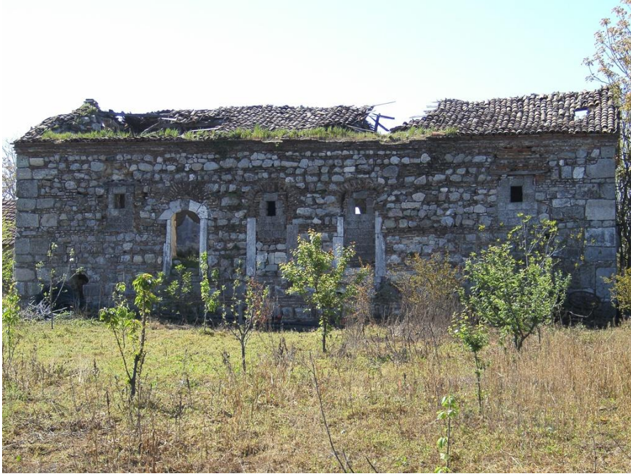
Res. 66: Mikhael Archestrategos Kilisesi (Karacabey-Uluabat Köyü), kuzey cephesine genel bakış.
