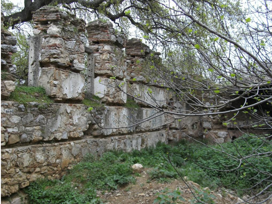
Res. 77: Zoodochos Pege Kilisesi (Karacabey-Karakoca Köyü), kuzeydoğu duvara genel bakış.
