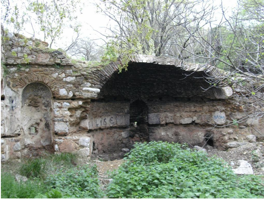
Res. 76: Zoodochos Pege Kilisesi (Karacabey-Karakoca Köyü), güneydoğu yönüne bakan apseye genel bakış.
