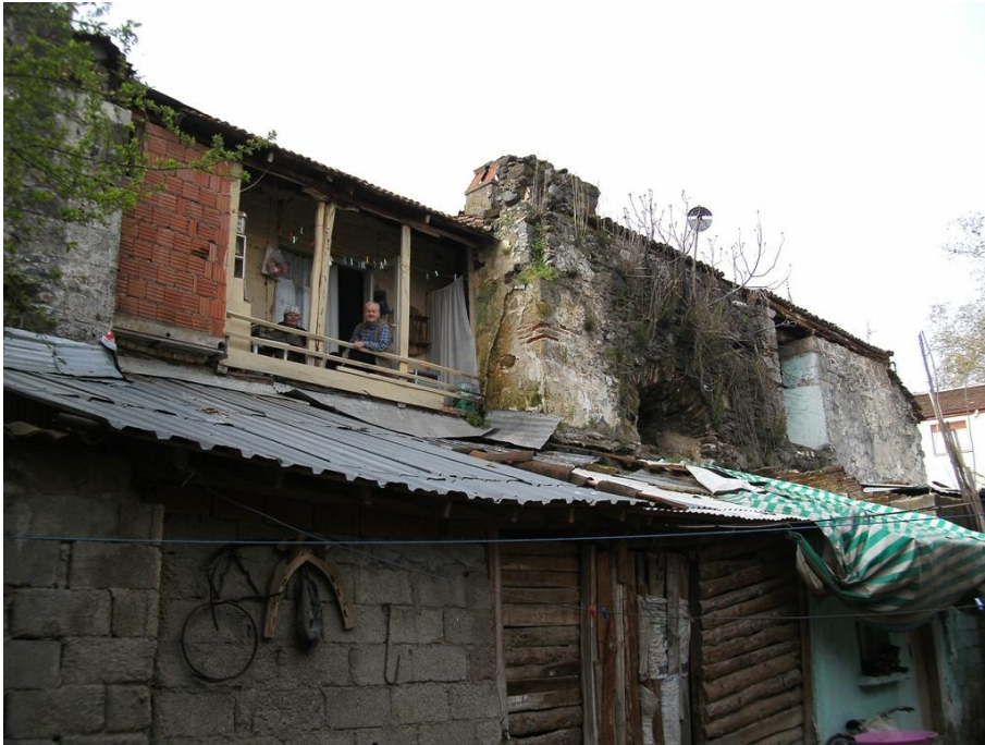
Res. 128: Yenigürle Köyü Ermeni Kilisesi (Orhangazi), güney duvarından kalan kısımların naostan genel görünümü.
