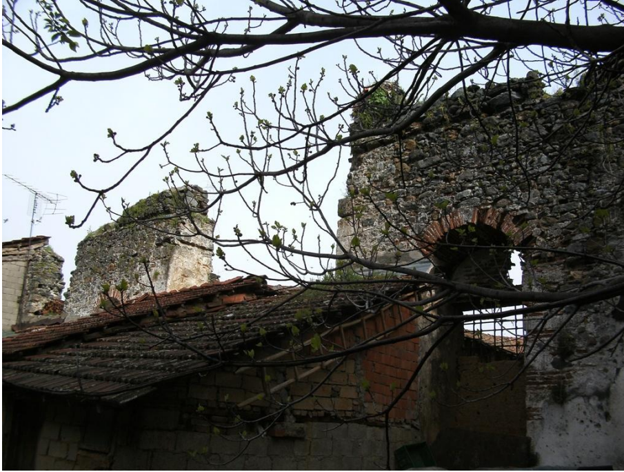
Res. 129: Yenigürle Köyü Ermeni Kilisesi (Orhangazi), kuzey duvarından kalan kısımların naostan genel görünümü.
