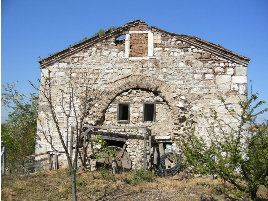
Res. 67: Mikhael Archestrategos Kilisesi (Karacabey-Uluabat Köyü), doğu cephesine genel bakış, yıkılan apsis bölümü.
