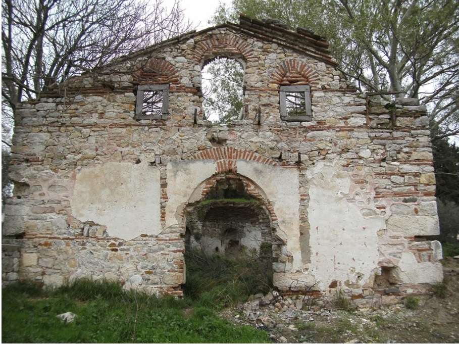
Res. 55: Hagios Theodoros Kilisesi (Karacabey-Harmanlı Köyü), batı cephesine genel bakış.
