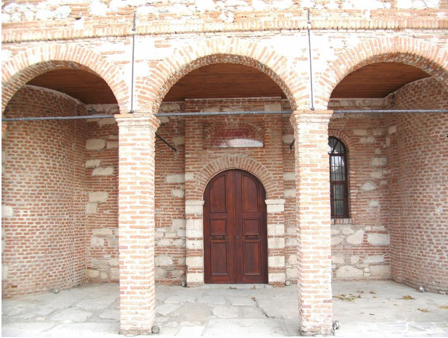
Res. 113: Agios Georgios Kilisesi (Nilüfer-Özlüce Köyü), güney cephede giriş ekseninden genel görünüm.
