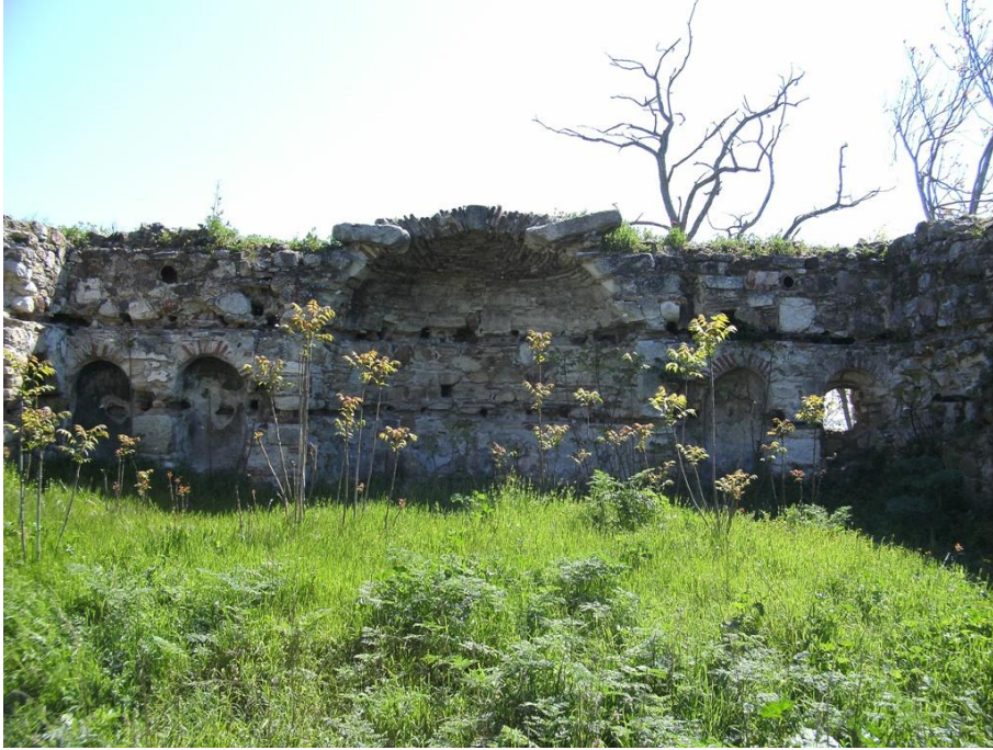
Res. 64: Mikhael Archangelos Kilisesi (Karacabey-Eskikaraağaç Köyü), naostan doğu yönüne genel bakış.
