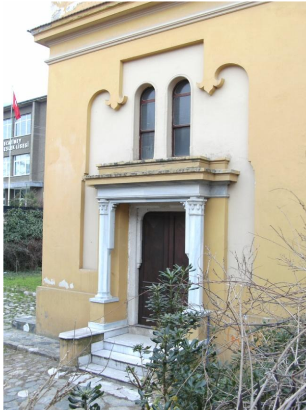
Res. 5: Fransız Katolik Kilisesi (Bursa-Merkez), kuzey cephede bulunan sundurmali girişi.
