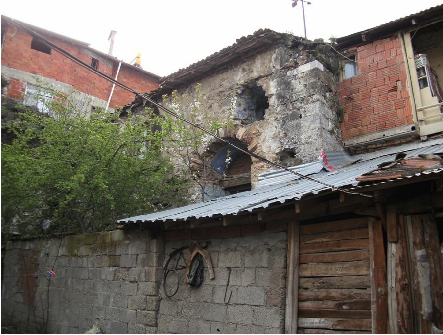
Res. 127: Yenigürle Köyü Ermeni Kilisesi (Orhangazi), güney duvarından kalan kısımların naostan genel görünümü.
