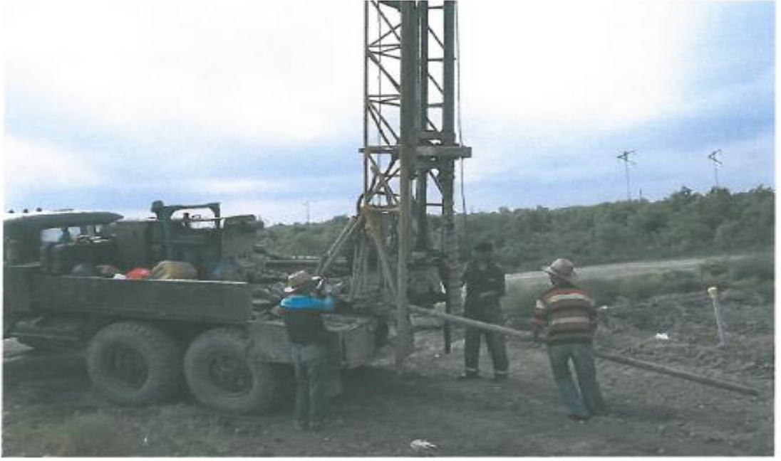
Şekil 3.14. SK 6+170 sondaj çalışması
