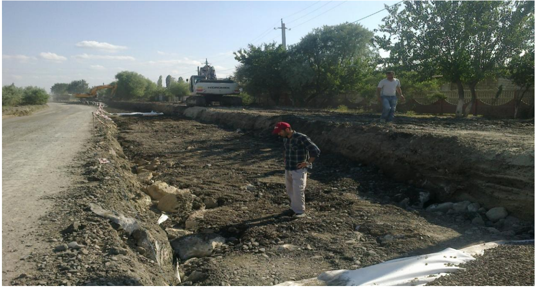
Şekil 4.6. Mevcut güzergahta (km 47+300-Sağ) geotekstil-kaya dolgu-drenaj malzemesi uygulamasından bir örnek
