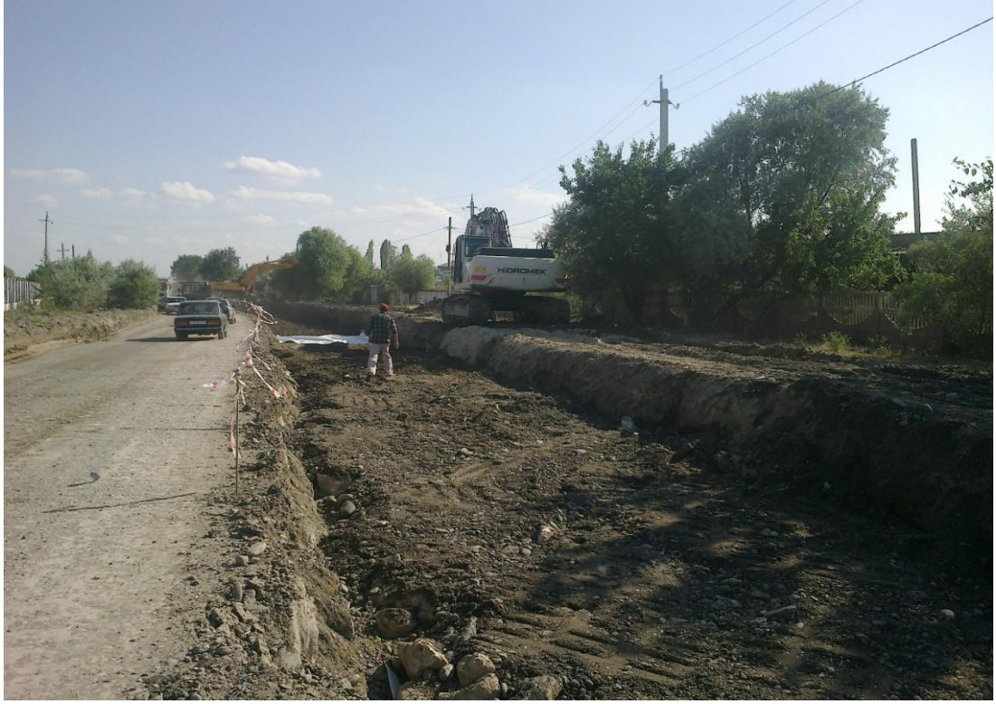
Şekil 4.7 km 47+300 - 47+700 Sağ taraf zayıf zemin kazı ve dolgu çalışmasından bir örnek
