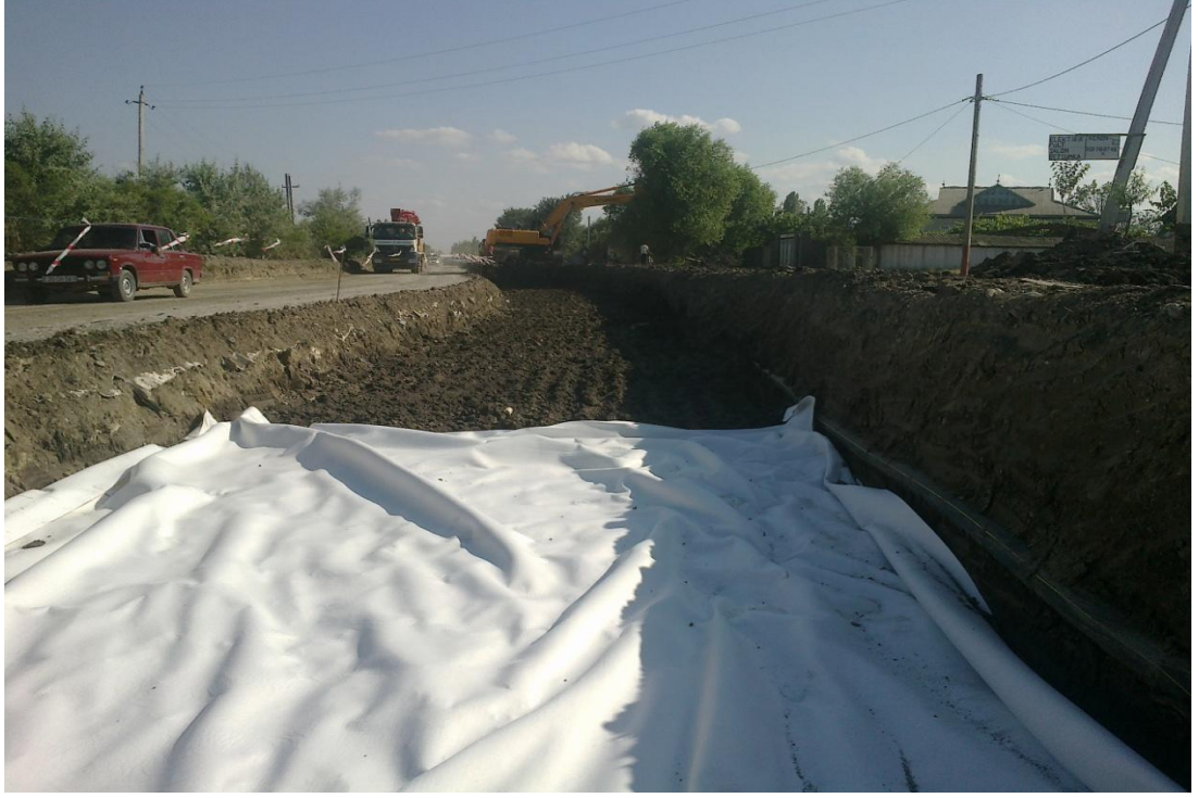
Şekil 4.5. Zayıf zemin üzerine geotekstil (ayırma membranı) uygulaması
