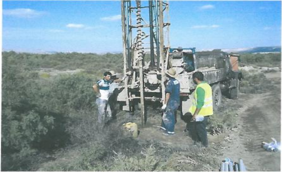
Şekil 3.13. SK 3+170 sondaj çalışması
