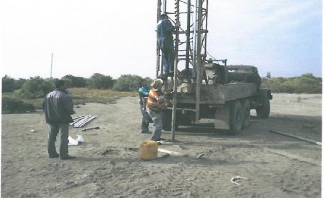
Şekil 3.10. SK 0+550 sondaj çalışması
