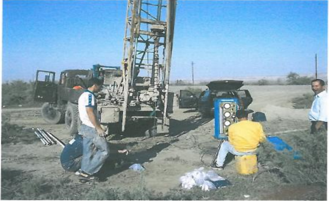
Şekil 3.12. SK 2+650 sondaj çalışması
