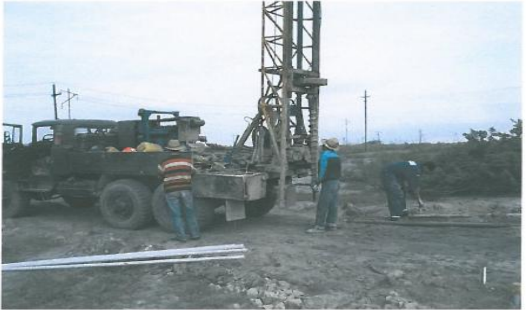
Şekil 3.11. SK 1+550 sondaj çalışması
