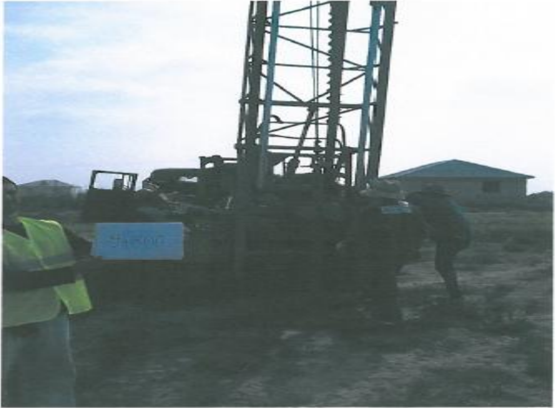
Şekil 3.15. SK 9+800 sondaj çalışması
