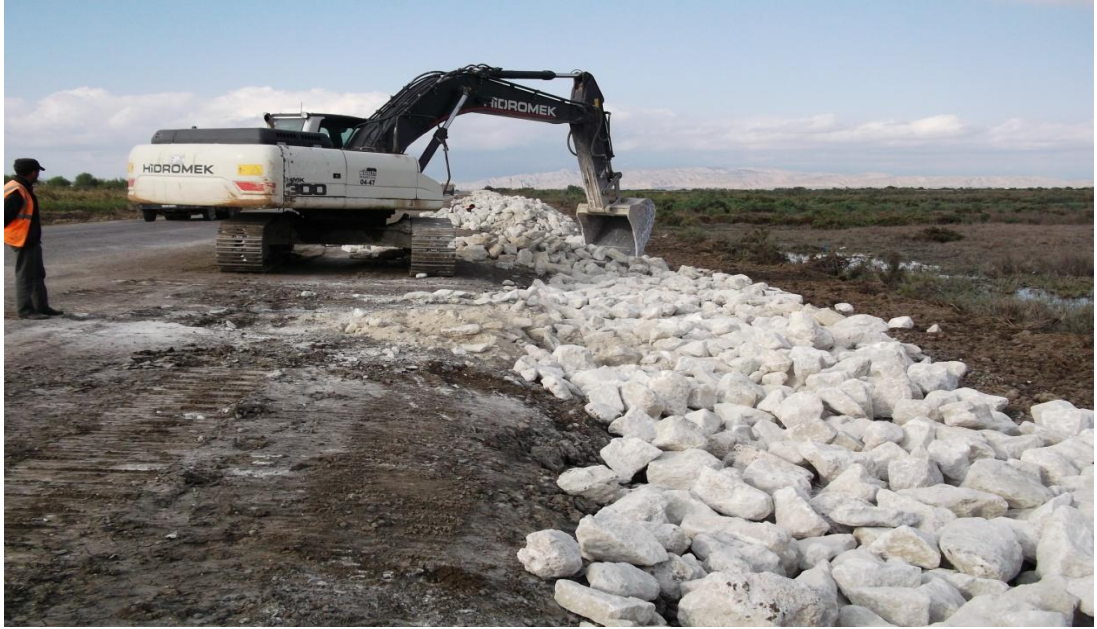
Şekil 3.17. Yol güzergahındaki (km 3+600 banket) kaya dolgu iyileştirmesi
