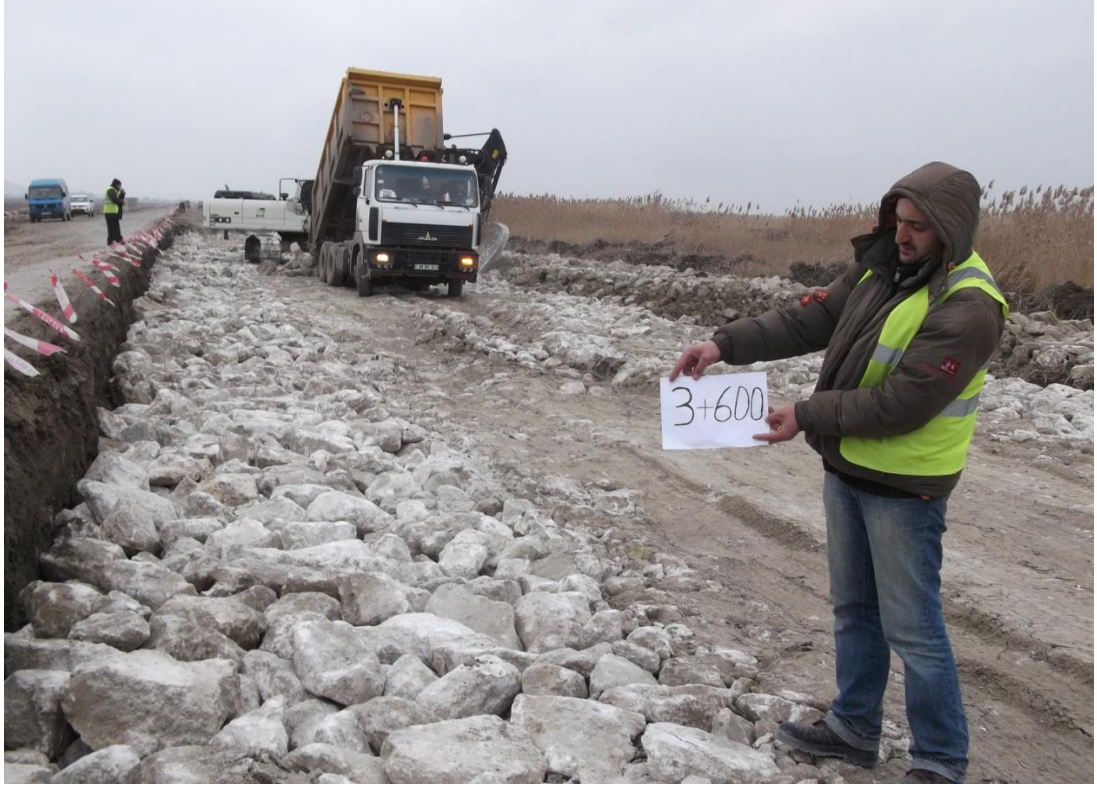
Şekil 3.16. Yol güzergahındaki (km 3+600 gövde) kaya dolgu iyileştirmesi
