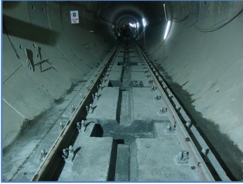
Şekil 5.1 : İnşaat aşamasından yerinde döküm doğrudan tespitli sistem.
