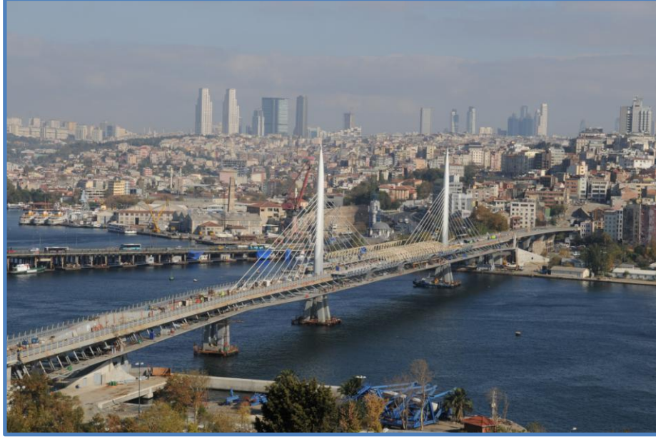
Şekil 6.12 : Taksim Metrosu Haliç Metro Geçiş Köprüsü.
