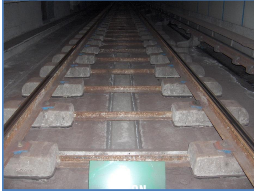
Şekil 2.12 : Nabla bağlantı sistemi kullanılarak döşenmiş ray hattı.
