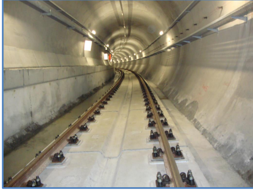
Şekil 5.3 : Tünel içinde plakalı tip üstyapının döşenmiş son hali.
