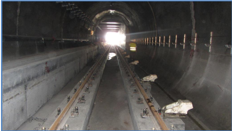
Şekil 6.10 : Vossloh Sistem 336 tip bağlantı sisteminin hattan görünümü.
