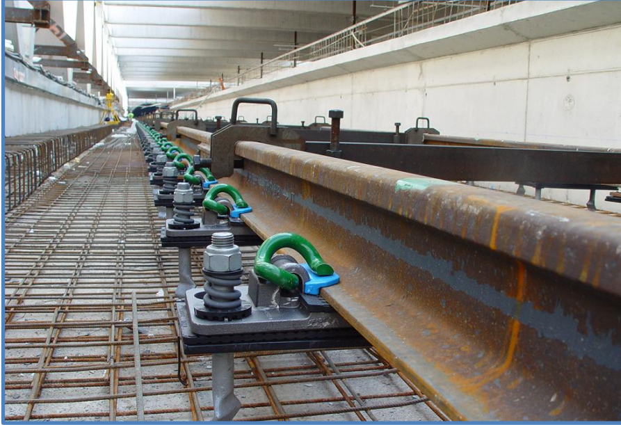
Şekil 2.14 : Pandrol bağlantı elemanı kullanılarak döşenen ray hattı.
