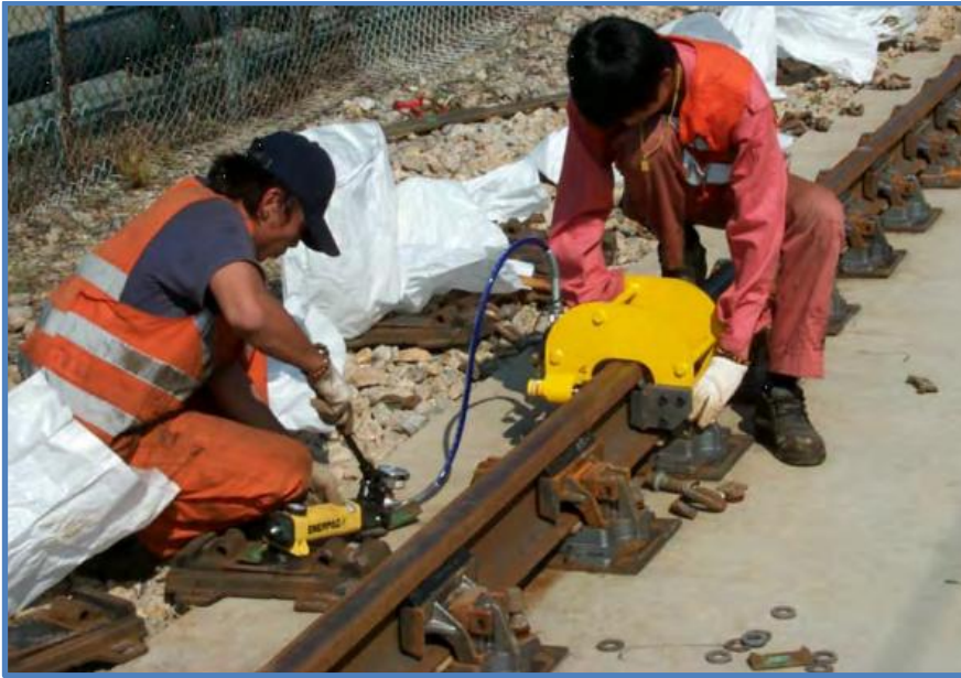
Şekil 6.15 : Pandrol Vanguard bağlantı sistemi monte-demonte el aletinin kullanılması[34].
