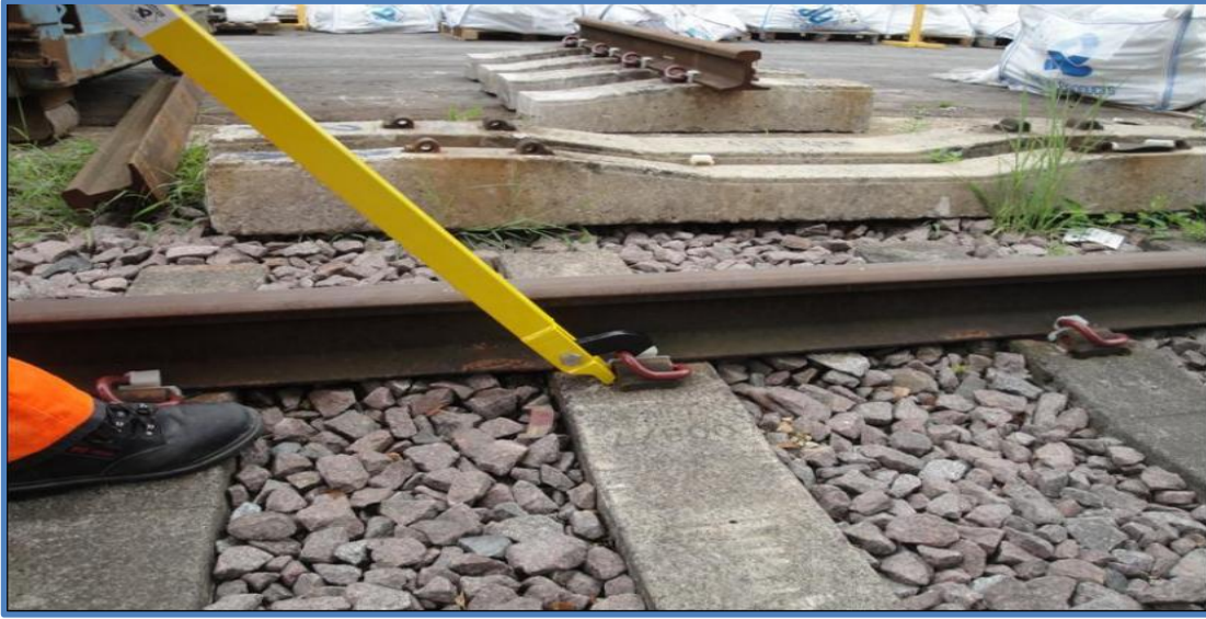
Şekil 5.8 : Pandrol e-klips bağlantı sisteminin montaj ve demontaj işlemi için “panpuller” aletinin kullanılması[20].
