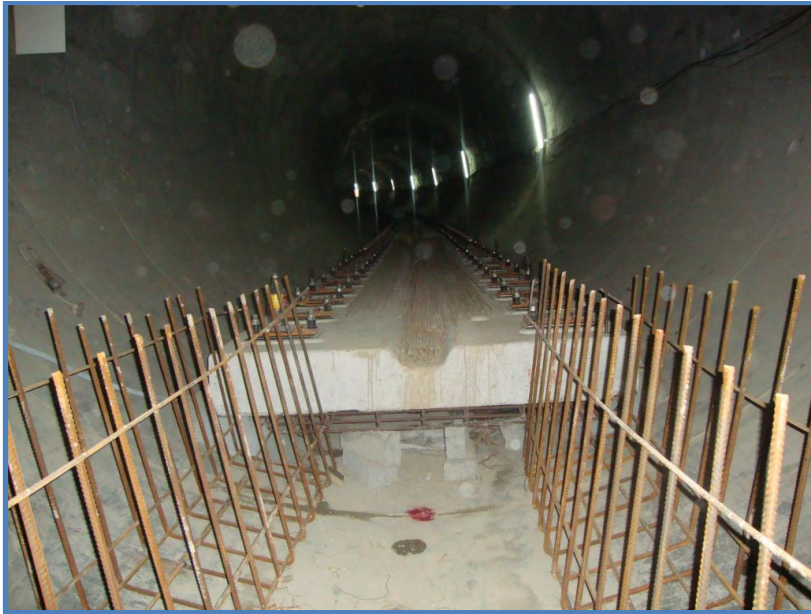
Şekil 5.2 : İnşaat aşamasından ana hat üzerinde kullanılan plakalı tip üstyapı kesiti.
