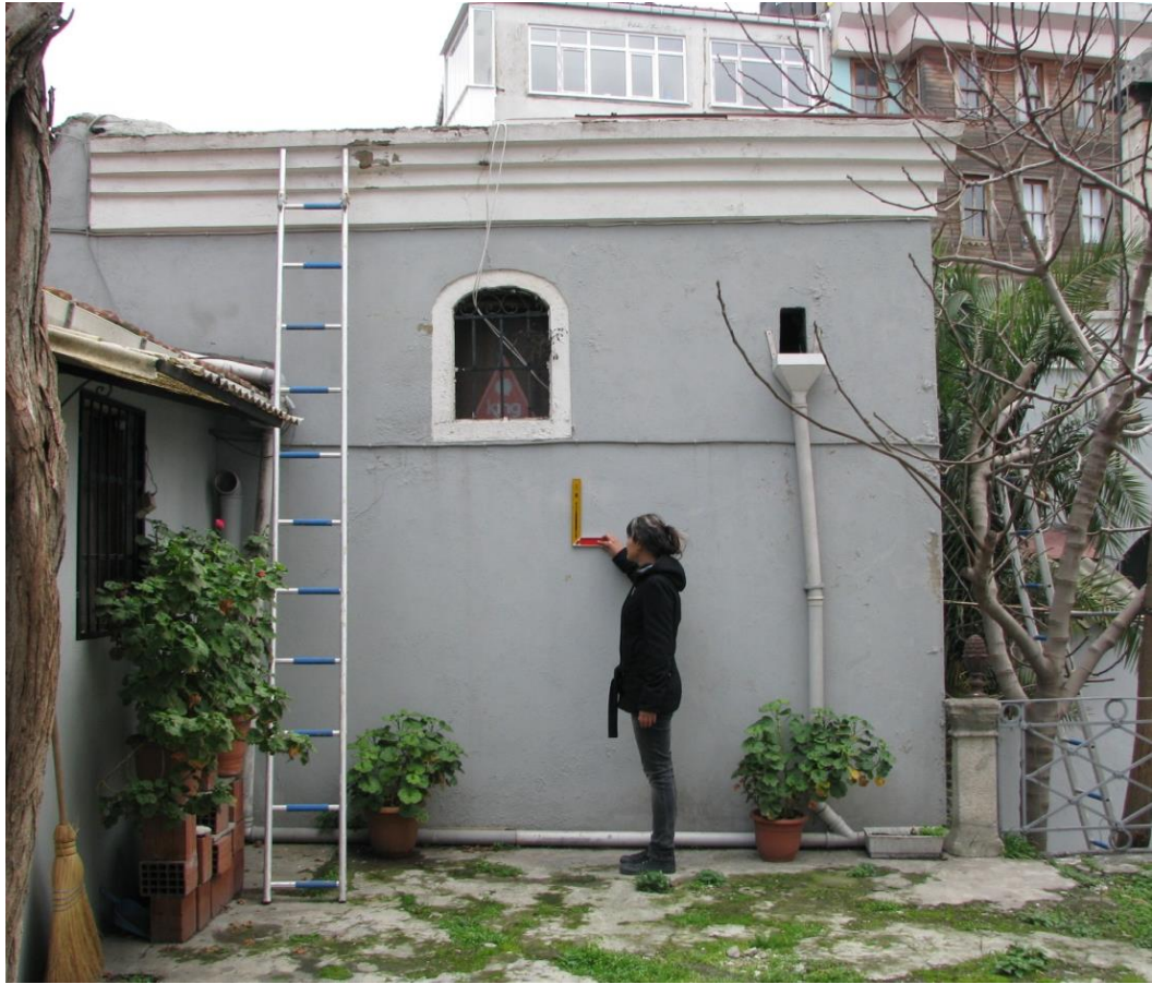
Şekil B.75 : Kuzeydoğu yönündeki dükkanın kuzeybatı duvarı.
