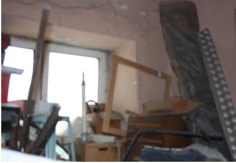
Şekil B.117 : Kuzeydoğu yönündeki ilk dükkanın üst kat kuzeydoğu duvarı.
