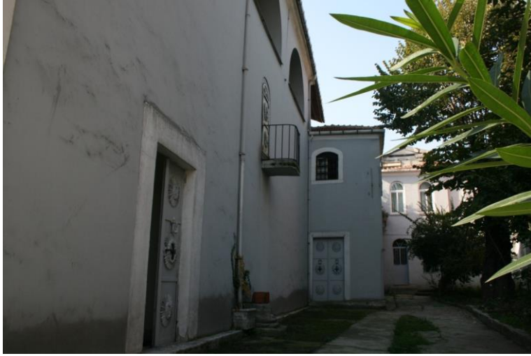
Şekil B.100 : Kuzeydoğu cephesi.
