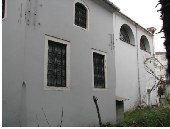
Şekil B.105 : Güneybatı cephesi.
