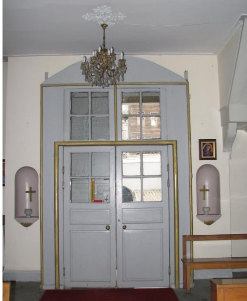
Şekil B.2 : Güneydoğu duvarından nartekse açılan ahşap kapı.
