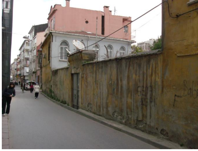
Şekil B.82 : Kilise avlu duvarı kuzeybatı sokak görünüşü.
