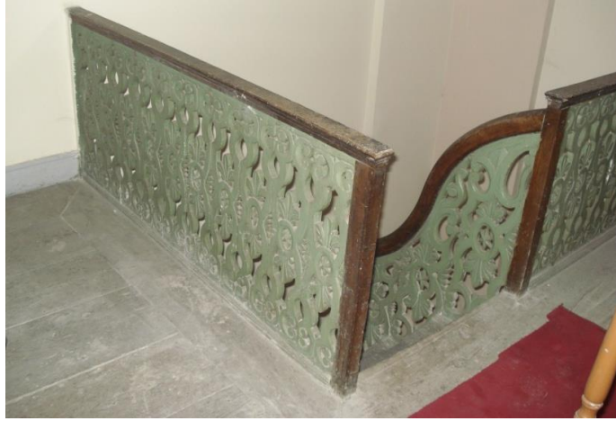
Şekil B.50 : Galeri katı demir merdiven korkuluğu ve ahşap küpeşte.
