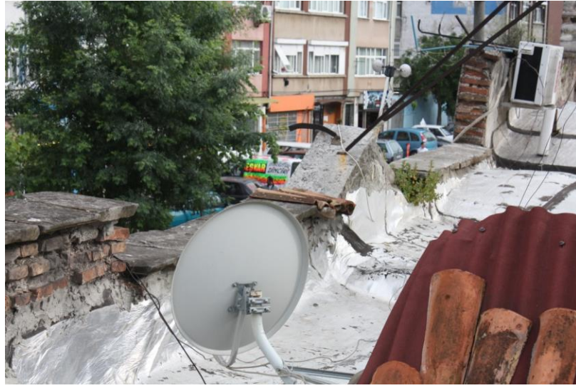
Şekil B.109 : Kilise girişi çatı görünüşü.
