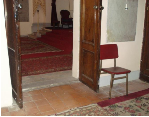
Şekil B.34 : Soyunma odası karo mozaik zemin kaplaması.
