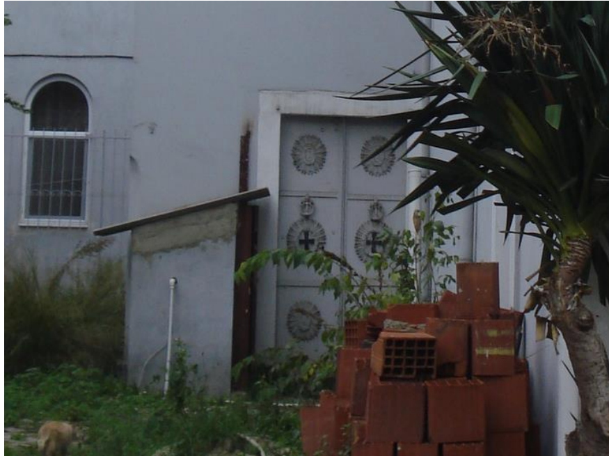
Şekil B.93 : Güneydoğu cephesi vaftiz odası duvarına bitişik su deposu.
