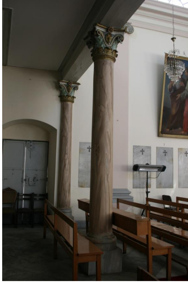
Şekil B.6 : Narteksi sınırlandıran korint başlıklı ahşap sütunlar.
