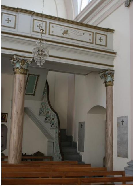
Şekil B.49 : Narteksin üzerindeki galeri korkuluğu.
