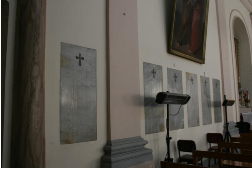
Şekil B.16 : Güneybatı duvarındaki mermer levhalar.
