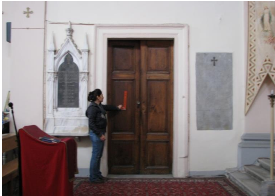
Şekil B.24 : Koro alanına açılan vaftizhane giriş kapısı.
