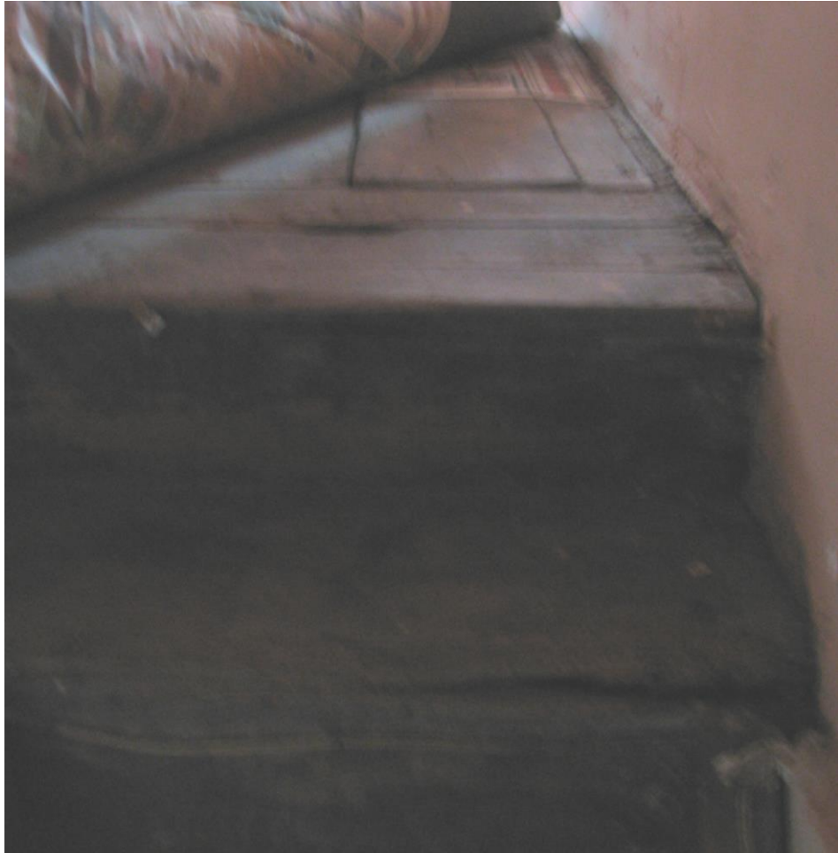
Şekil B.115 : Dükkan ikinci katı ahşap döşemesi.
