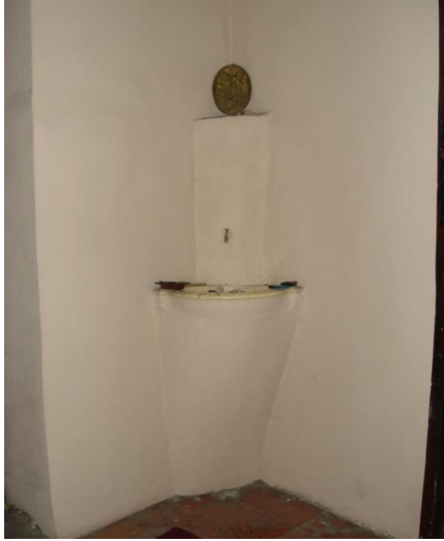
Şekil B.36 : Soyunma odası güneydoğu duvarı el yıkama bölümü.
