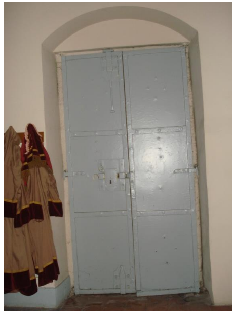
Şekil B.35 : Soyunma odası güneydoğu duvarındaki demir kapı.
