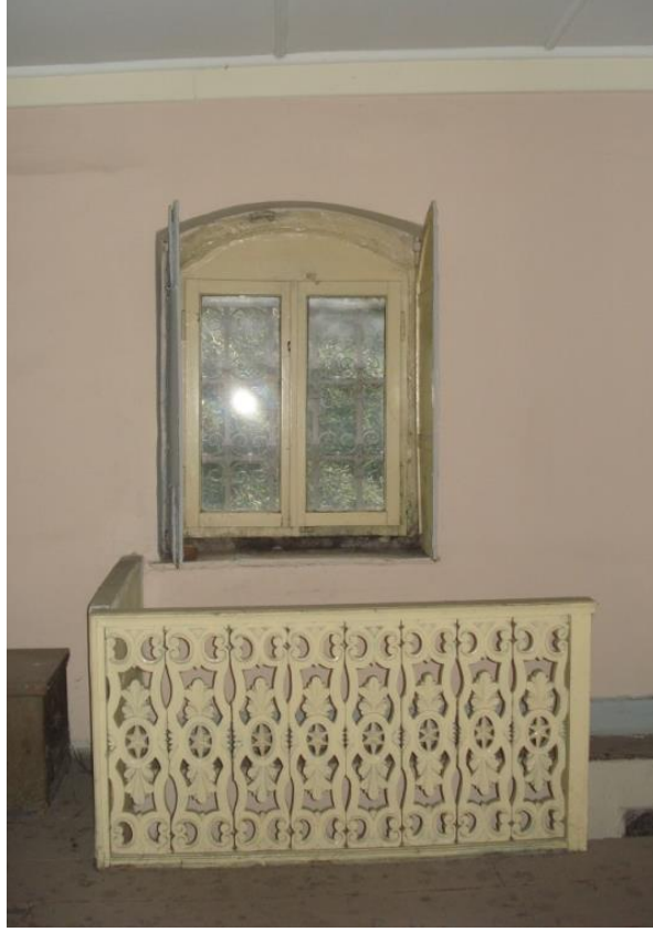
Şekil B.57 : Kuzeydoğu balkonu demir korkuluk.
