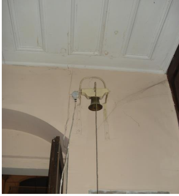
Şekil B.40 : Soyunma odası ahşap tavan kaplaması.
