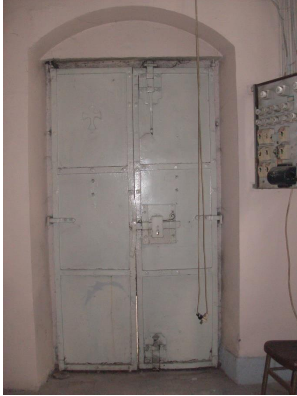
Şekil B.43 : Vaftiz odası güneydoğu duvarındaki demir kapı.
