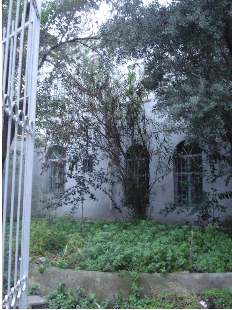
Şekil B.88 : Papaz evi güneybatı cephesi.
