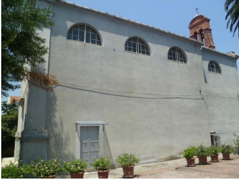
Şekil 7.3 : Güneydoğu yan cephe.
