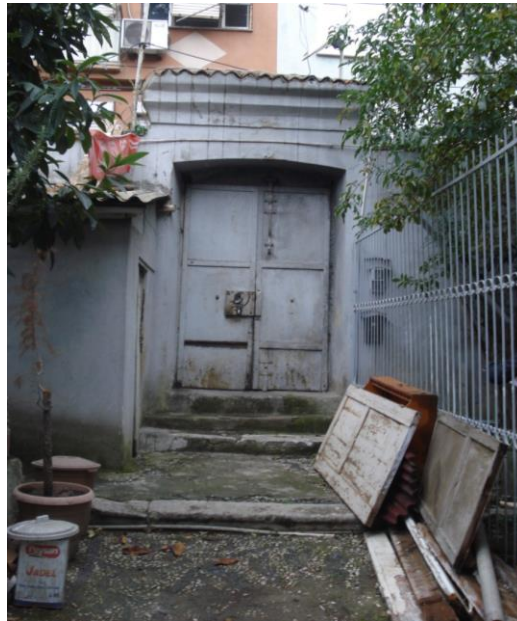
Şekil B.80 : Kuzeybatı bahçe giriş kapısı.
