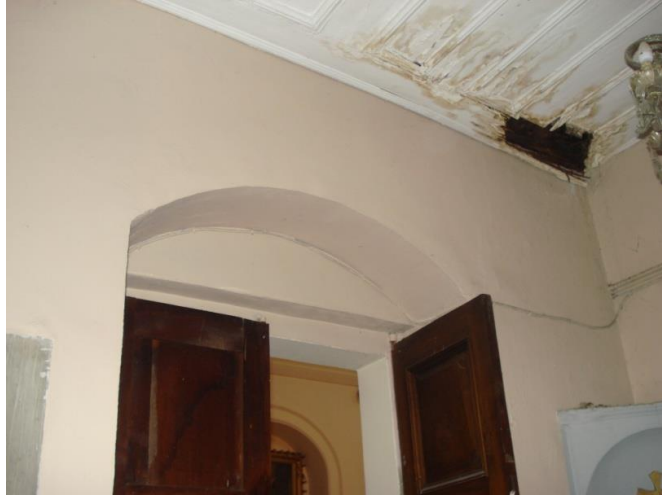
Şekil B.41 : Vaftiz odası kapı kemerleri ve çürüyen tavan kaplaması.
