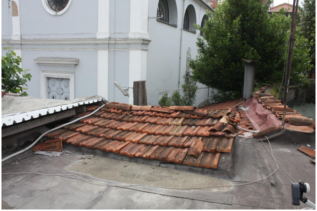
Şekil 7.14: Caddeye açılan kuzeydoğu yönündeki ilk dükkanın teras çatısı.
