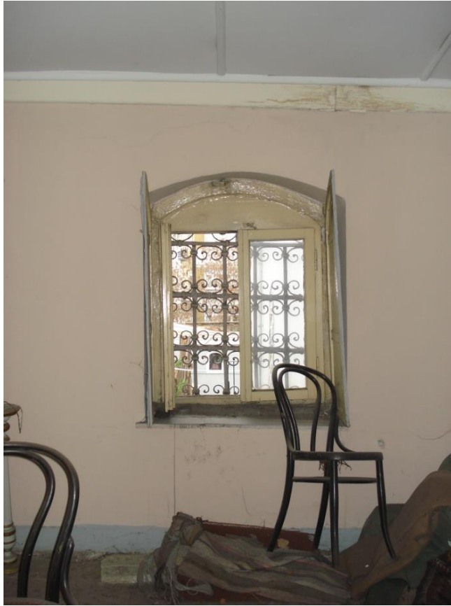
Şekil B.58 : Kuzeydoğu balkonu güneydoğu duvarı.
