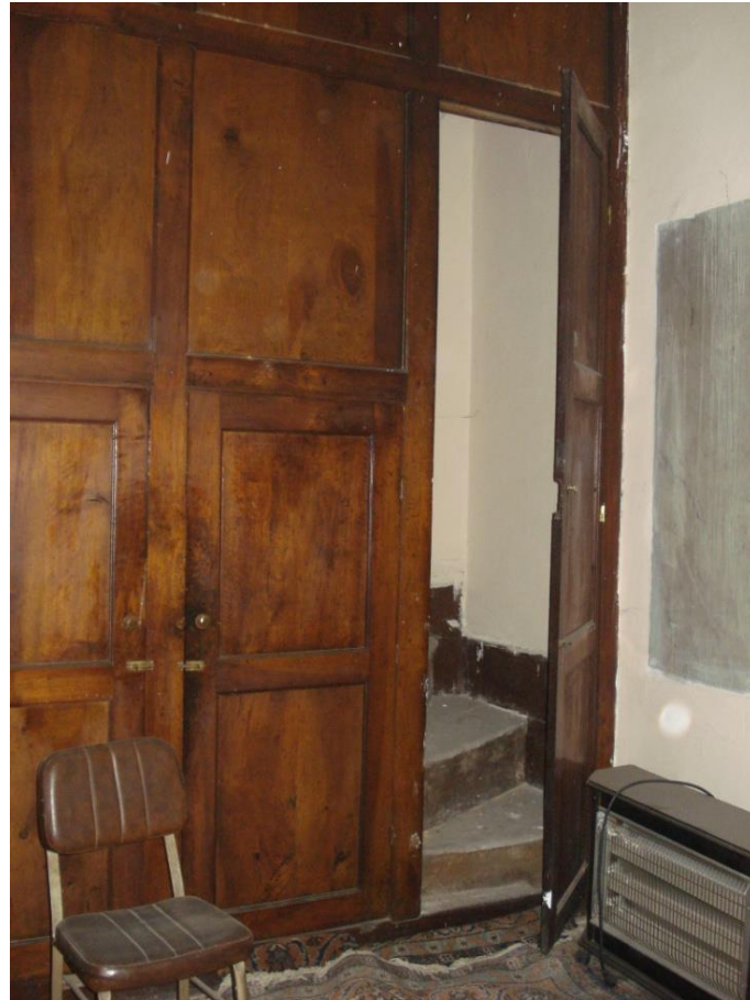
Şekil B.46 : Vaftiz odasındaki ahşap dolap ve ahşap merdivene bağlantı.
