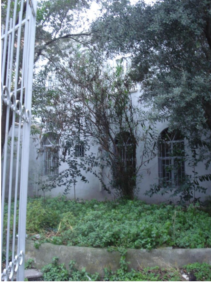
Şekil B.86 : Papaz evi güneybatı cephesi.
