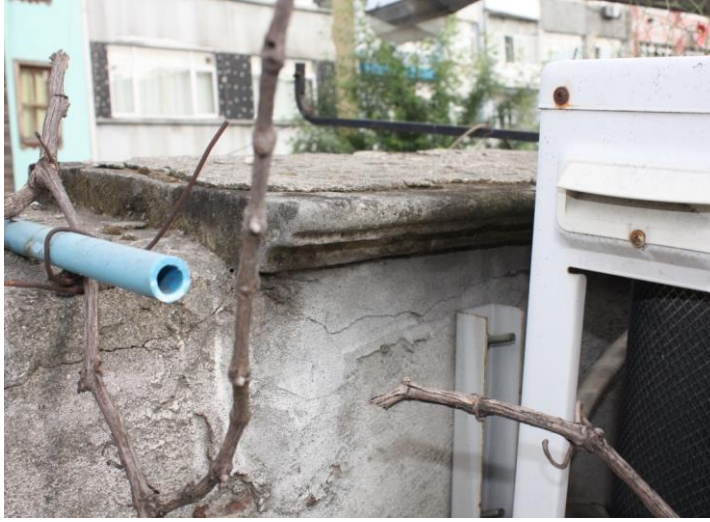
Şekil B.112 : Giriş duvarı özgün taş harpuşa.
