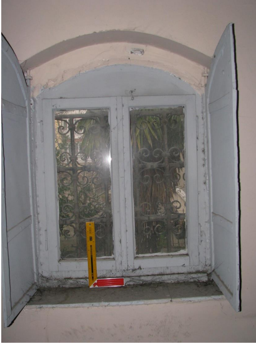
Şekil B.63 : Güneybatı balkonundaki demir kapaklı ahşap doğrama.
