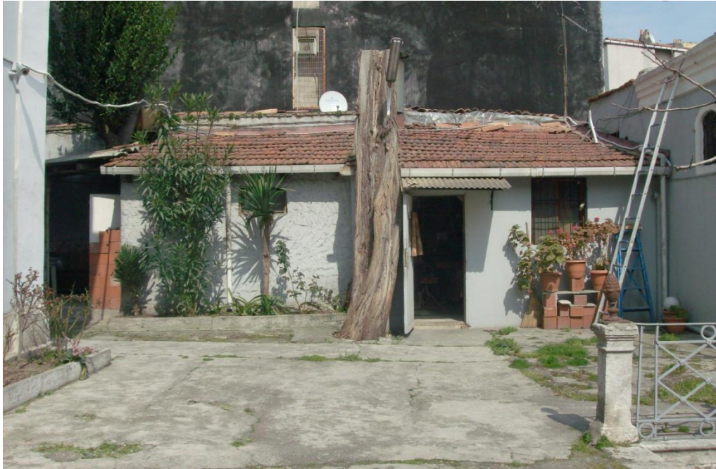
Şekil B.89 : Avlunun kuzeydoğu duvarına bitişik tek katlı tuğla ek.
