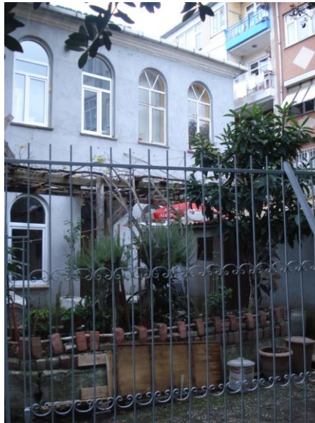
Şekil B.104 : Konut yapısı kuzeydoğu cephesi.
