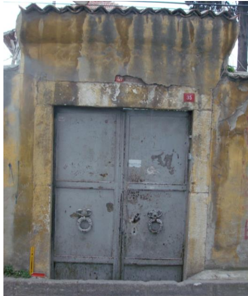
Şekil B.83 : Kuzeybatı cephesi avlu kapısı.
