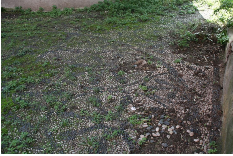
Şekil B.81 : Apsis duvarı zeminindeki çakıltaşı mozaik zemin kaplaması.
