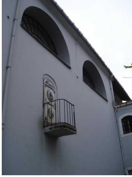
Şekil B.102 : Kuzeydoğu cephesi, vaaz kürsüsüne açılan demir kapı.
