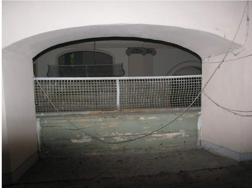
Şekil B.61 : Güneybatı balkonu iç mekandan bakış.
