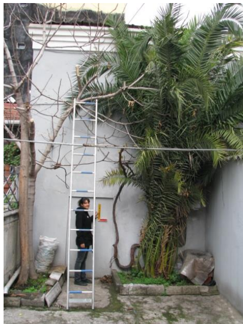
řekil B.71 : Kuzeydoęu dükkan birimi güneybatı duvarı.
