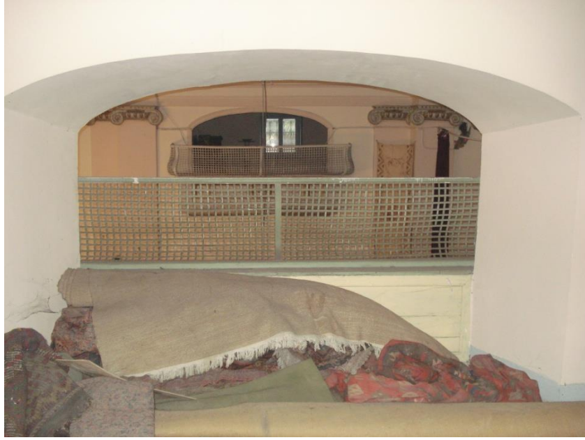
Şekil B.55 : Kuzeydoğu balkonu iç mekandan bakış.
