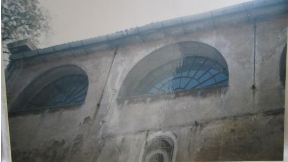
Şekil 6.3 : Kilisenin kuzeydoğu duvarındaki gergi ve kılıçlar (Kaynak: İ.K.T.V.K.K arşivi, 1992)
