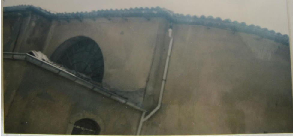
Şekil 6.2 : Kilisenin kuzeydoğu duvarı, alaturka kiremit çatı örtüsü (Kaynak: İ.K.T.V.K.K arşivi, 1992)
