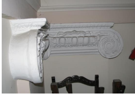
Şekil B.4 : İyonik pilastr başlıkları.
