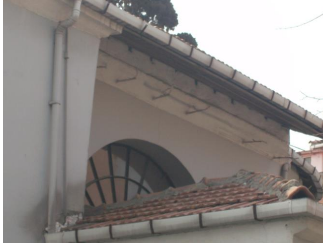
Şekil B.103 : Kuzeydoğu cephesi , naosa açılan lünet pencere.
