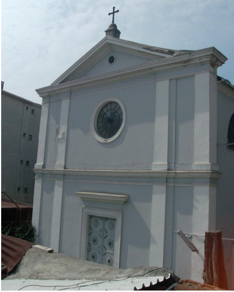
Şekil B.90 : Güneydoğu cephesi genel görünüş.
