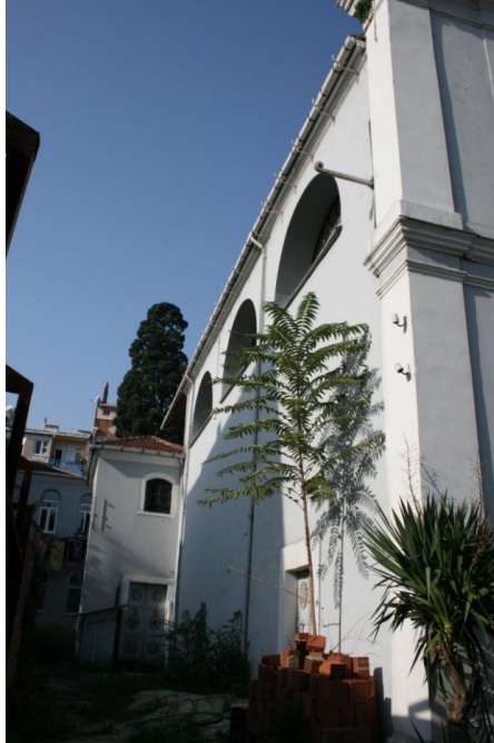
Şekil B.107 : Güneybatı cephesi.
