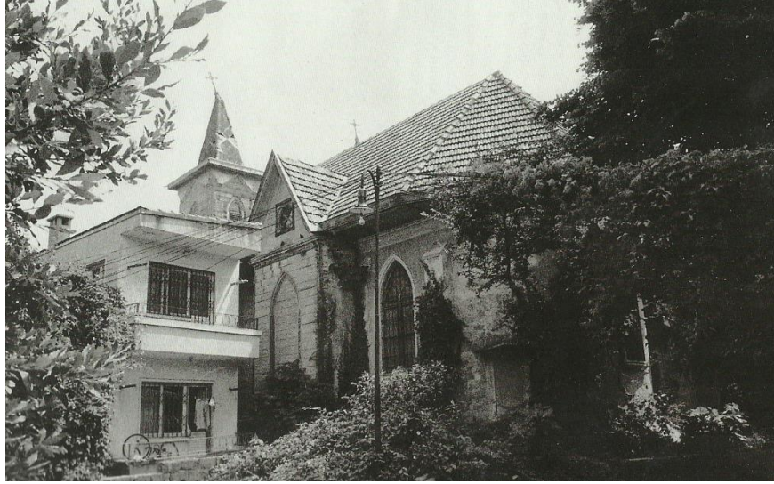
Şekil 3.11 : Surp Andon Kilisesi 7 .
