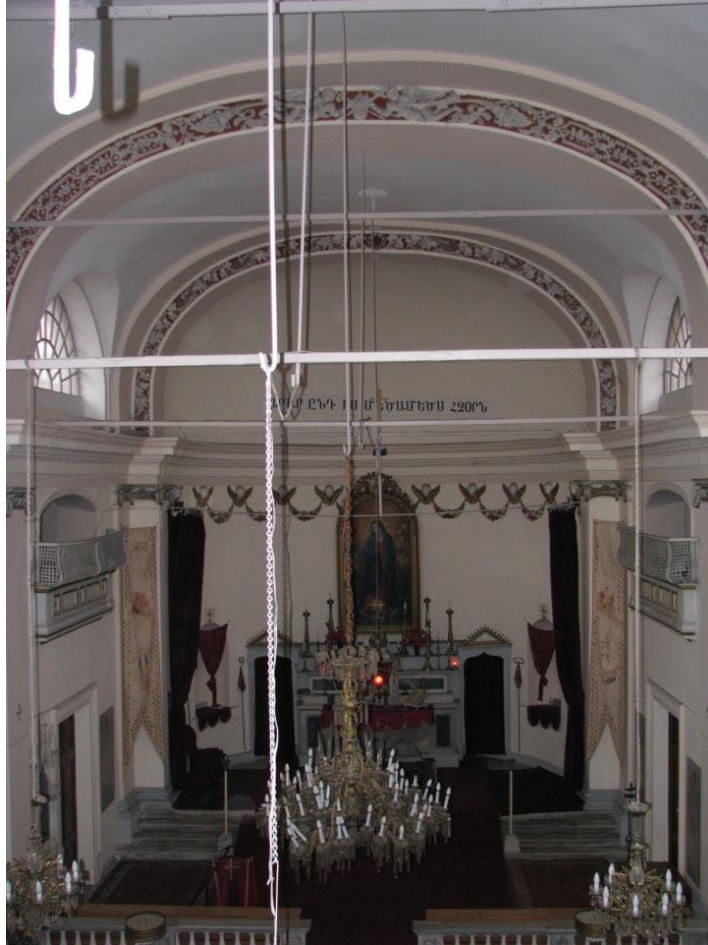
Şekil B.15 : Tonoz genişliğince devam eden demir gergiler.
