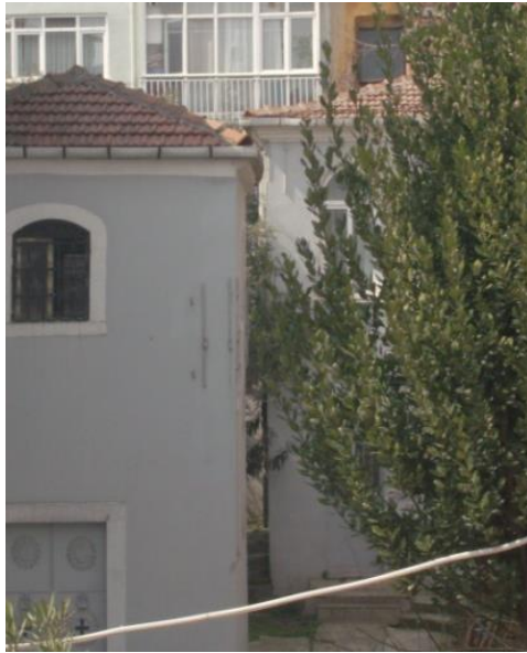
Şekil B.96 : Güneydoğu cephesi soyunma odası ve kuzeydoğu balkonu.
