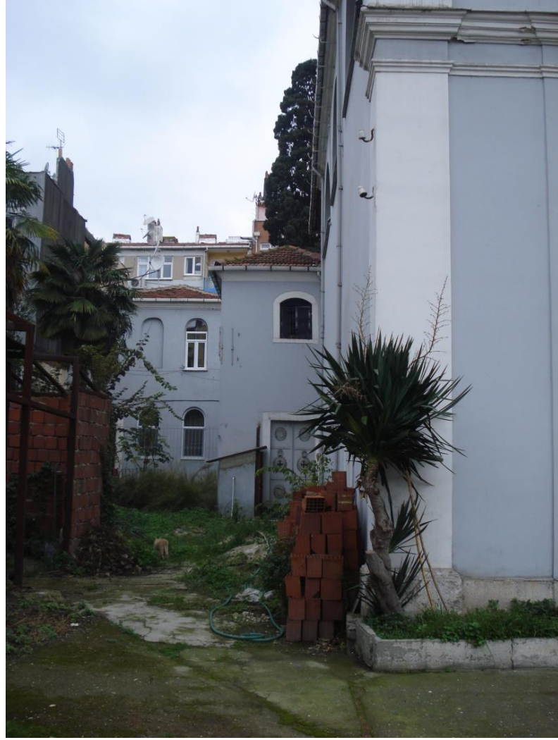
Şekil B.92 : Güneydoğu cephesi vaftiz odası ve konut yapısı.
