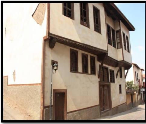
Şekil 60: Halit Sokak, 242 Ada, 9 Parseldeki Konutun Ön Görünüşü
