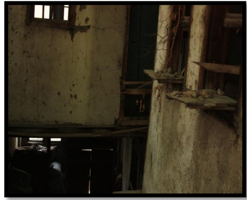
Şekil 61: Halit Sokak, 242 Ada, 9 Parseldeki Konutun İç Görünüşü
