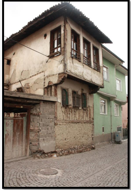
Şekil 40: Bey Sokak/73 Ada 30 Parsel Konut Fotoğrafı
