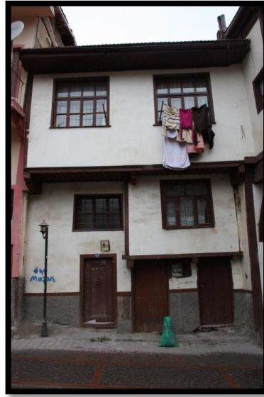
Şekil 58: Halit Sokak, 241 Ada, 2 Parseldeki Konutun Ön Görünüşü
