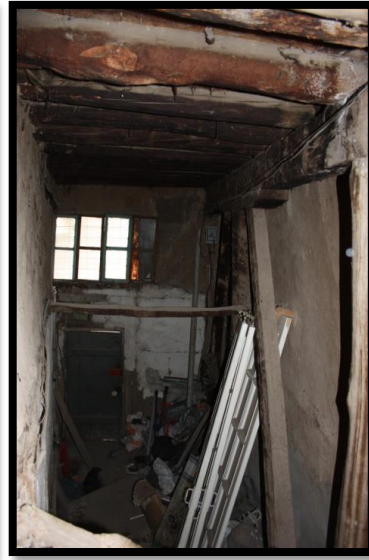
Şekil 59: Halit Sokak, 241 Ada, 2 Parseldeki Konutun İç Görünüşü
