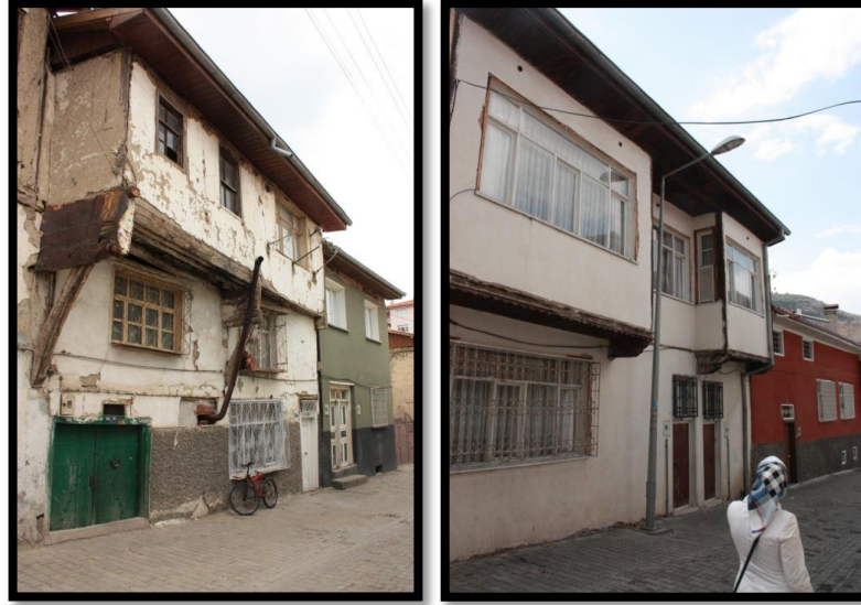
Şekil 82-83: Beyhamam Sokak, 71 Ada- 60 ve 71 Ada- 67 Parsel Konut Ön Cephe Özgün Olmayan Kapı- Pencere Oranları
