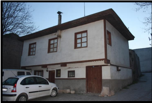
Şekil 62: Halit Sokak, 240 Ada, 3 Parseldeki Konutun Ön Görünüşü
