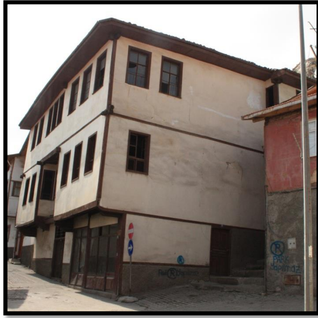
Şekil 64: Halit Sokak, 242 Ada, 1 Parseldeki Konutun Ön Görünüşü
