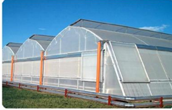
Şekil 2.4. Seranın dış görünüşü
