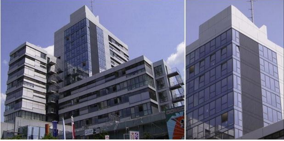
Şekil 4.3. Erlangen Belediyesi binası önünde kurulmuş güneş duvarı [10]
