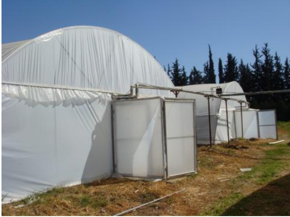
Şekil 3.1. Denemenin gerçekleştirildiği UV+IR+Antidrop katkılı plastik örtülü 360 m 2 alana sahip seranın görüntüsü (öndeki sera)
