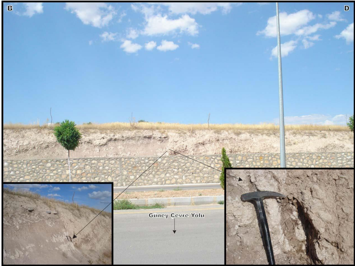
Şekil 3.40 Yeniköy Fay Seti'nin görünüşü (bakış kuzeydoğuya, Rızvan Tepe güneyi)
