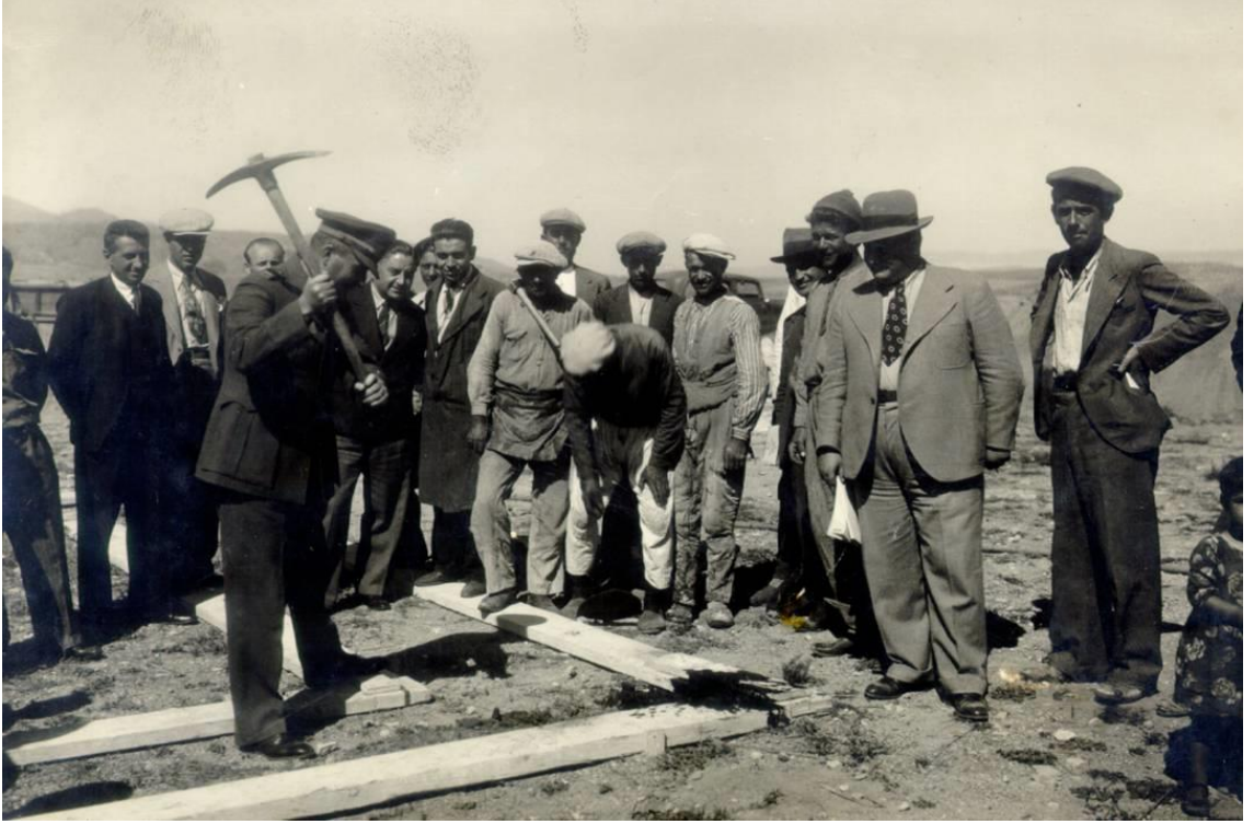
EK 22. Kayseri Tayyare Fabrikası Temel Atma. ( Kaynak: Emre Uçar)
